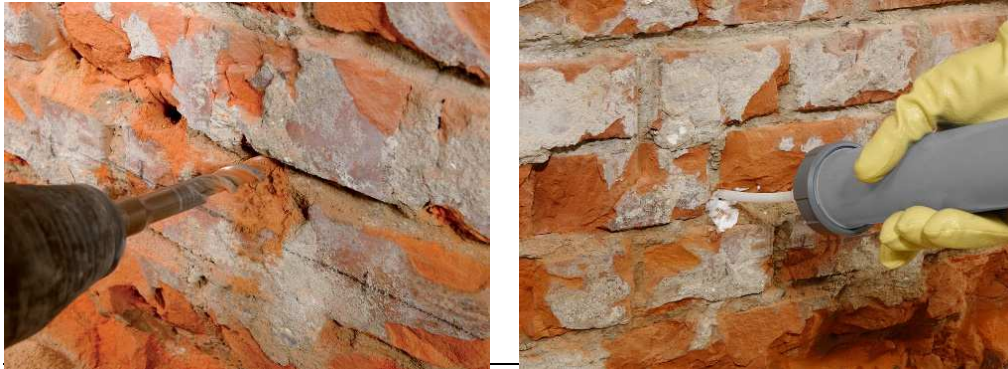
Fot. 39 i 40. Wykonanie hydroizolacji iniekcyjnej przed położeniem tynku renowacyjnego.
