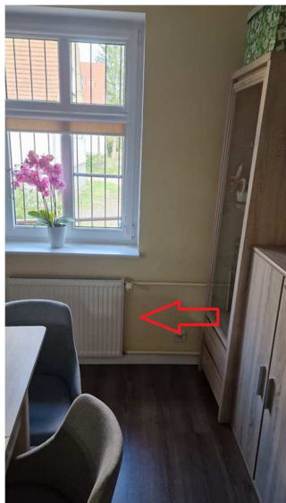
Fot. nr 37. Grzejnik do przeniesienia w pomieszczeniu w poziomie parteru.
