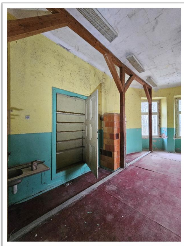
Fotografia 25 Stan istniejący (inventaryzacja pom. 10 parter) – Sala ślubów (proj. pom. 1.14) – widok stanu po adaptacji pomieszczeń na mieszkanie/klasę, widoczne wyparcie stropu.
