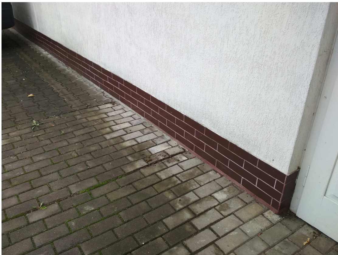
Fotografia nr 5: Widok na nawierzchnię z kostki brukowej przy ścianie północnej Stalarni UMP
