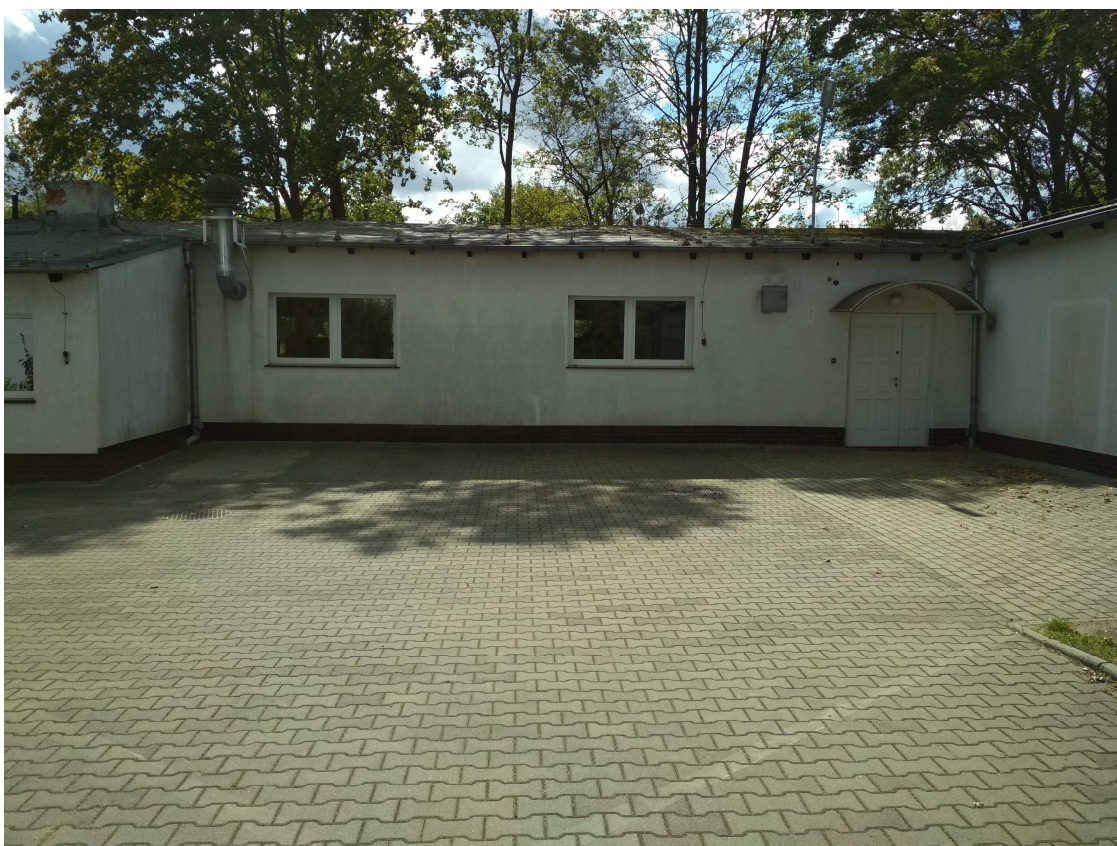
Fotografia nr 1: Widok na ścianę północną budynku Stolarsni UMP – część z wejściem do Stolarsni
