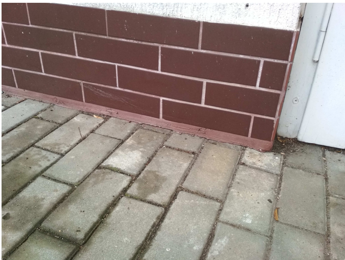
Fotografia nr 6: Ściana północna Stalarni UMP - istniejący styk strefy cokołowej z kostką brukową
