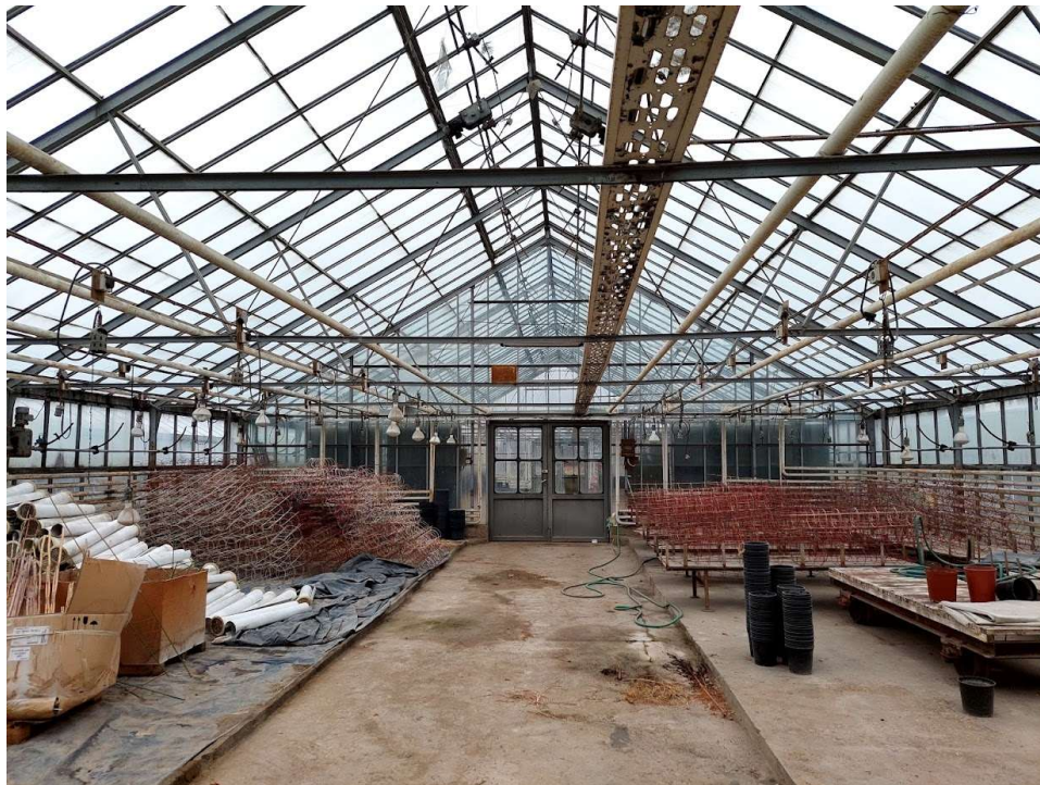
Zdjęcie 5 Widok na drzwi wejściowe do komory
