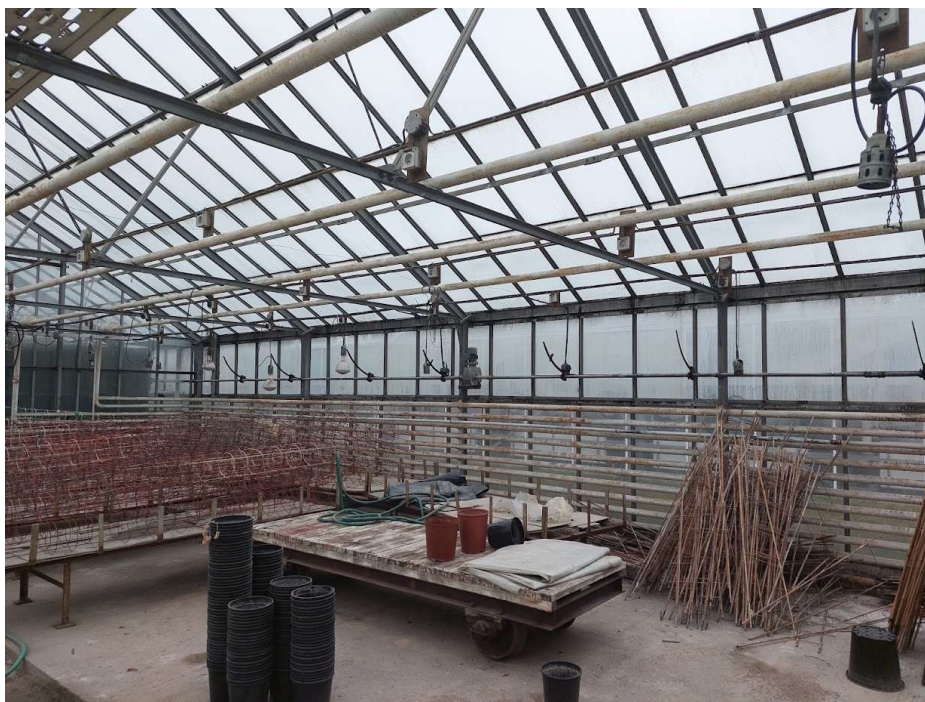
Zdjęcie 4 Stan istniejący - dach i ściany widok od środka
