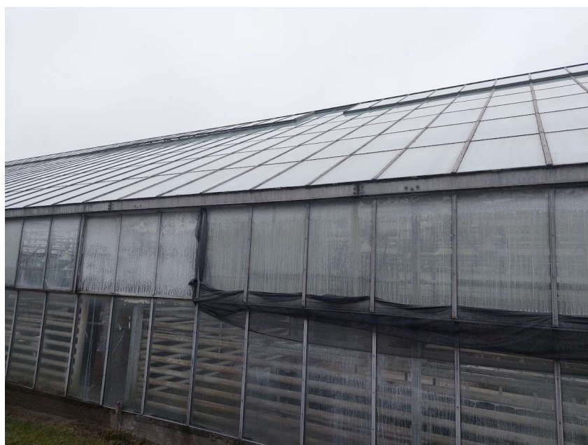
Zdjęcie 2 Istniejące ściany szklarni
