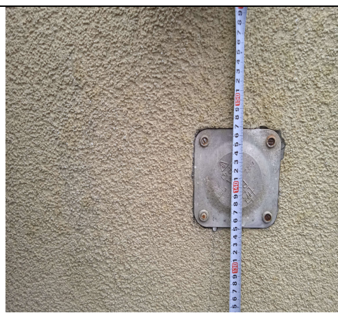
Widok na istniejące elementy instalacji odgromowej z poziomu gruntu budynku „U” :
