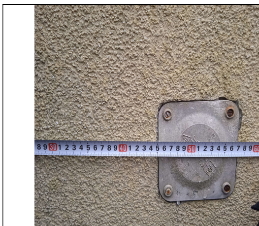
Widok na istniejące elementy instalacji odgromowej z poziomu gruntu budynku „U” :
