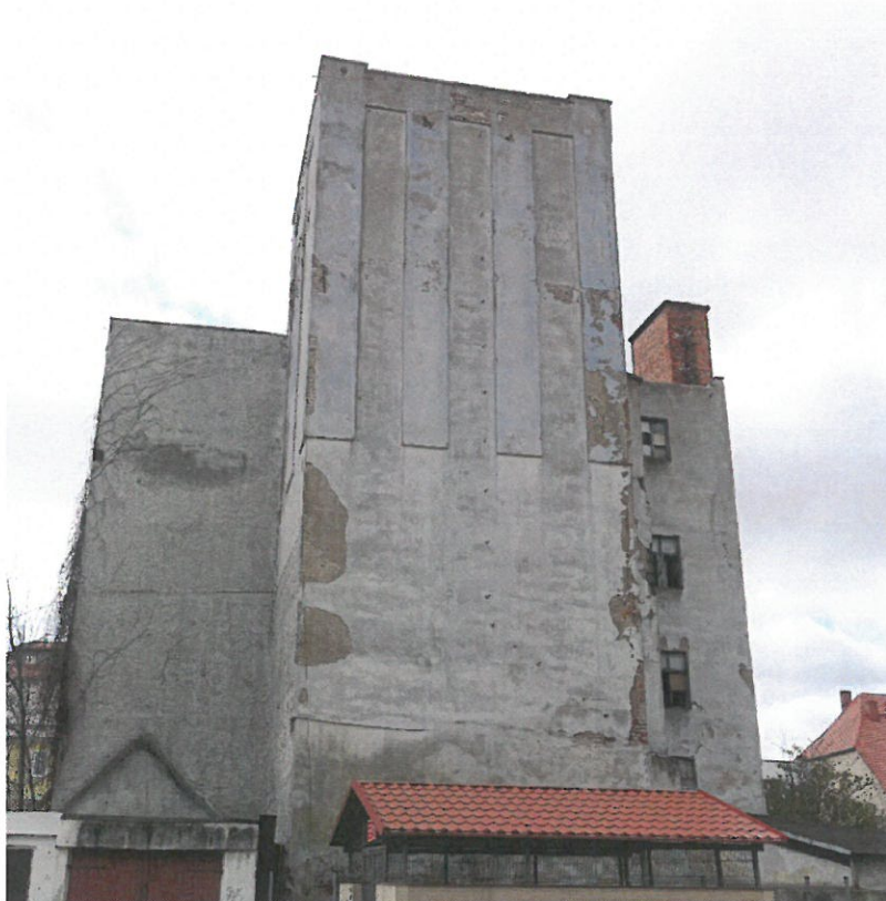
Fot. 9. Ogólny widok elewacji północnej.
