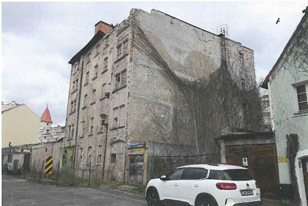
Fot. 6. Ogólny widok budynku od strony południowo-wschodniej.
