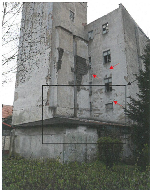
Fot. 10. Widok fragmentu elewacji północnej od strony północno-wschodniej. Widoczne rysy i pęknięcia zaznaczone strzałkami (porównaj z rys. zamieszczonym w załączniku 3)
