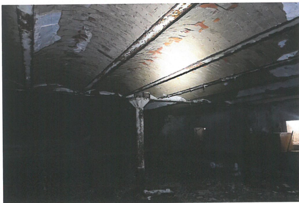
Fot. 21. Parter. Pomieszczenie +1.3. Ogólny widok stropu odcinkowego na belkach stalowych
