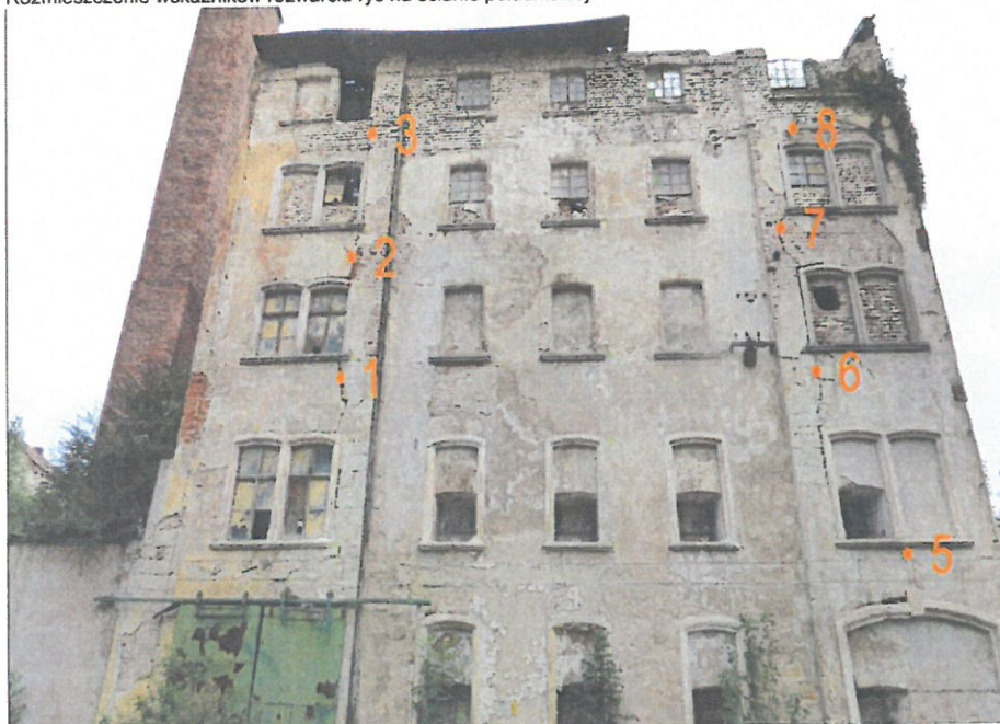
Rozmieszczenie wskaźników rozwarcia rys na ścianie zachodniej.
