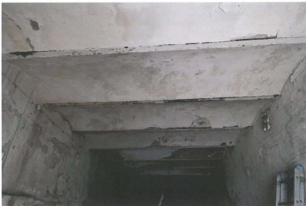
Fot. 19. Parter. Korytarz. Pomieszczenie 1.1. Ogólny widok stropu odcinkowego na belkach stalowych nad parterem.
