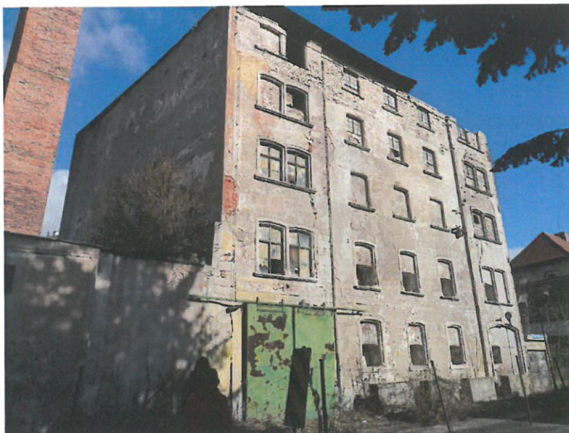
Fot. 1. Ogólny widok elewacji frontowej (południowej)
