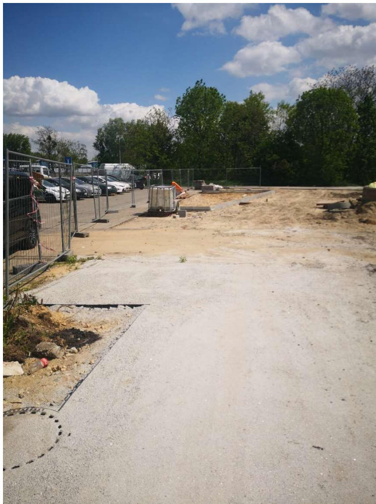
Fragment wykonanej ścieżki i przygotowane podłoże pod nawierzchnię utwardzoną. Źródło: dokumentacja fotograficzna własna
