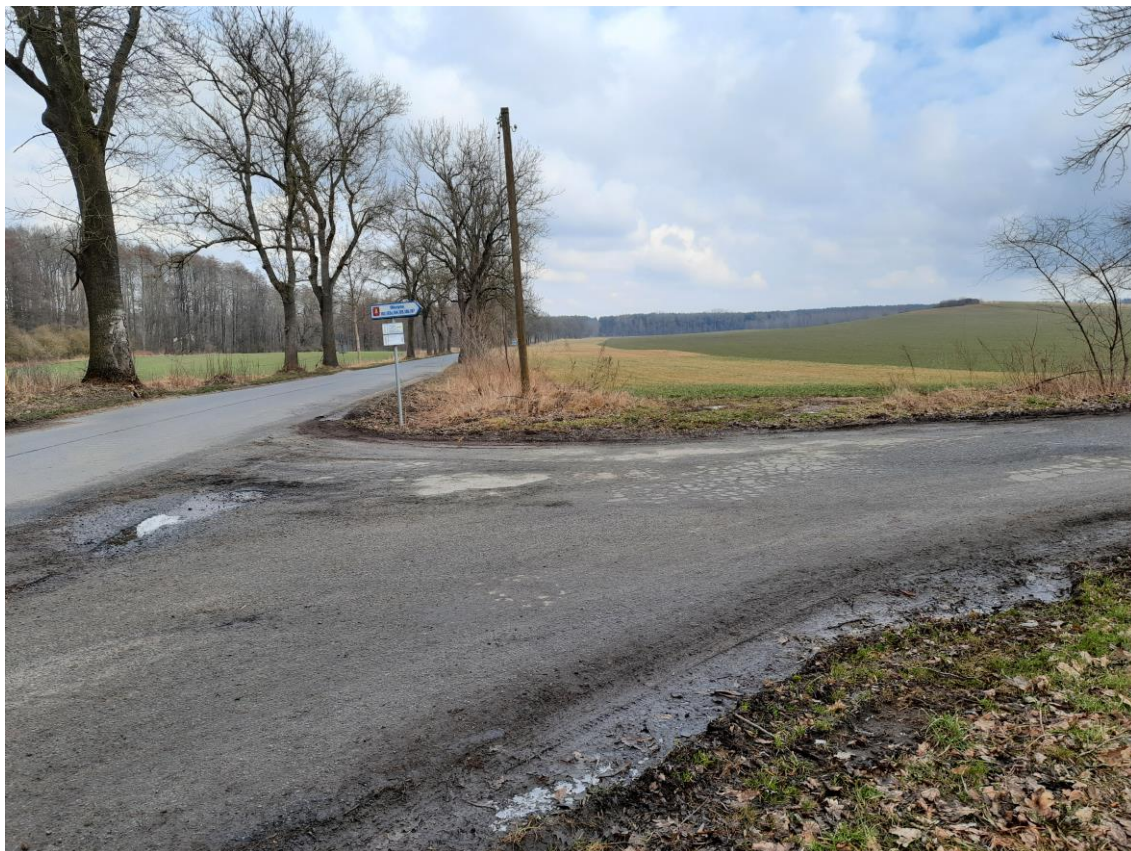
Fot. 5. Droga w km 3+330.
