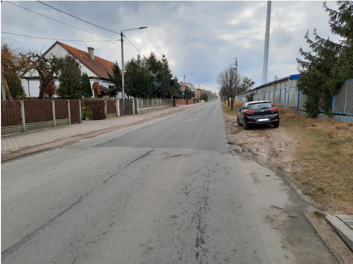
Fot. 1. – Początek opracowania km 0+000
