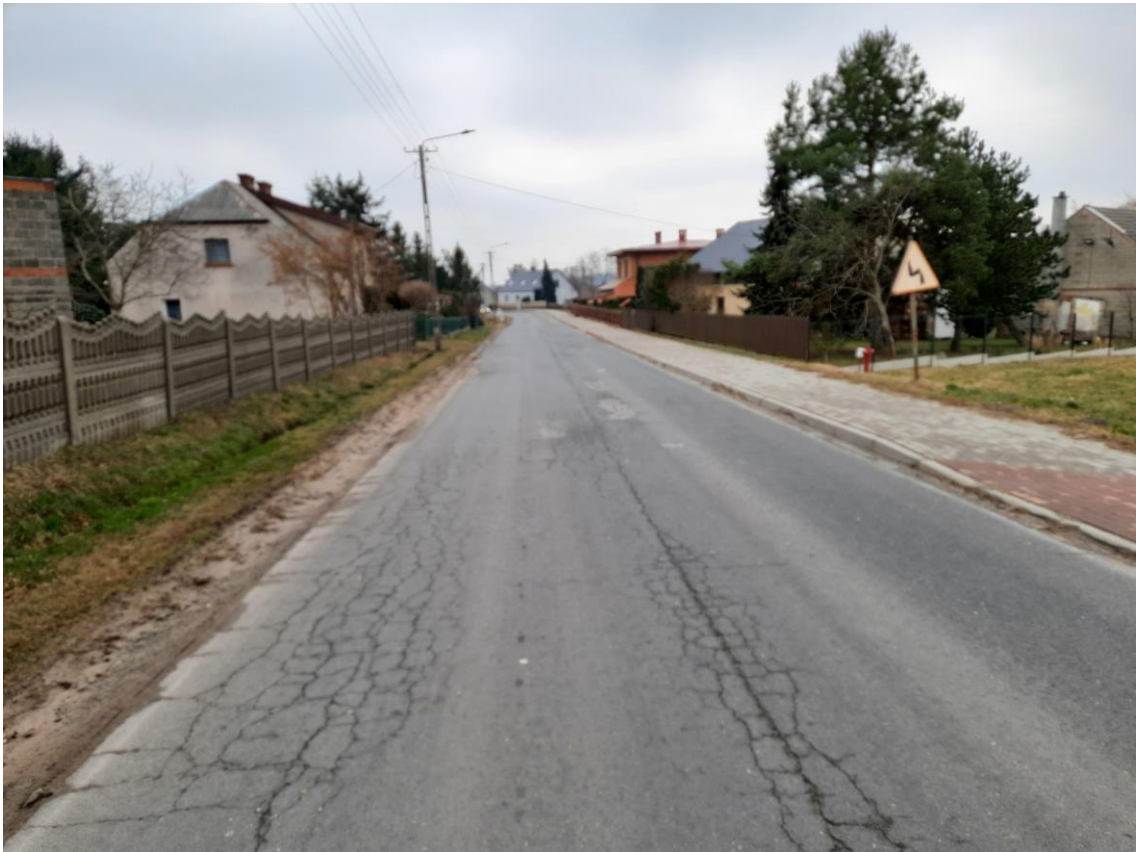
Fot. 11. Droga w km 6+900
