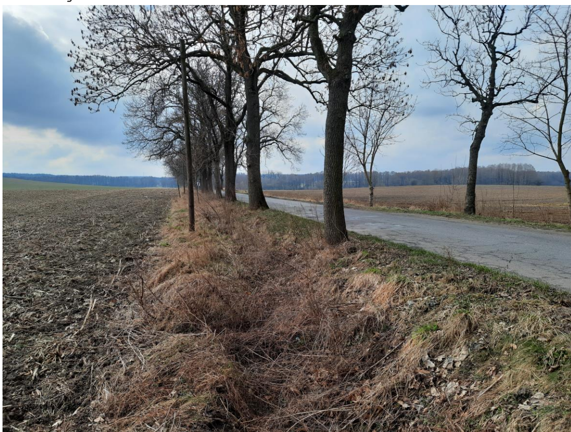
Fot. 4. Droga w km 2+400
