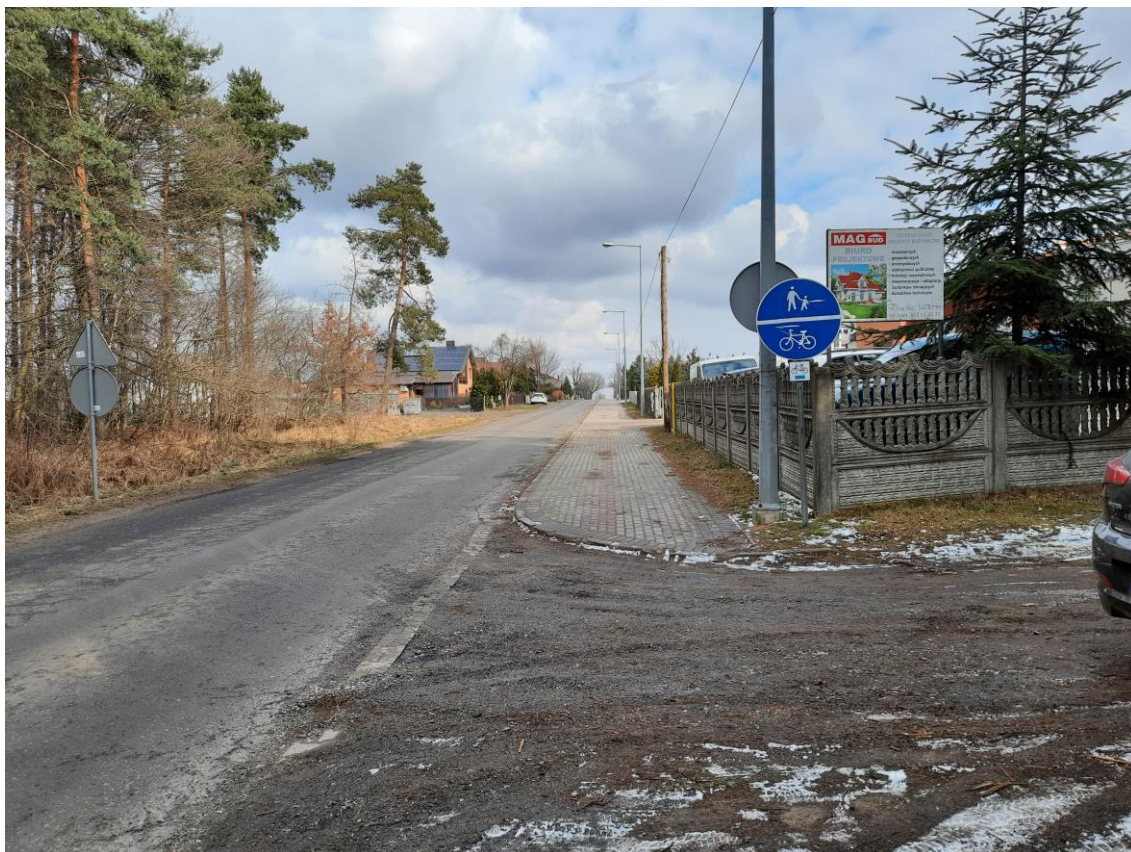
Fot. 3. Droga w km 1+900
