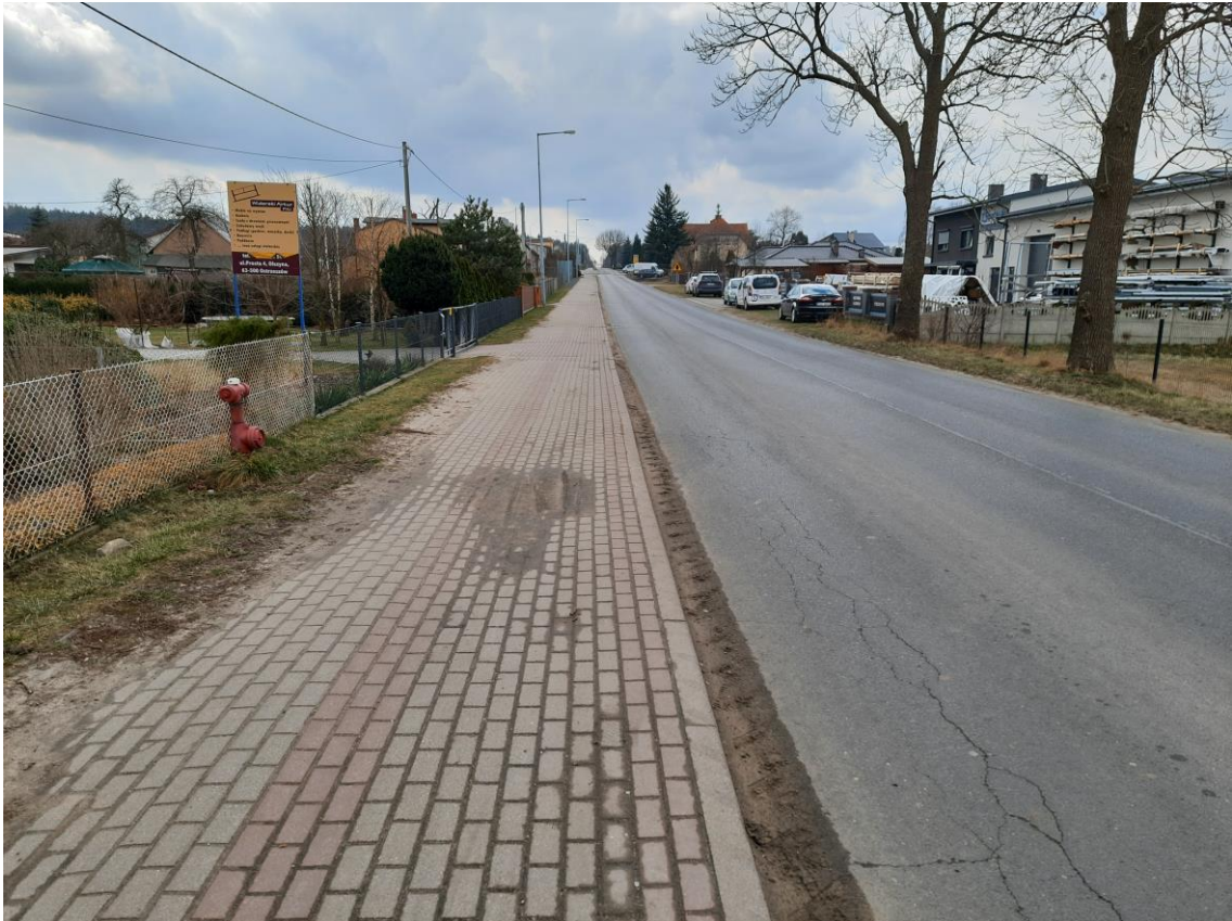
Fot. 2. Droga w km 1+300
