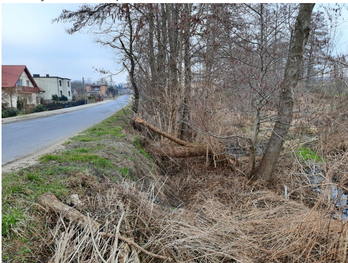
Fot. 10. Droga w km 6+650
