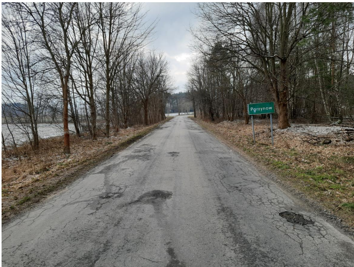
Fot. 7. Droga w km 4+700
