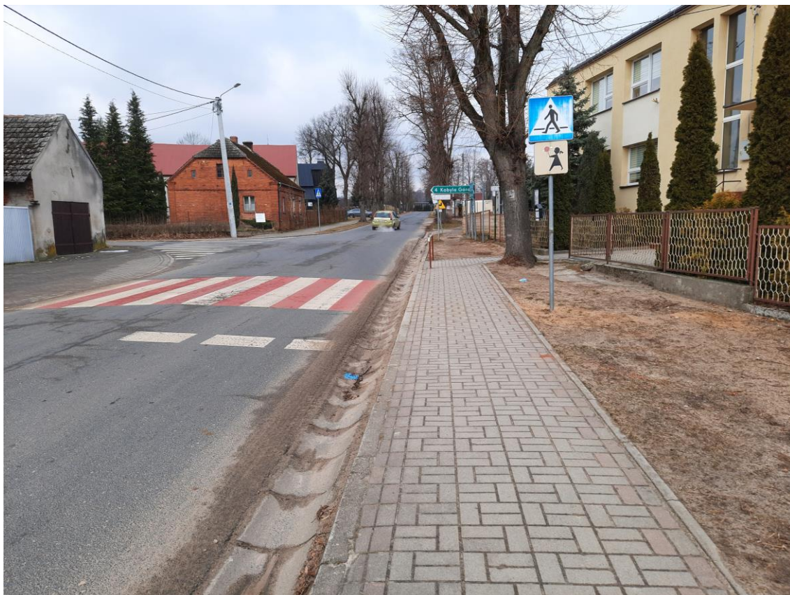
Fot. 9. Droga w km 6+350 (Parzynów)
