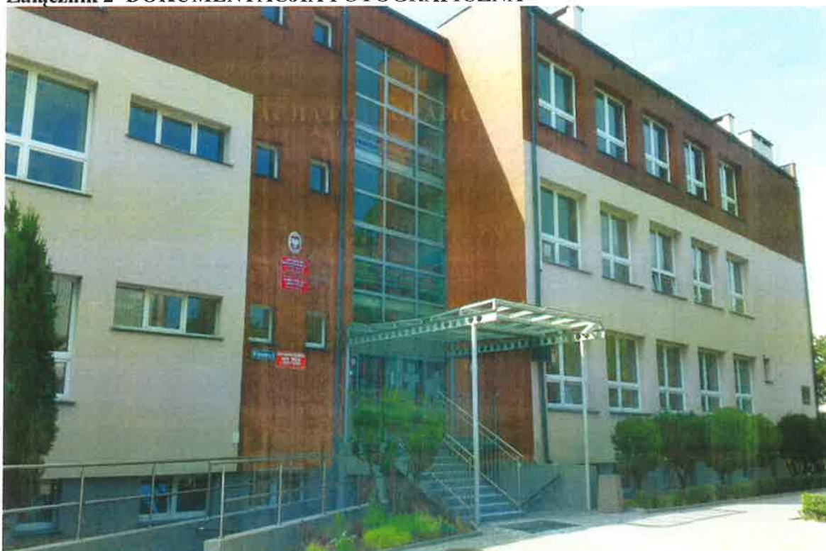
Fot. 1. Widok budynku od frontu
