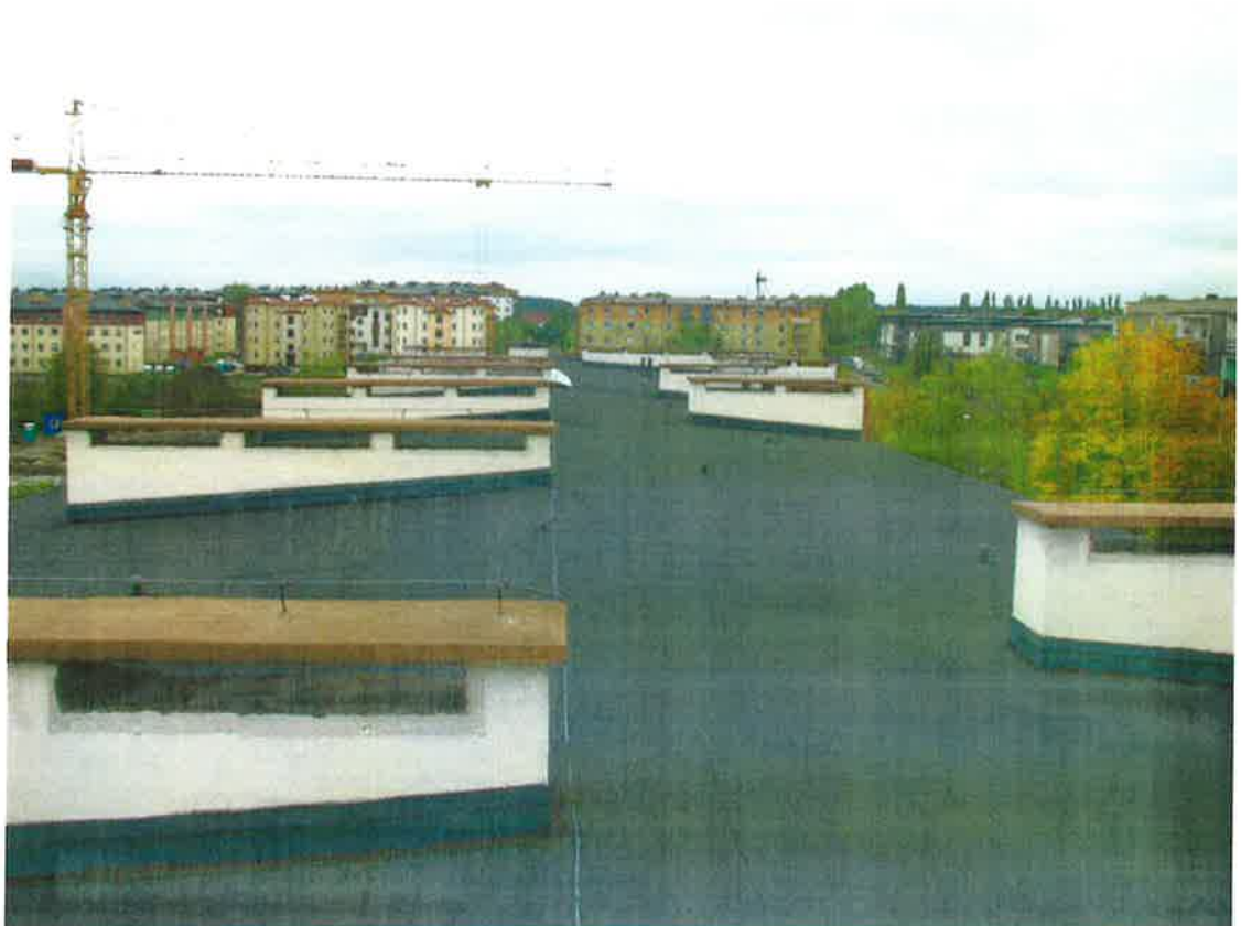
Fot. 4. Dach budynku głównego
