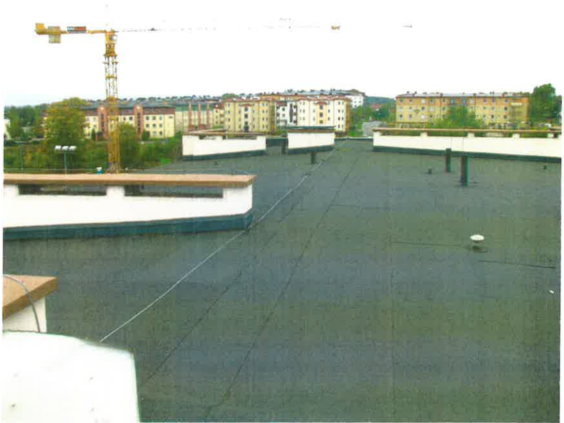
Fot. 5. Dach budynku głównego
