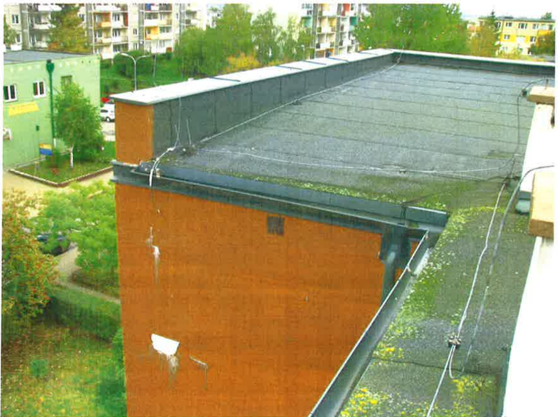
Fot. 6. Dach budynku głównego
