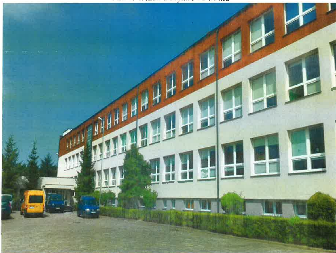
Fot. 2. Widok budynku od tyłu
