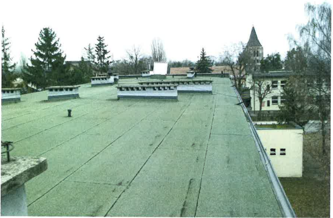
Fot. 5. Widok dachu
