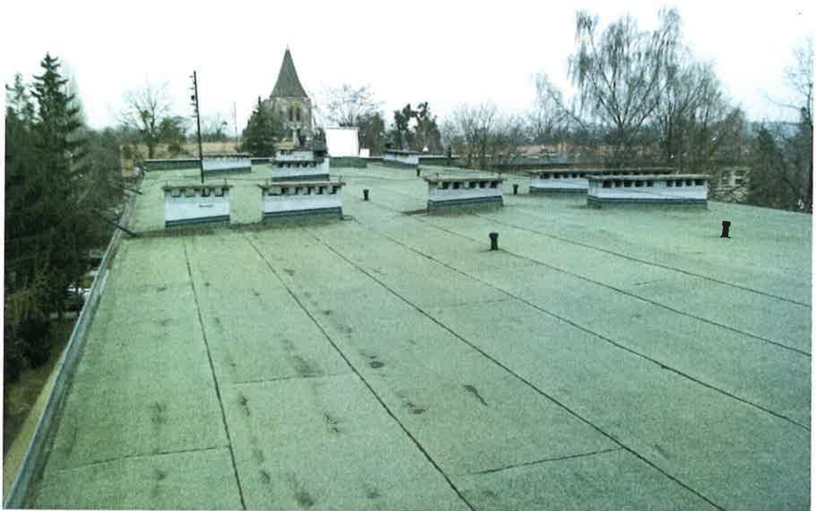
Fot. 6. Widok dachu
