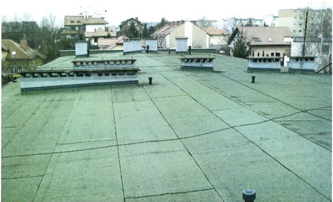
Fot. 4. Widok dachu
