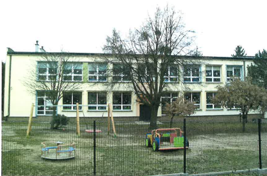
Fot. 1. Widok budynku
