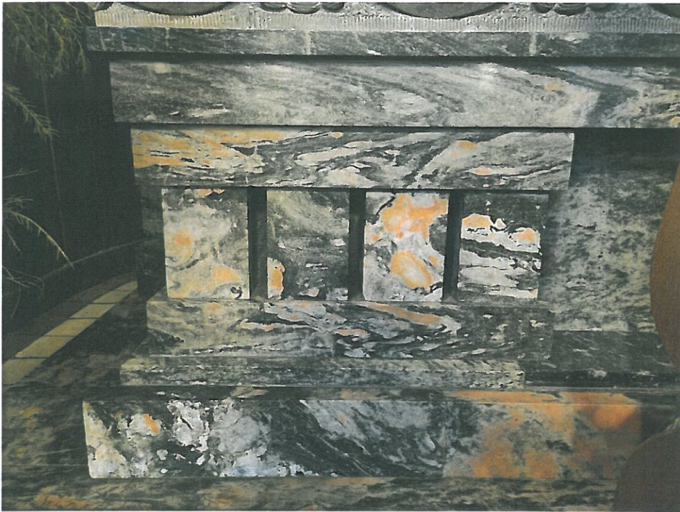
Fot. 22. Kościół pw. Matki Bożej Królowej Aniołów, Biały Dunajec. Zbliżenie na architekturę ołtarza bocznego w kaplicy po lewej stronie wykonaną z elementów wapienia krystalicznego.
