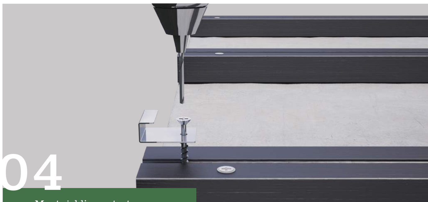
Montaż klipsa startowego
