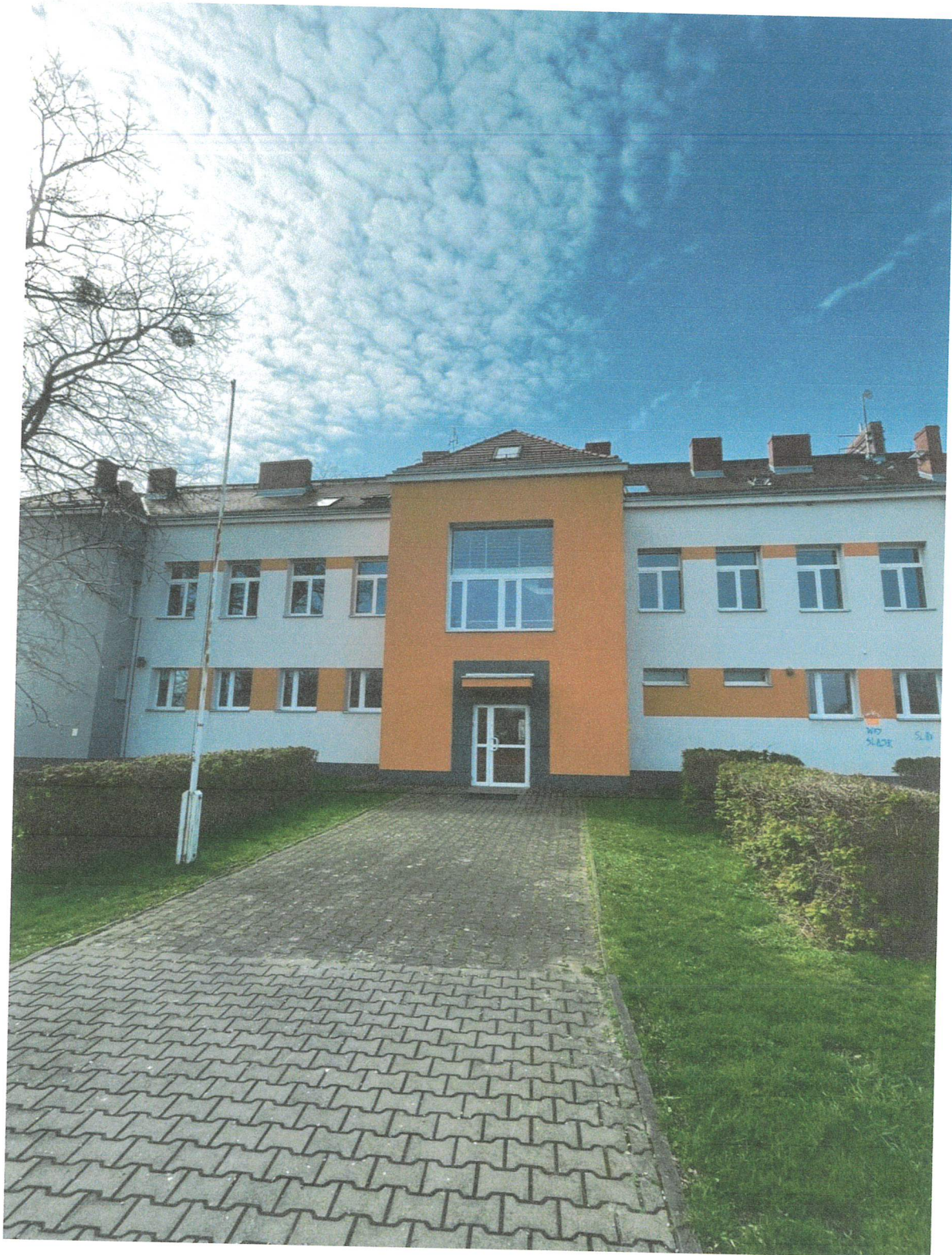
Widok ogólny na budynek Szkoły Podstawowej.
