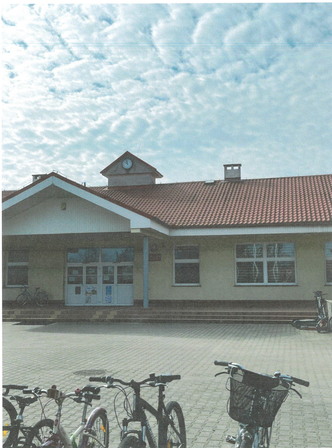
Widok ogólny na budynek Szkoły Podstawowej.
