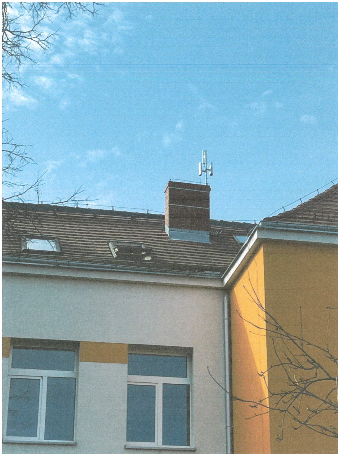
Widok na komin – miejsce mocowania bloku syreny.
