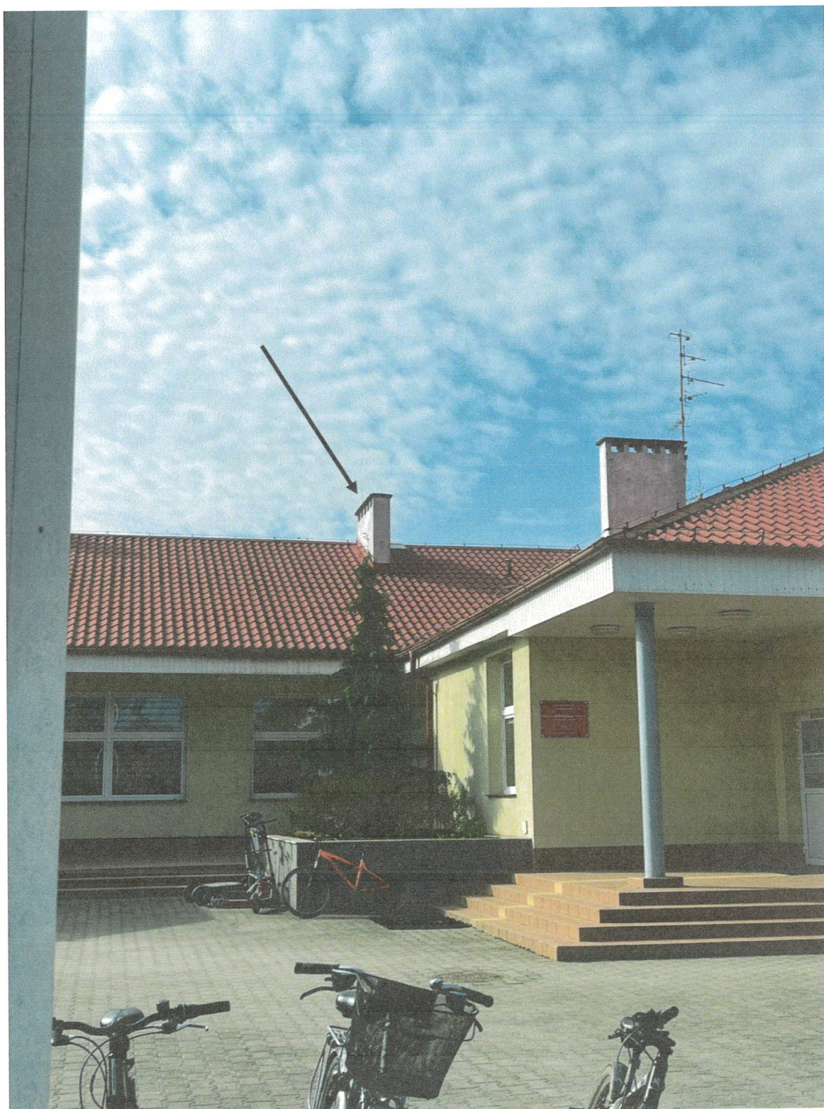
Widok na komin – miejsce mocowania bloku syreny.
