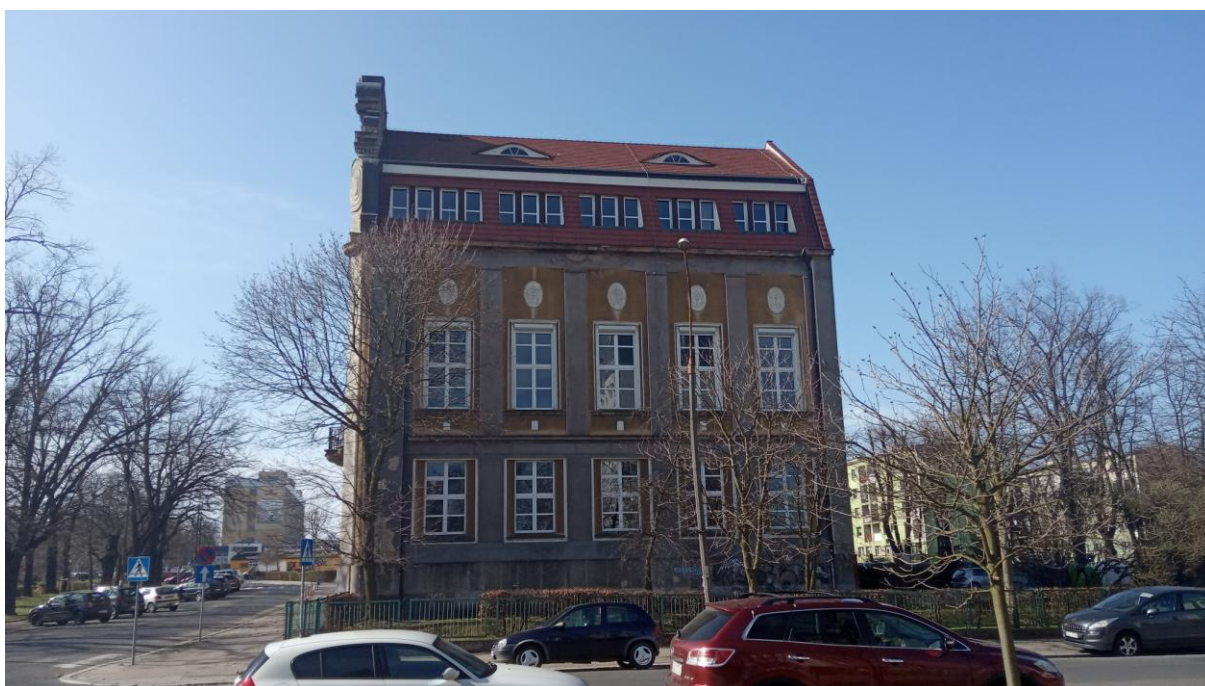
fot. 4 - elewacja południowa
