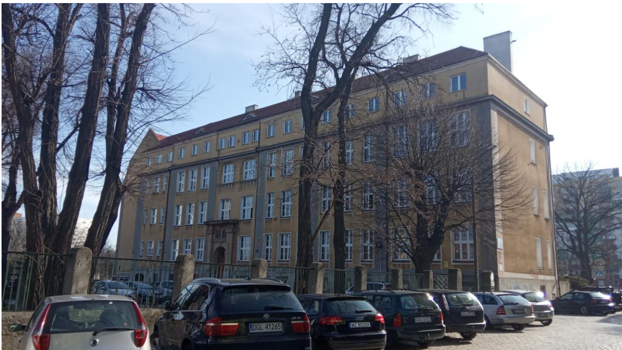
fot. 2 - elewacja zachodnia
