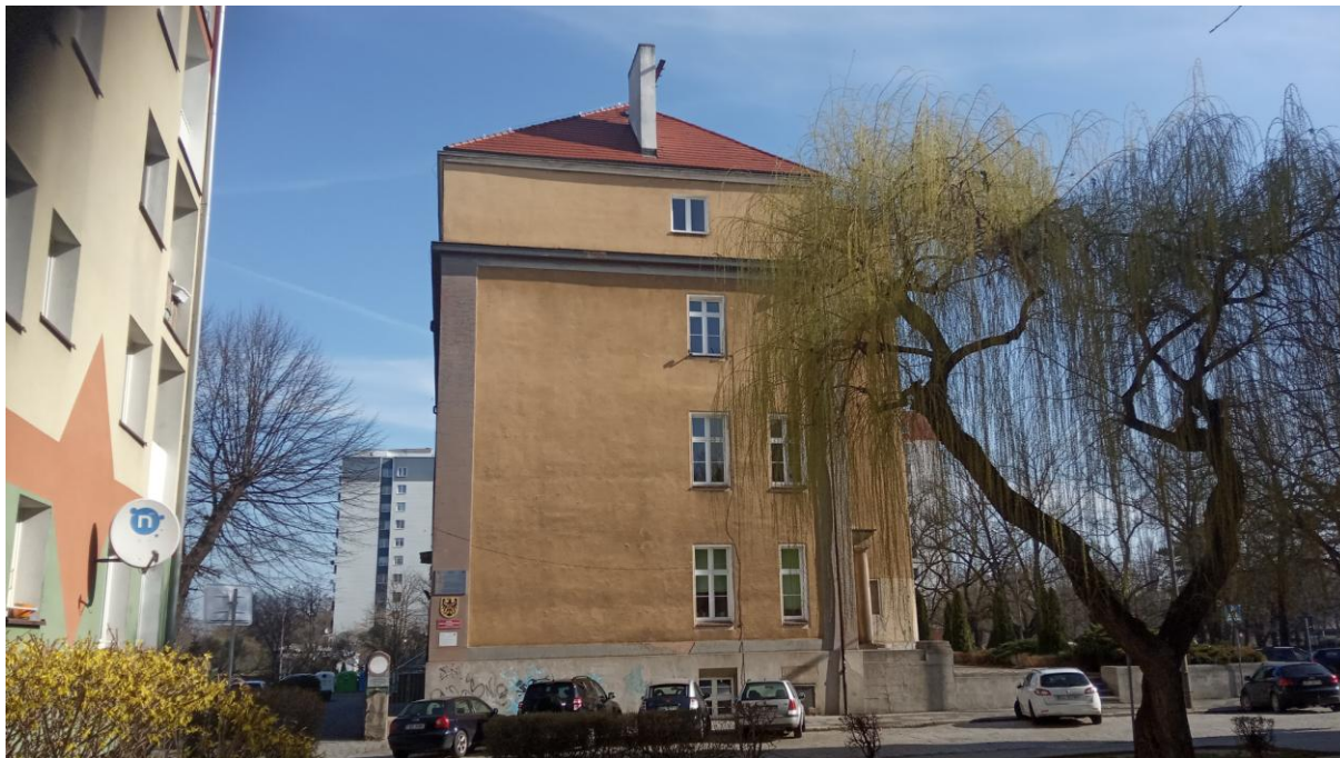
fot. 3 - elewacja północna
