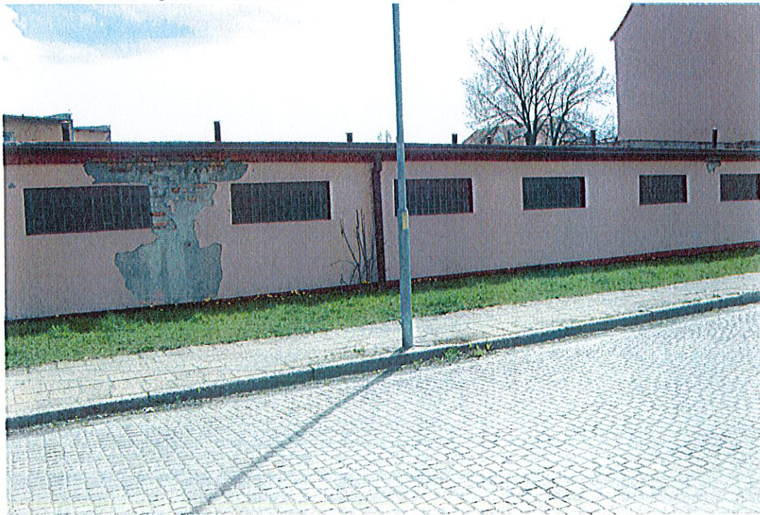
KPP w Żarach – garaże, elewacja od strony ulicy
