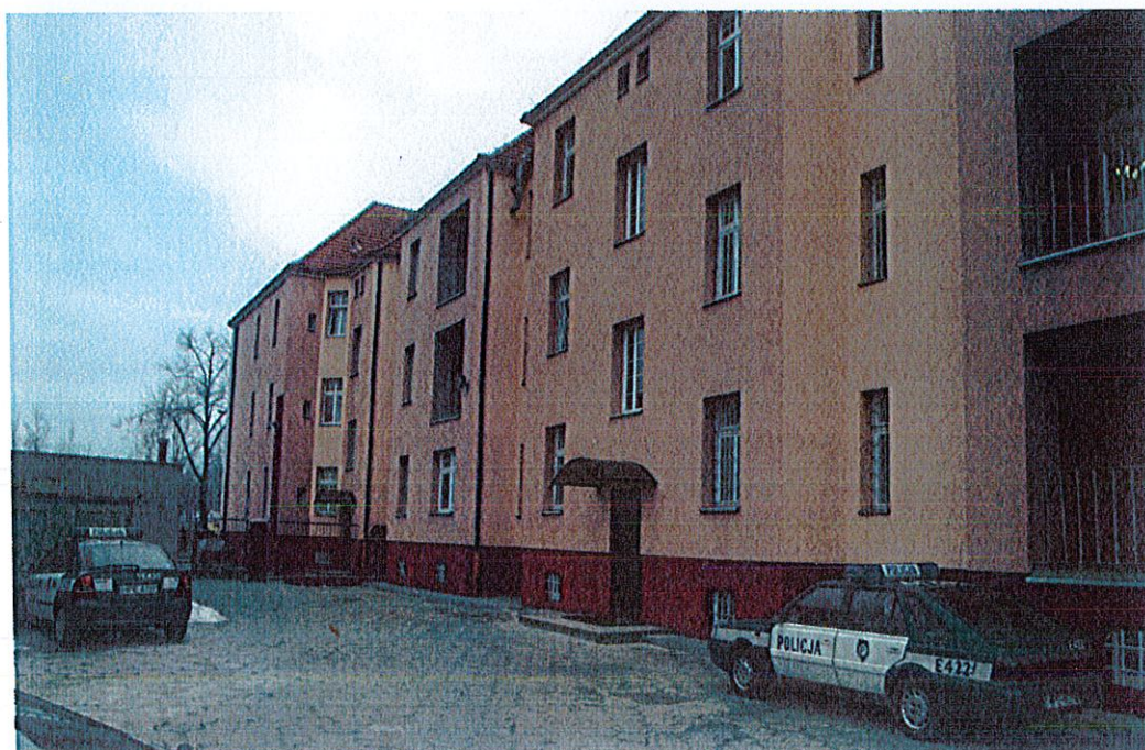
KPP w Żarach – budynek główny, elewacja tylna
