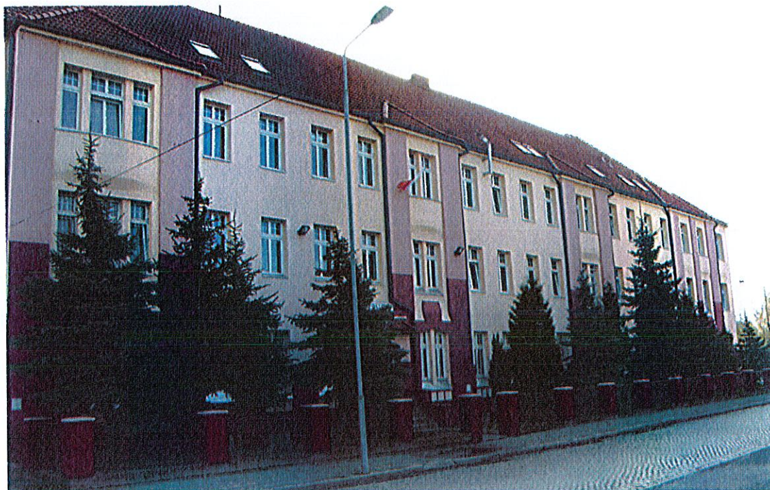
KPP w Żarach – budynek główny, elewacja frontowa
