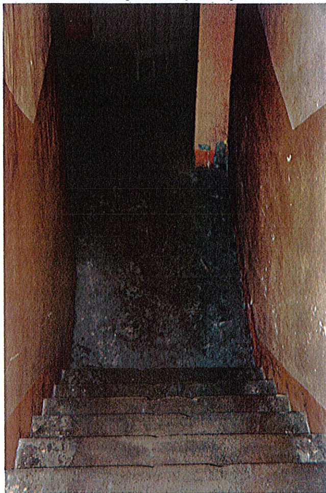
KPP w Żarach – wejście do piwnicy
