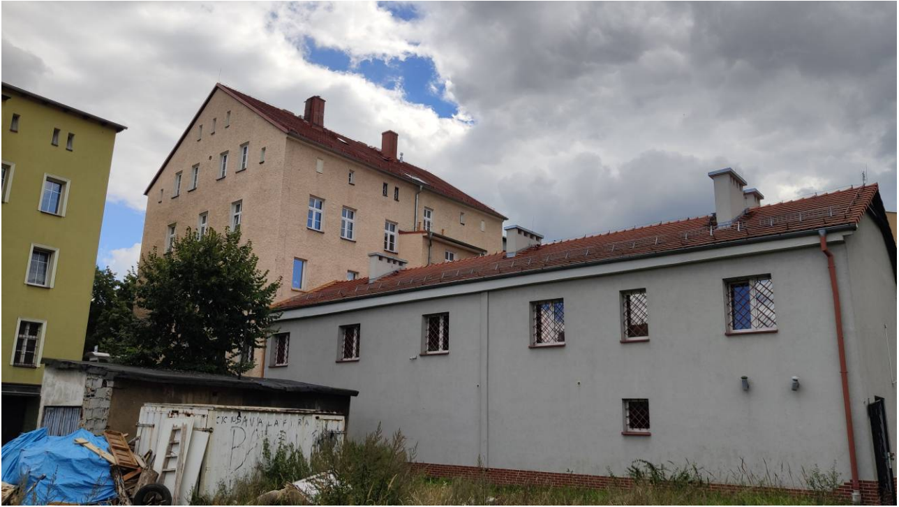
fot.2. Widok na elewację od strony podwórka
