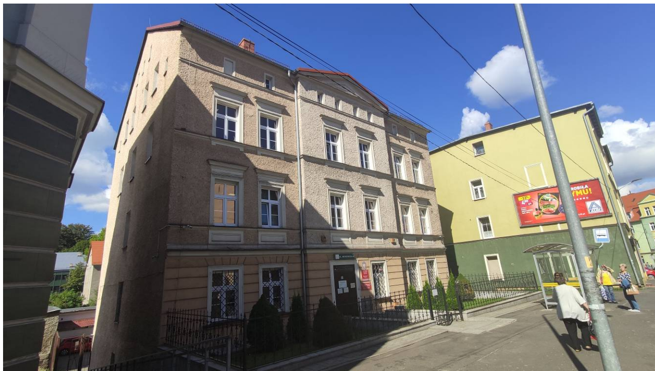
fot.1. Widok na elewację frontową
