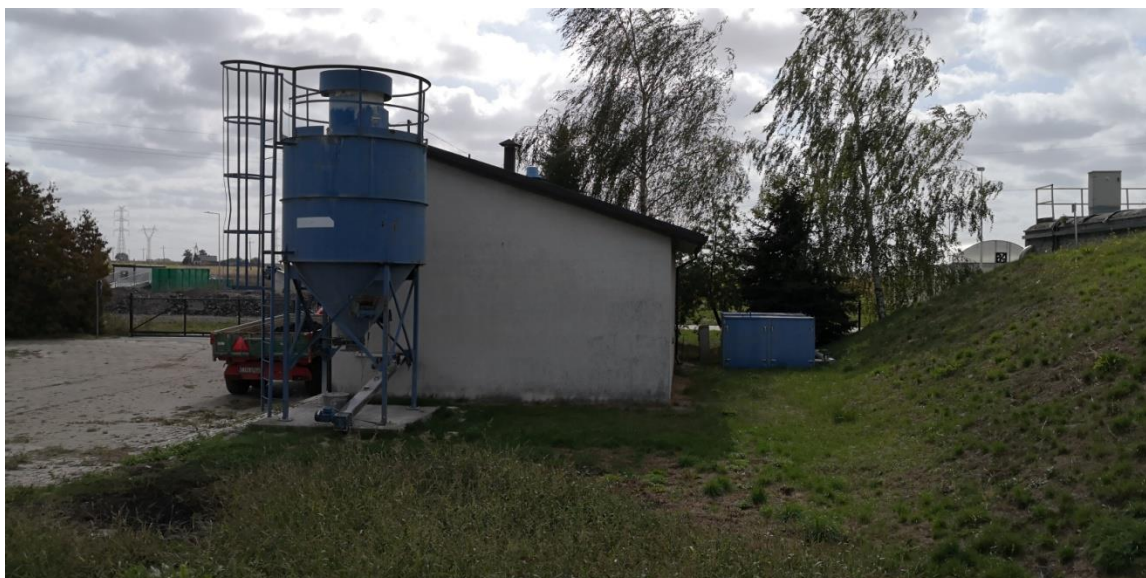
Fot. 17 Silos na wapno
