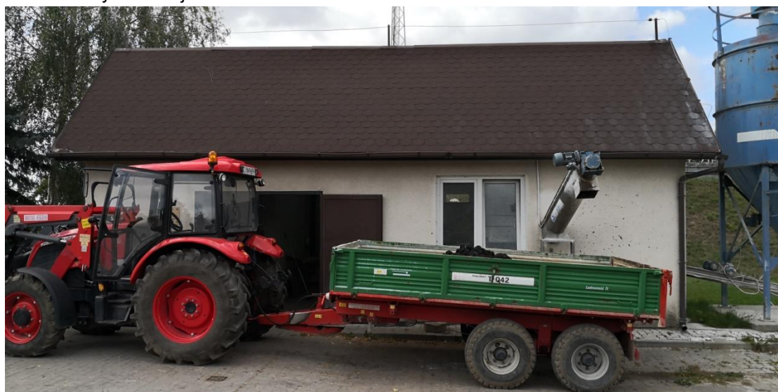
Fot. 16 Budynek stacji odwadniania osadu
