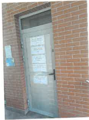
Drzwi wejściowe - widok od zewnątrz
