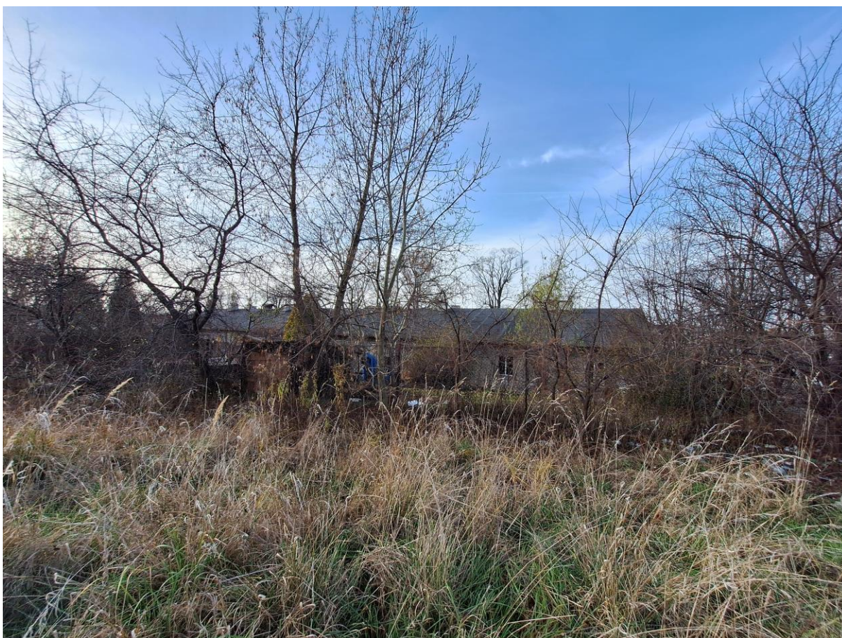
Fot. 4 Elewacja wschodnia
