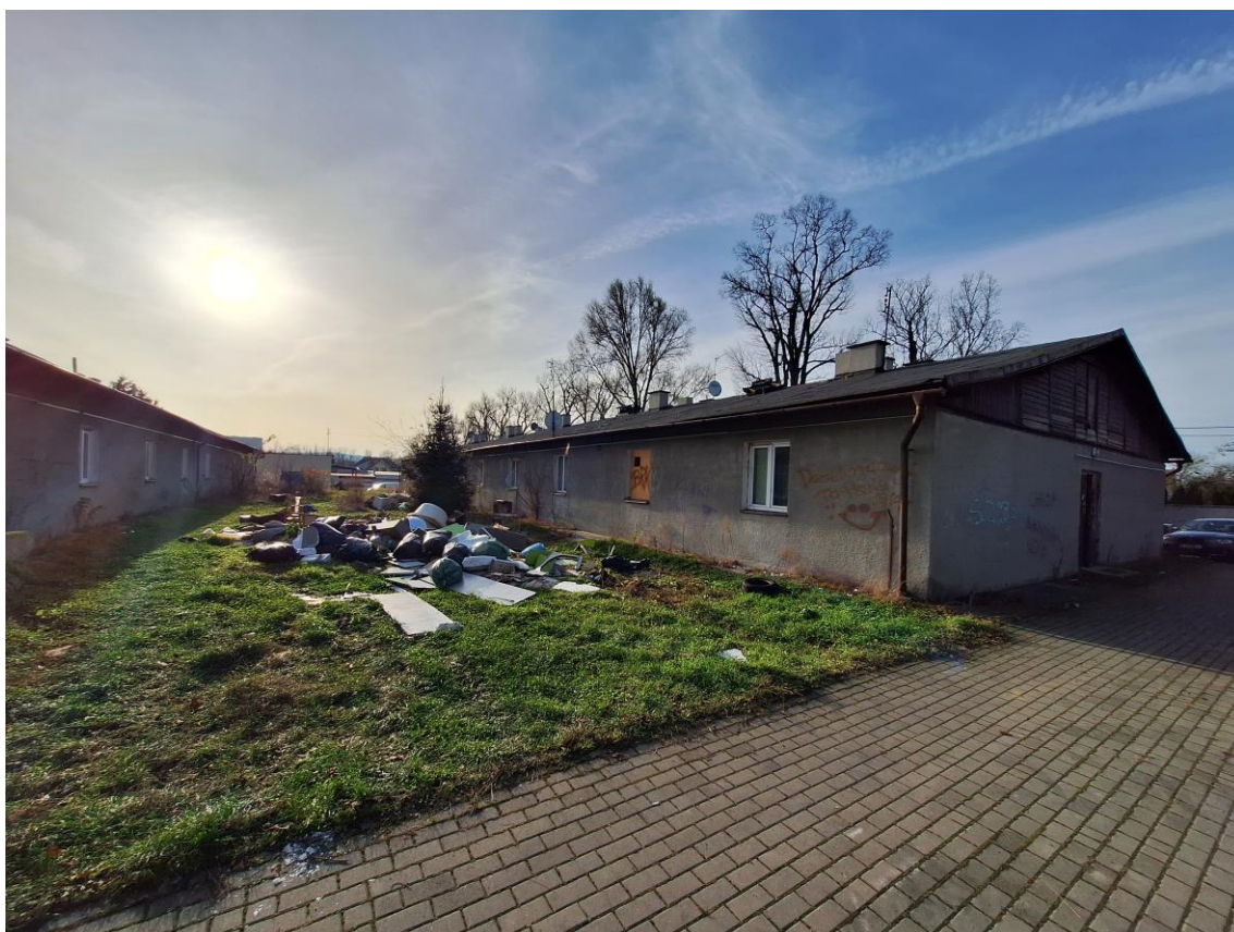
Fot. 15 Elewacja wschodnia
