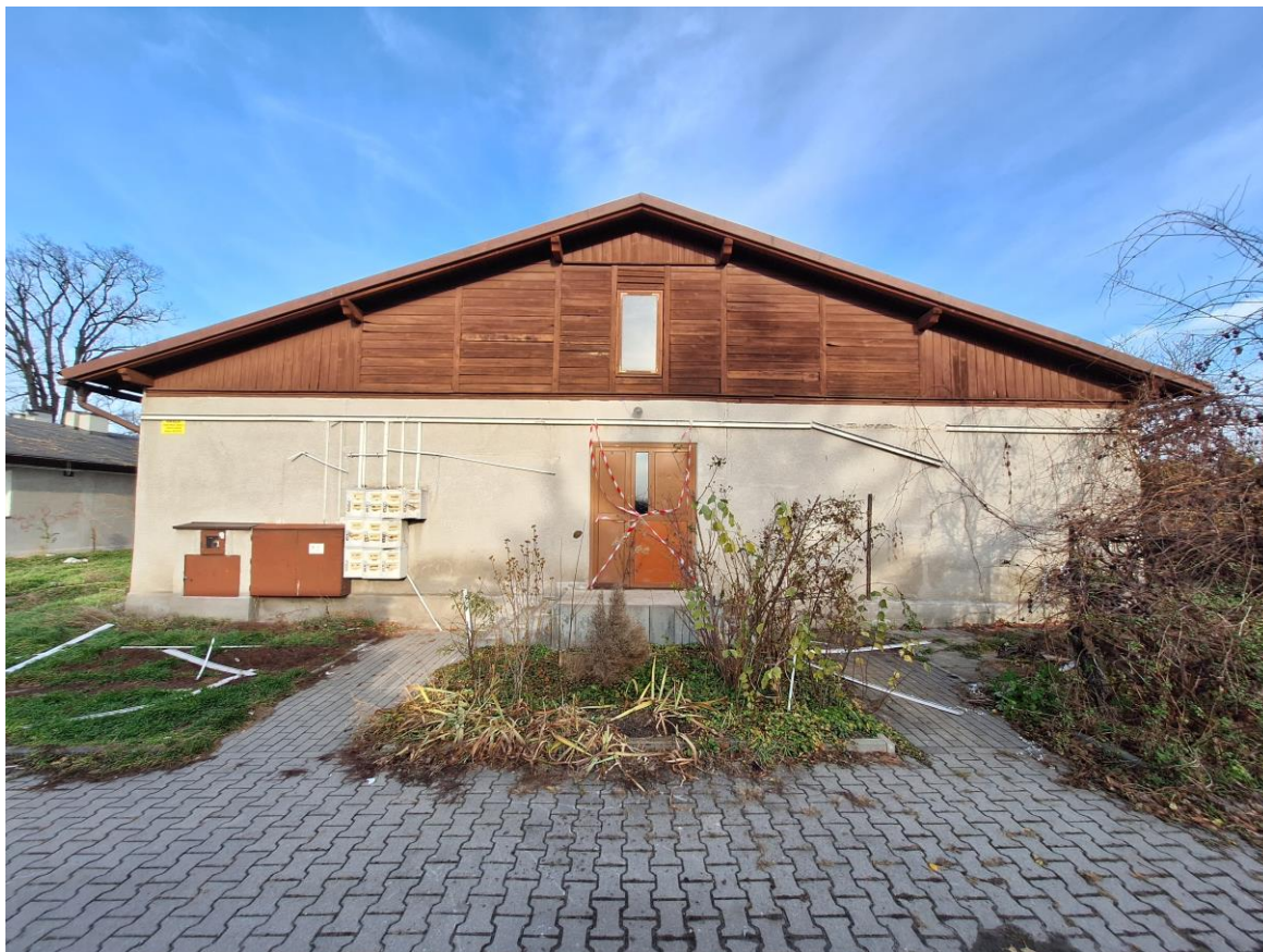
Fot. 5 Elewacja południowa
