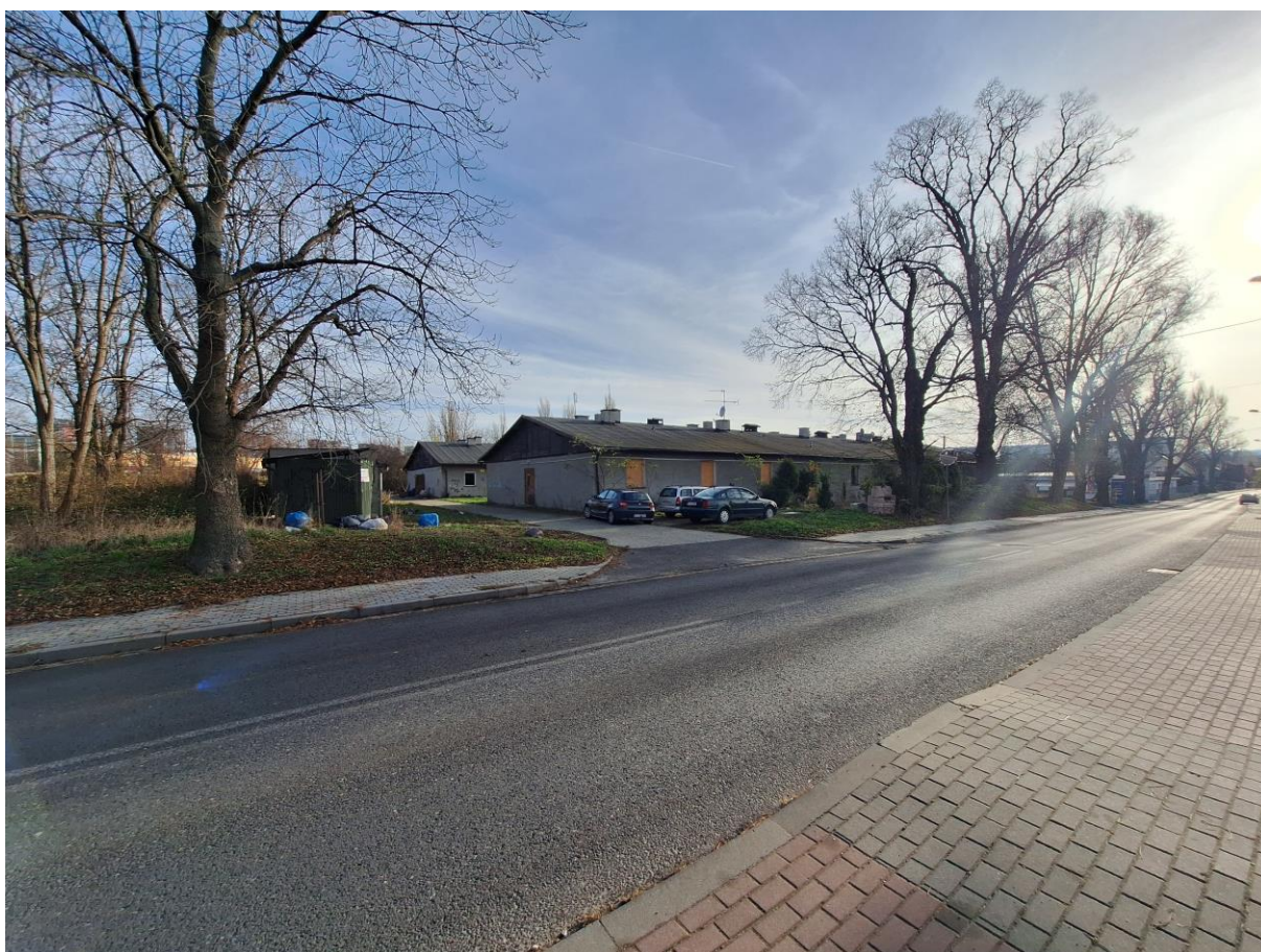
Fot. 32 Nieruchomość – widok na elewacja północne (po lewej) oraz elewacje zachodnie (po prawej)
