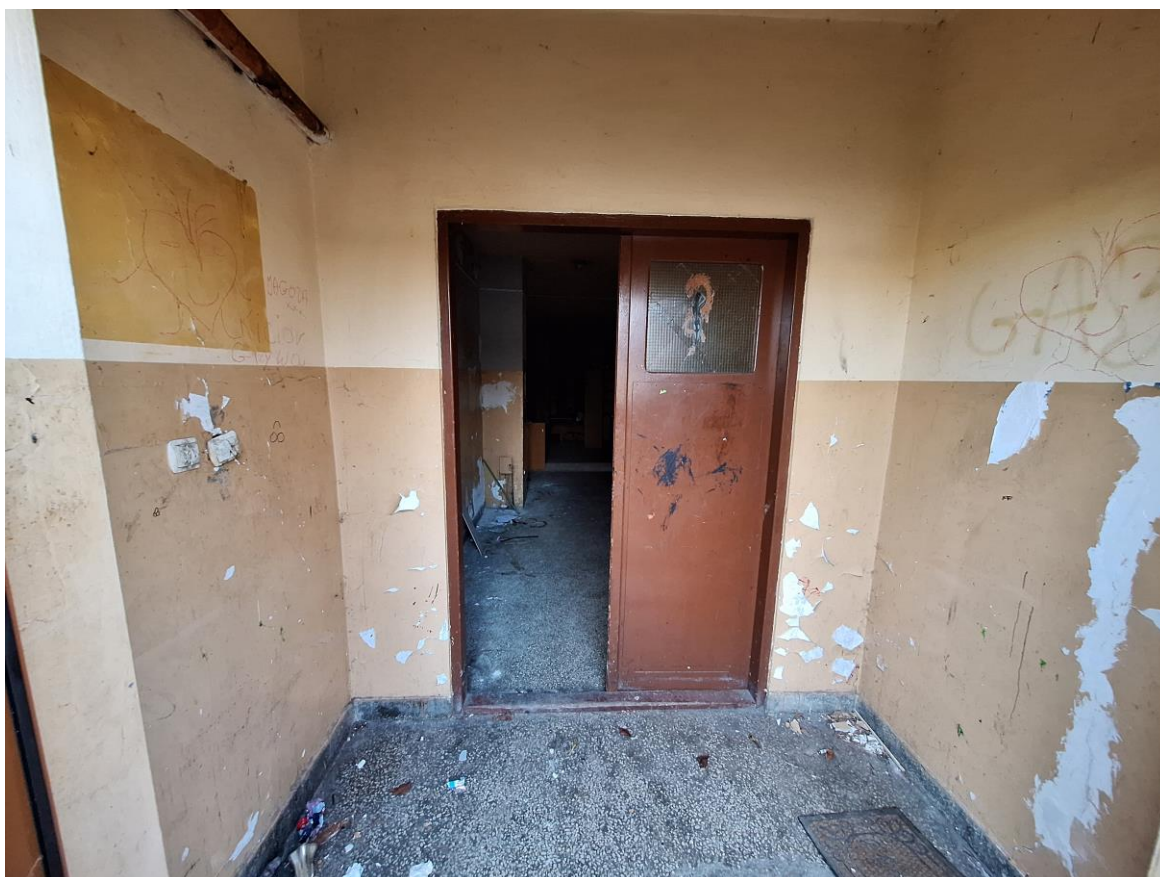
Fot. 6 Wejście do budynku – strona północna
