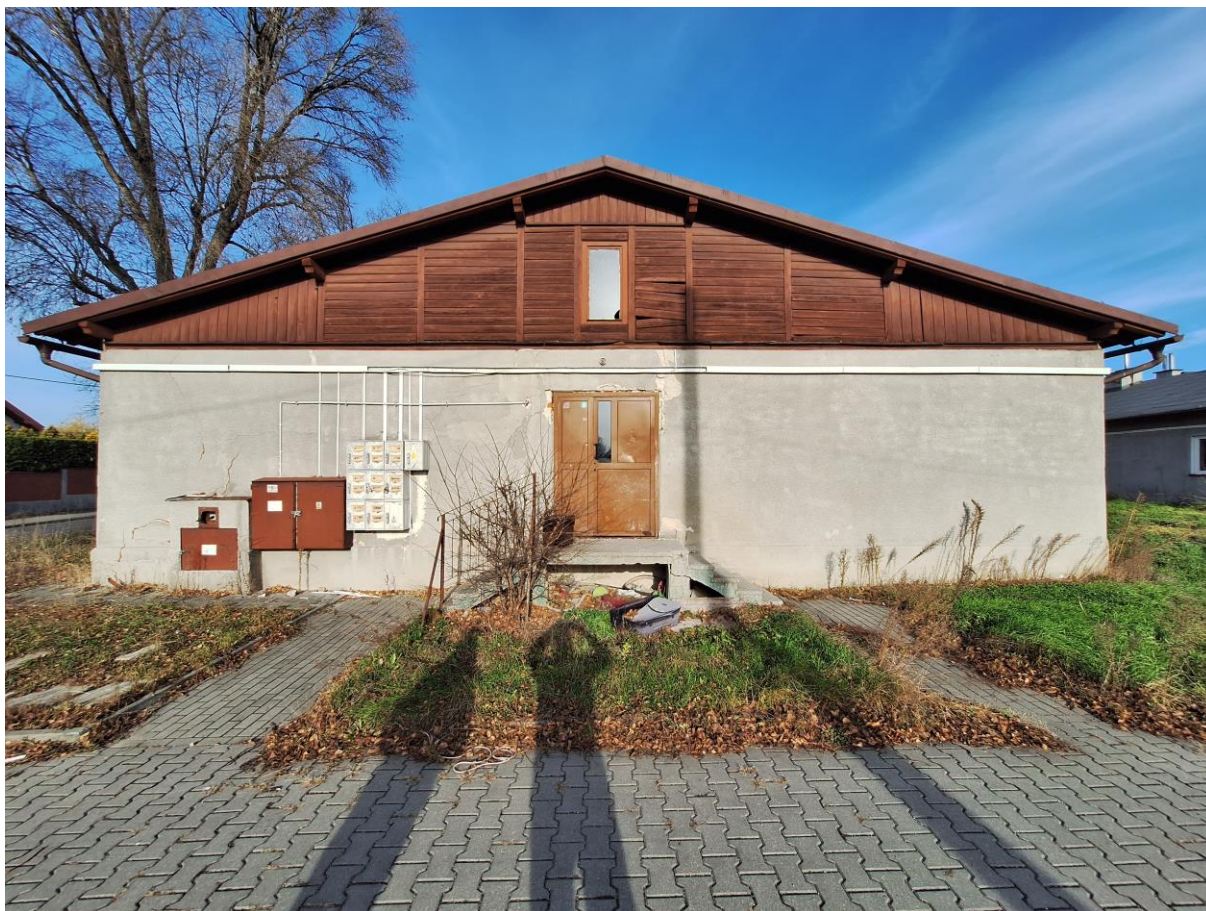
Fot. 16 Elewacja południowa
