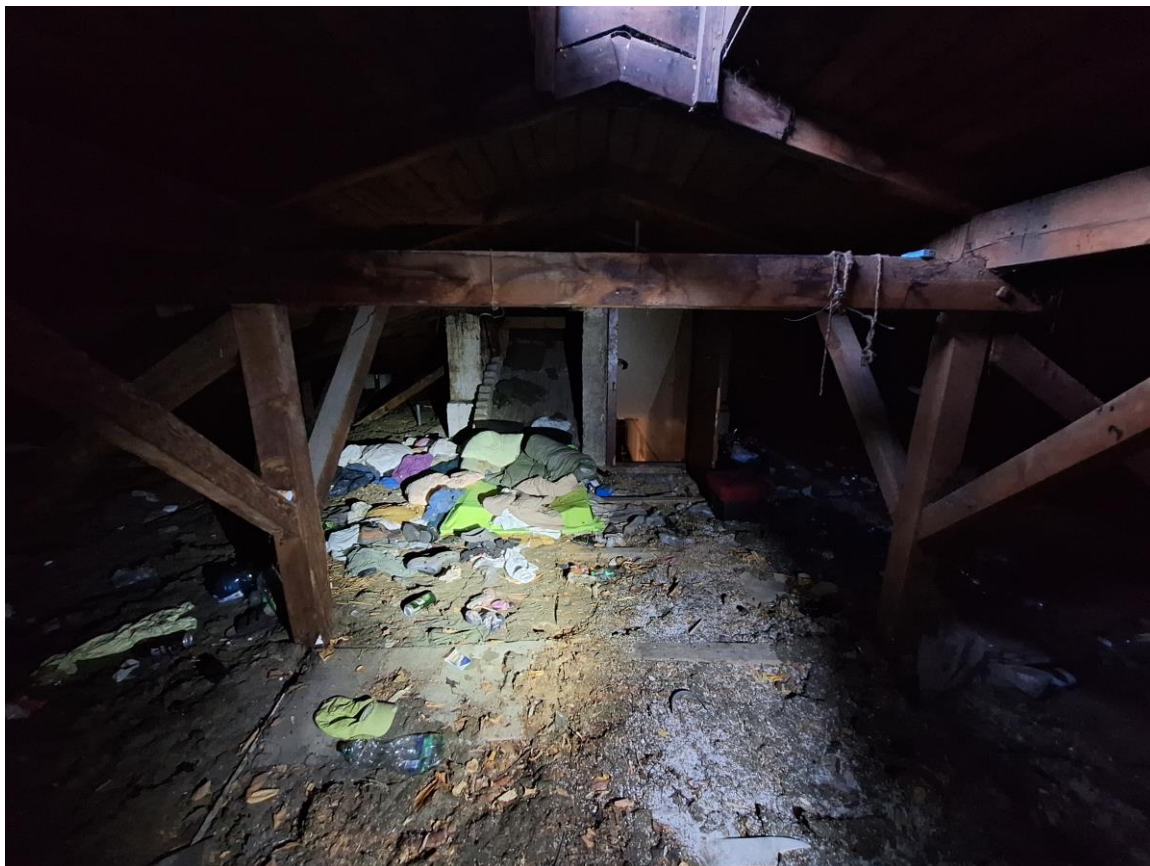
Fot. 20 Strych – widok na schody strychowe
