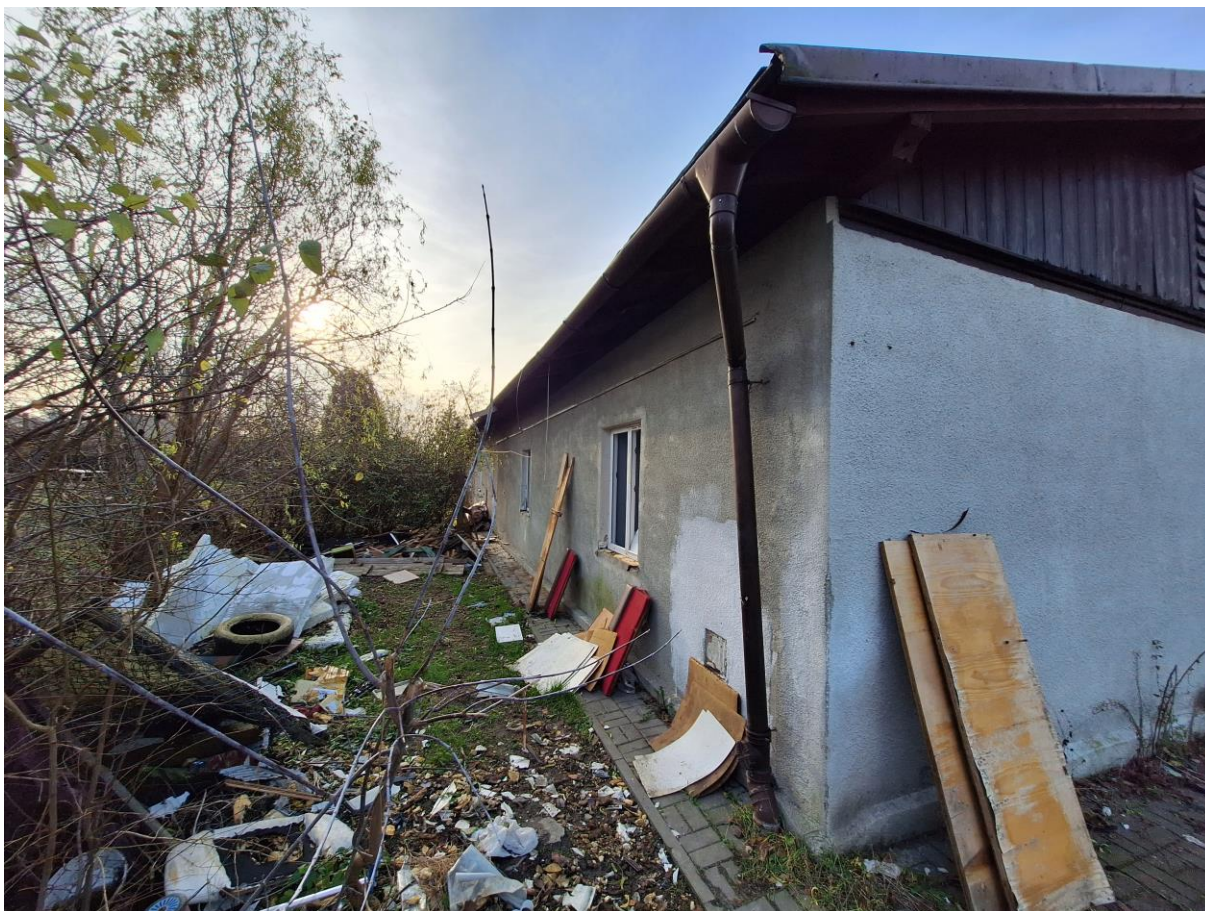
Fot. 3 Elewacja wschodnia
