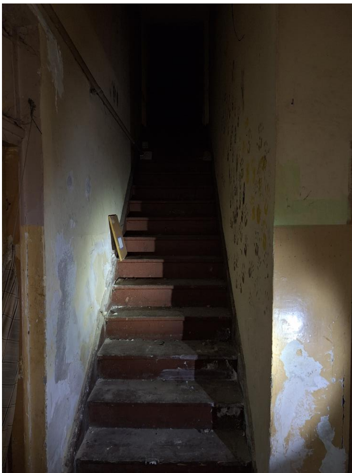
Fot. 8 Schody strychowe
