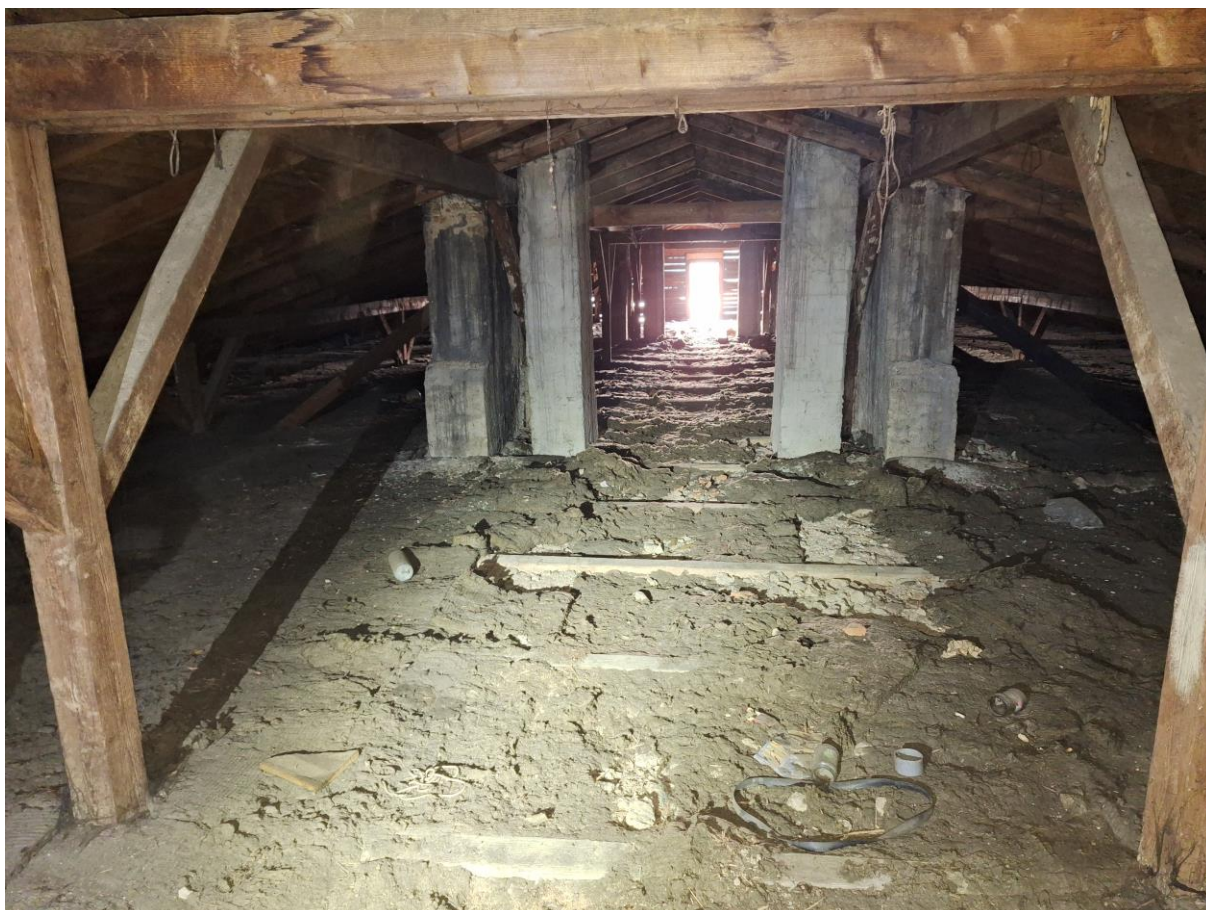
Fot. 9 Strych – więźba dachowa, kominy w strychu, na stropie ułożona wełna.
