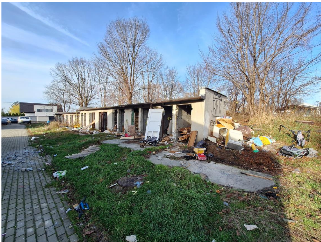
Fot. 25 Elewacja południowa
