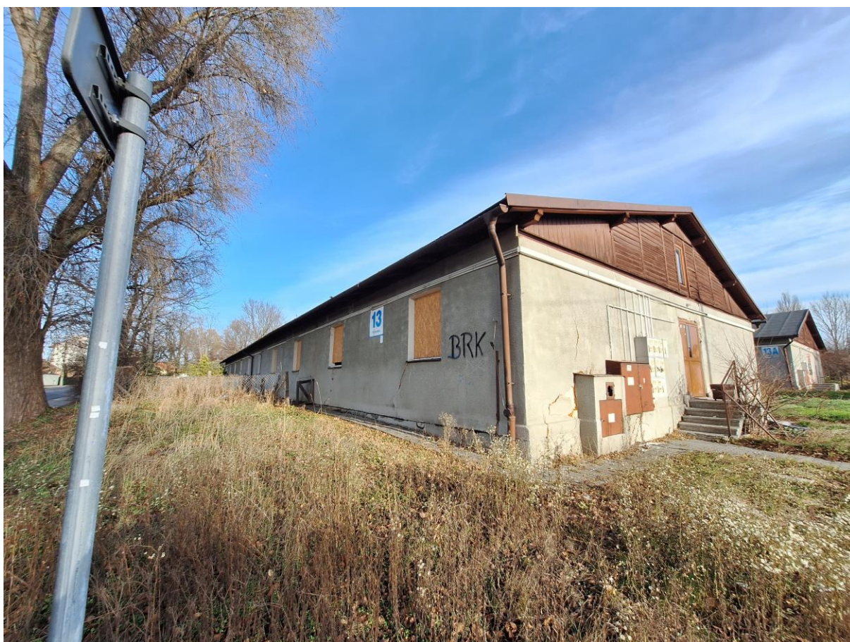
Fot. 17 Od lewej – elewacja zachodnia
