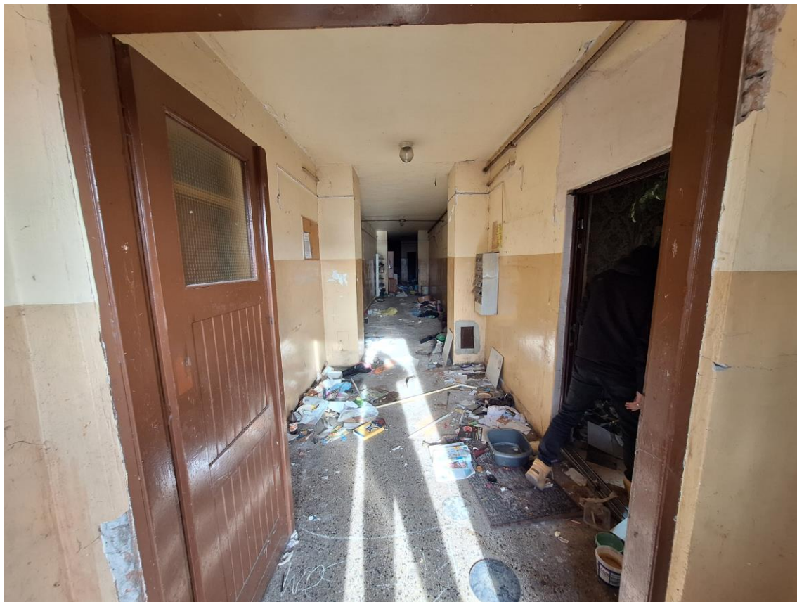
Fot. 18 Korytarz – wejście od strony południowej
