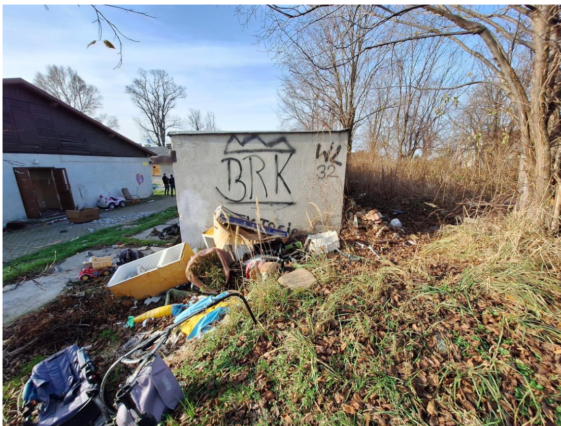
Fot. 26 Elewacja wschodnia
