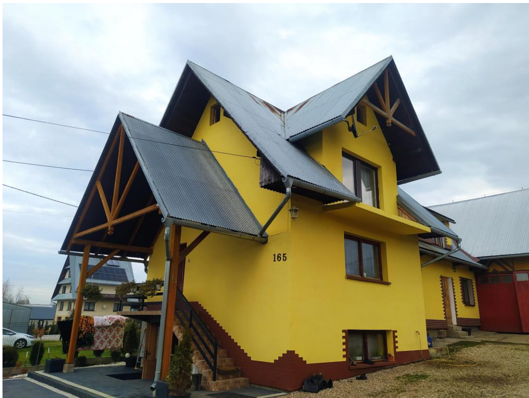
widok od strony W
