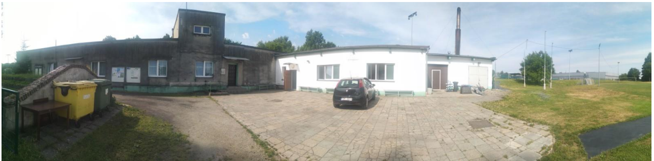
Fot.8 Widok panoramiczny na budynki podlegające przebudowie
