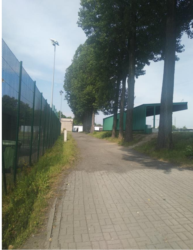
Fot. 3 Droga dojazdowa do projektowanej strefy parkingowej i budynków gospodarczych wraz z zadrzewieniem (do przebudowy wraz z odwodnieniem i umocnieniem skarp)
