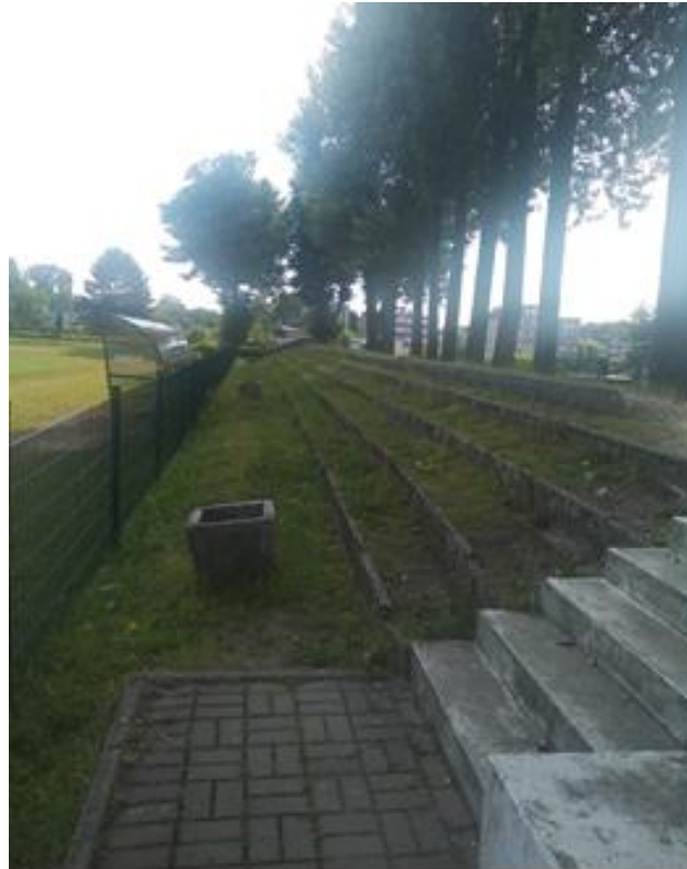
Fot.4. Istniejące trybuny przeznaczone do rozbiórki.
