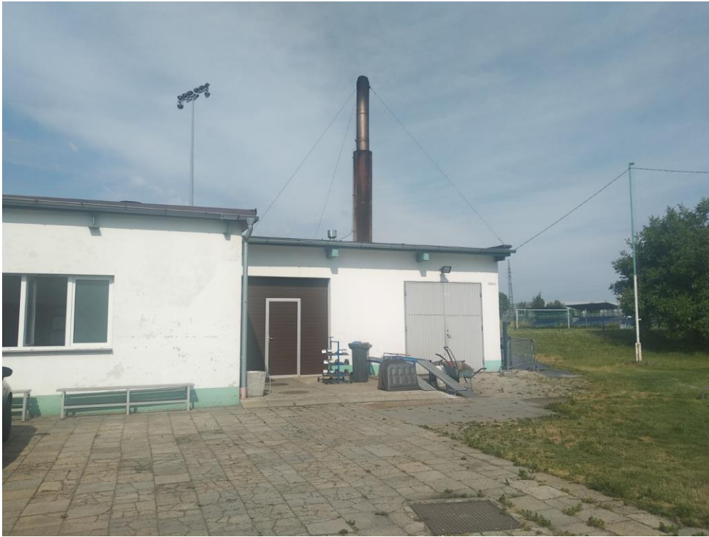
Fot. 7. Widok na istniejącą kotłownię wraz z pom. magazynowym (pralnia)
