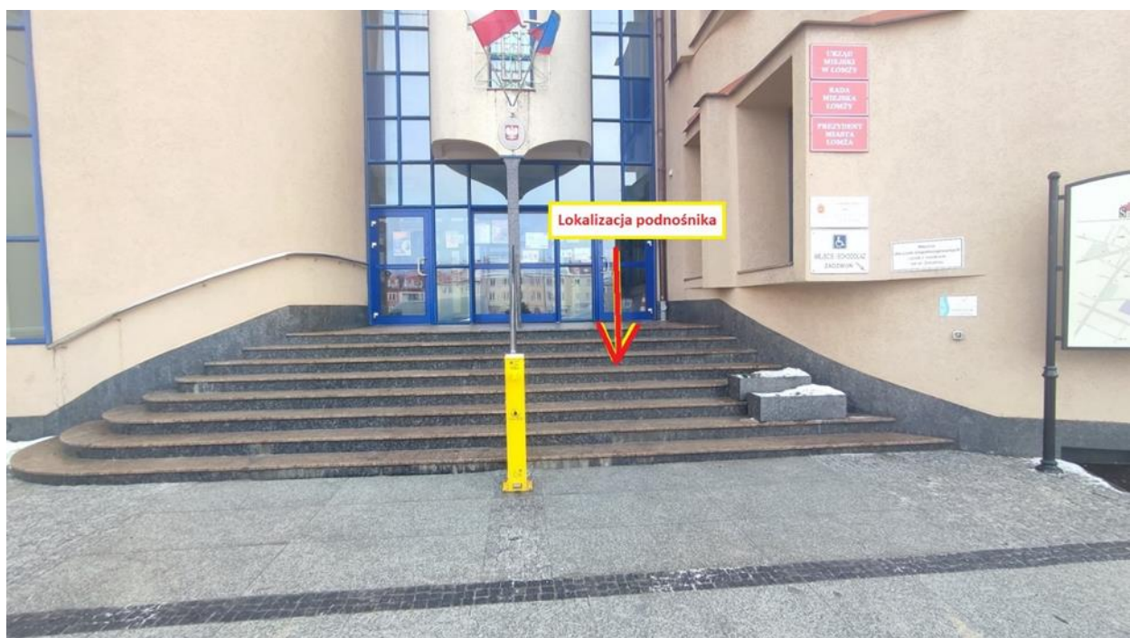
Fotografia Nr 1 – planowana lokalizacja podnośnika pionowego przy głównym reprezentacyjnym wejściu do budynku ratusza UM w Łomży.
