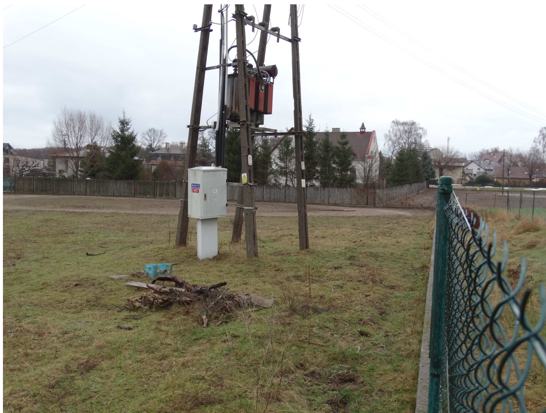
Fot. 1 Istniejąca słupowa stacja transformatorowa 15/0,4 kV/kV T-2487 „Mosty”
