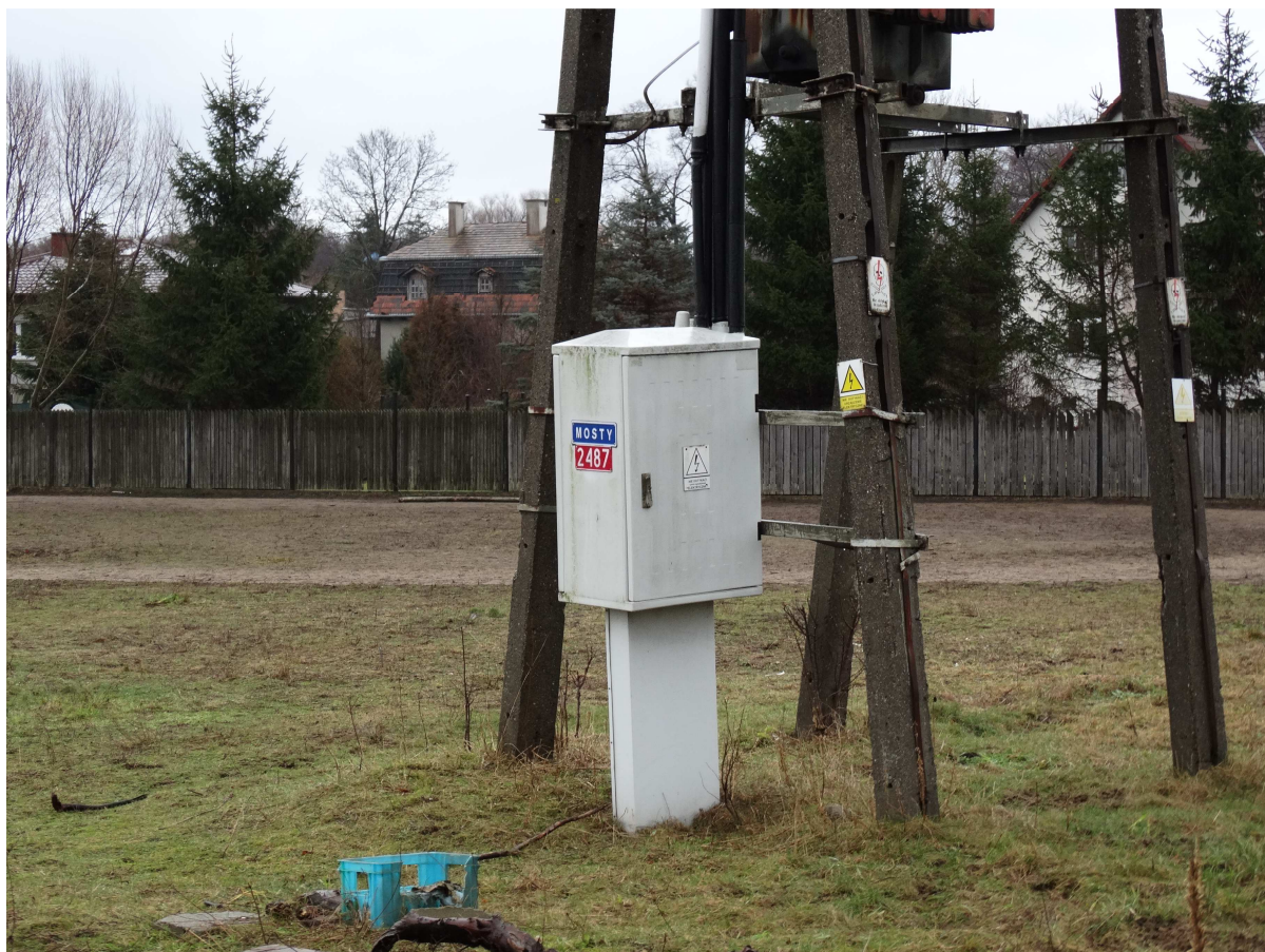
Fot. 3 Istniejąca słupowa stacja transformatorowa 15/0,4 kV/kV T-2487 „Mosty”
