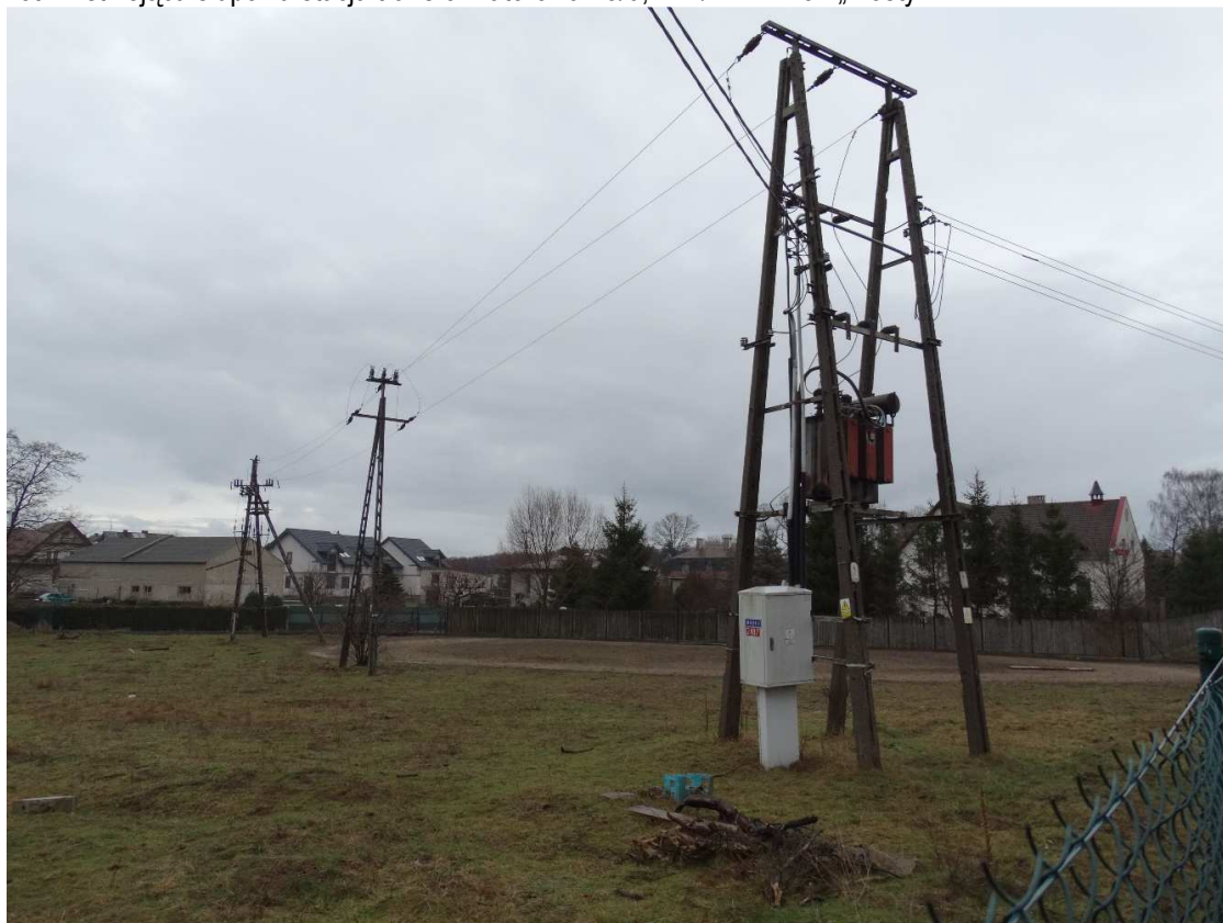
Fot. 2 Istniejąca słupowa stacja transformatorowa 15/0,4 kV/kV T-2487 „Mosty” oraz linia napowietrzna SN-15kV 5639 typu AFL-6 35 mm 2 wraz ze słupami nr 3 i 4
