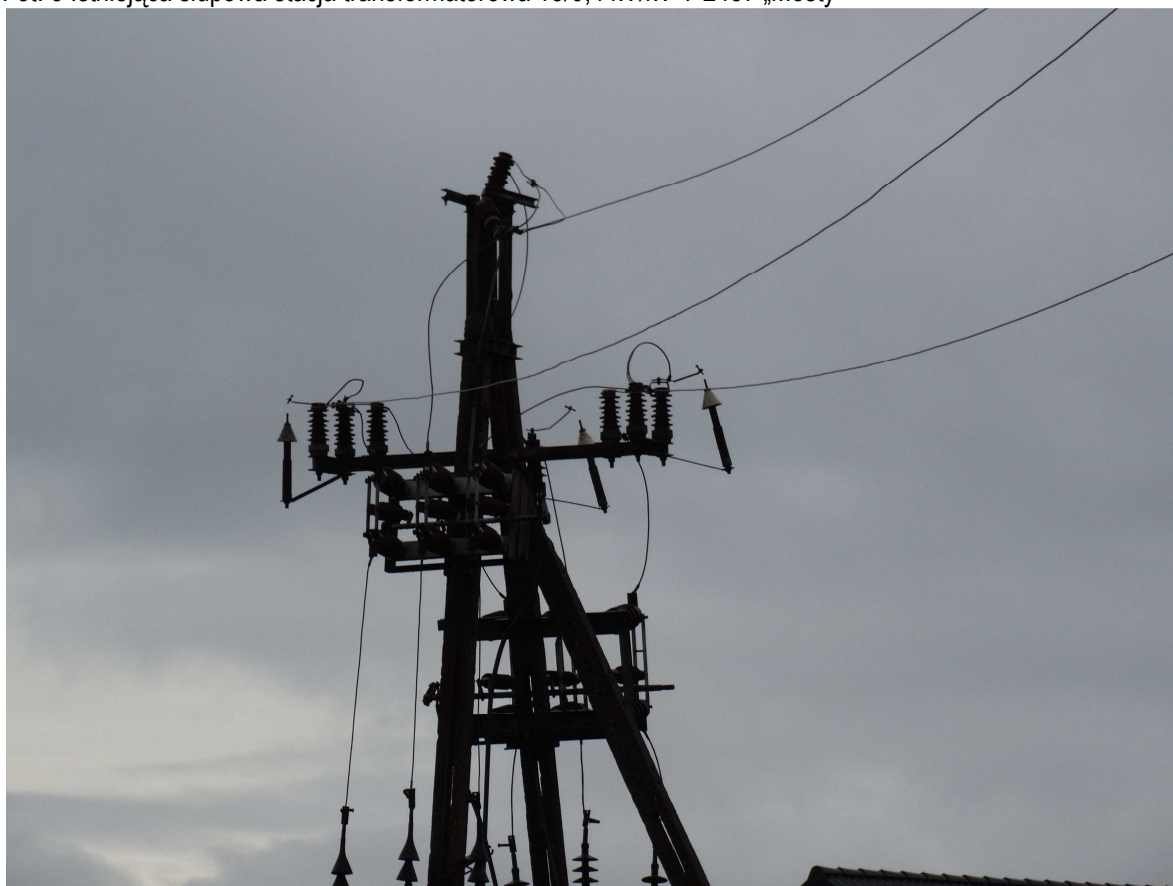
Fot. 4 St. Nr 3 linii napowietrznej SN-15kV 5639 typu AFL-6 35 mm 2
