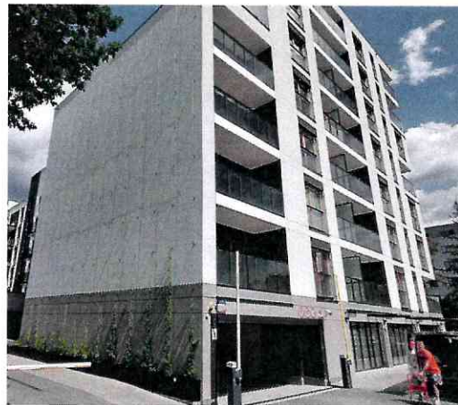
Rozmieszczenie linek na elewacji
