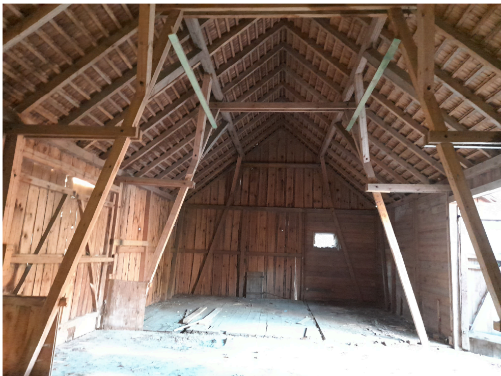
Zdjęcie nr 3 – Budynek stodoły
