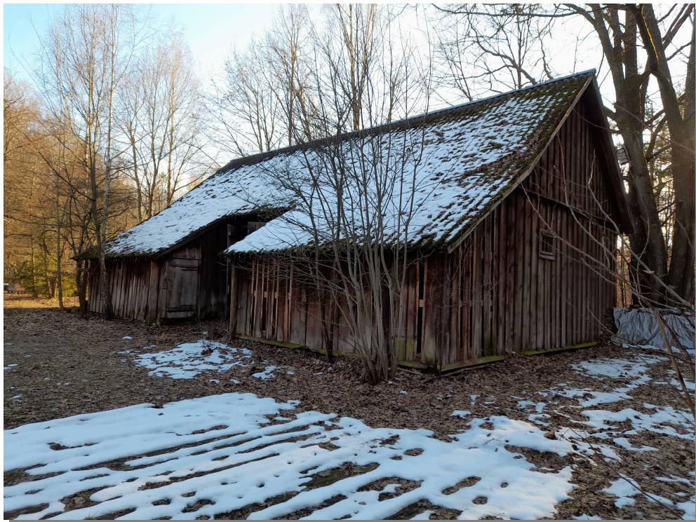
Zdjęcie nr 2 – Budynek stodoły
