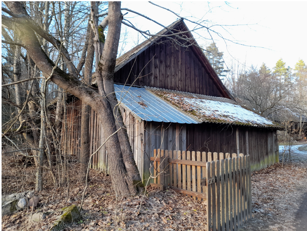
Zdjęcie nr 6 – Budynek stodoły
