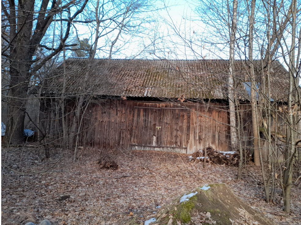
Zdjęcie nr 7 – Budynek stodoły
