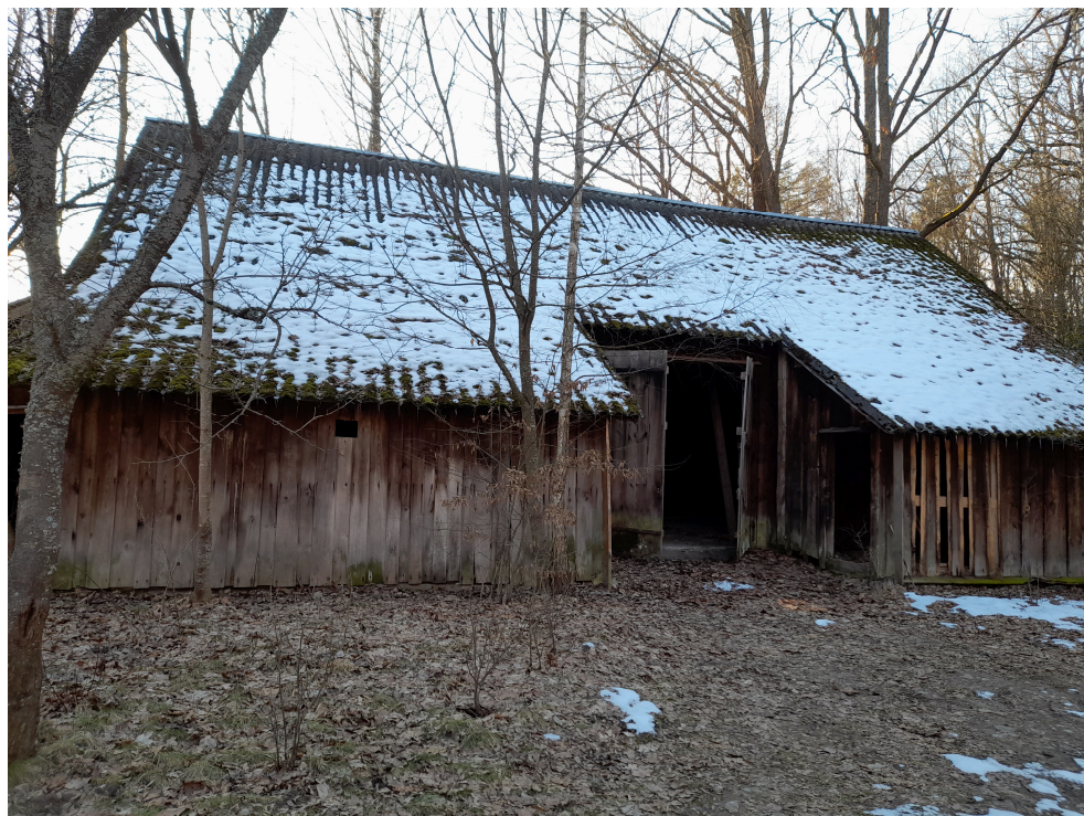
Zdjęcie nr 1 – budynek stodoły
