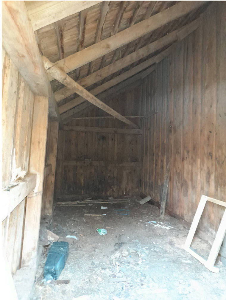
Zdjęcie nr 4 – Budynek stodoły
