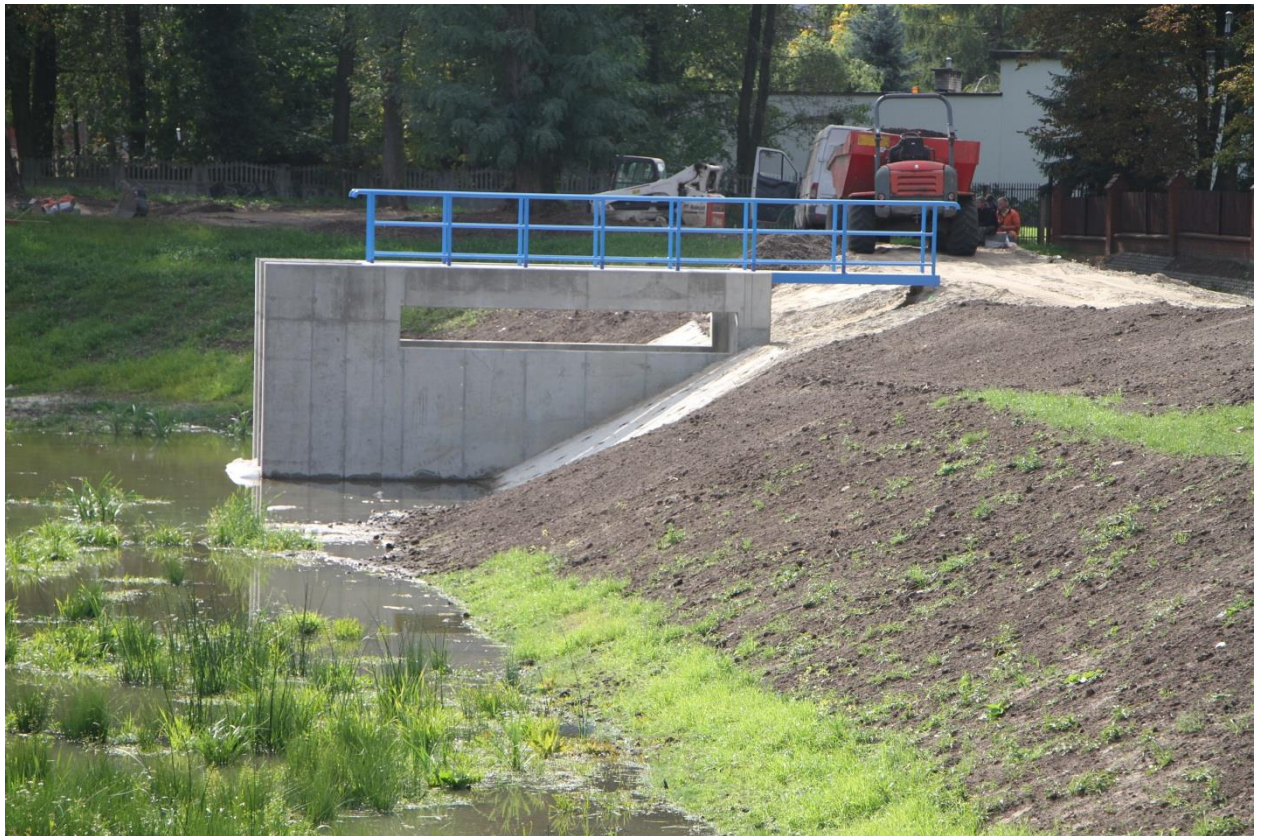
Zdjęcie poglądowe wieży spustowo-przelewowej
