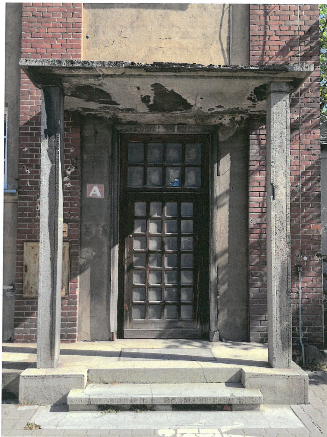
Ilustracja 1: Widok na zadaszenie wejścia od ul. Bukowskiej
