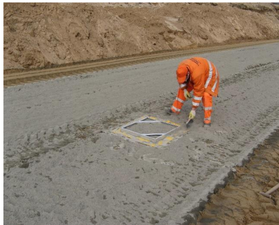
miatanie z tacki pomiarowej spoiwa znajdującego się poza szablonem
