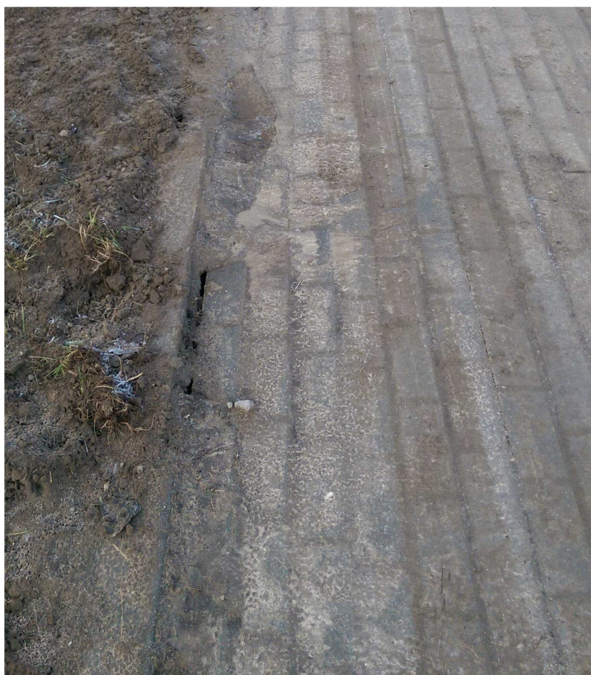
Fot. 8 Uszkodzenia wzdłuż krawędzi drogi
