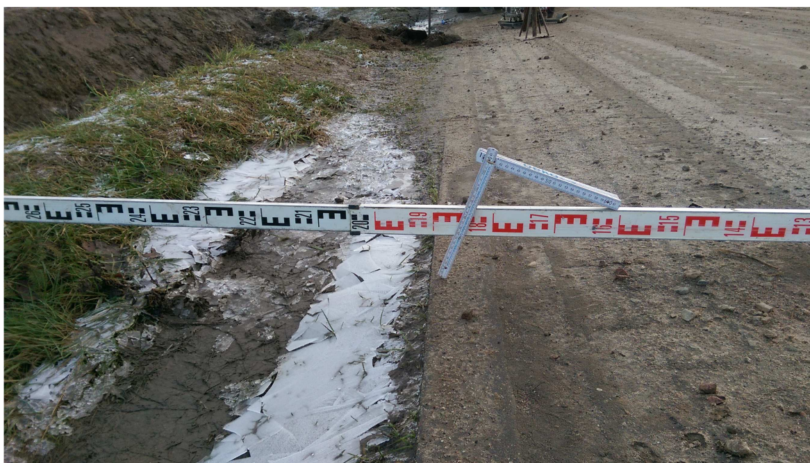
Fot. 4 Osiadania nawierzchni wzdłuż krawędzi drogi
