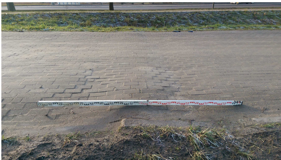
Fot. 6 Osiadania nawierzchni w obrębie przepustu
