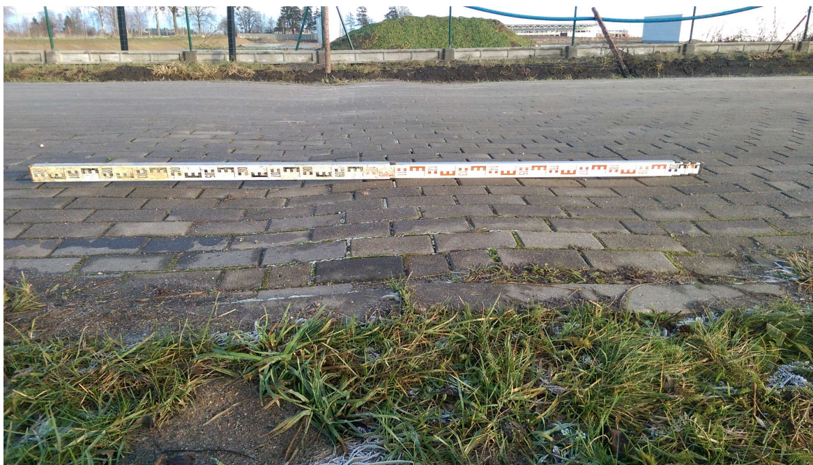
Fot. 5 Osiadania nawierzchni w obrębie przepustu
