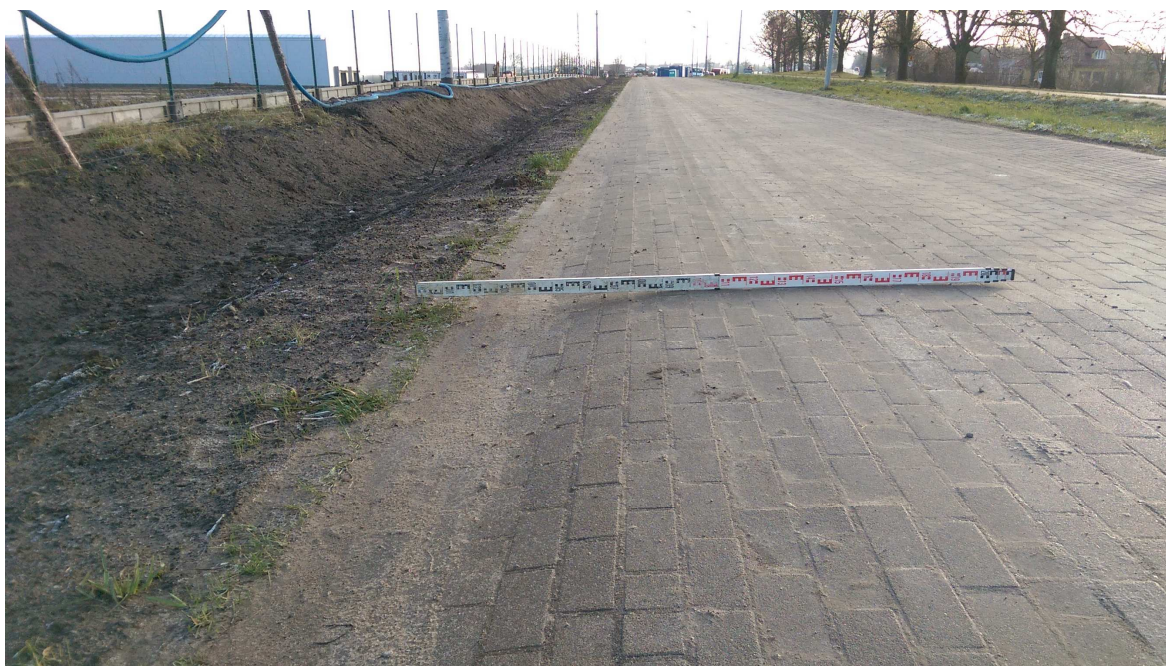
Fot. 3 Osiadania nawierzchni wzdłuż krawędzi drogi
