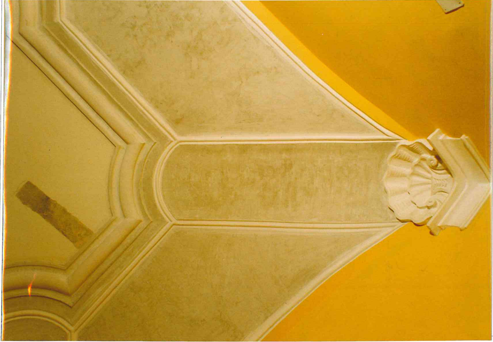
Fot. 1. Urząd Miejski w Poznaniu, Sala Sesyjne parteru Sala "Mała" przy Dużej Sali Sesyjnej Odkrywka na lustrze plafonu.
