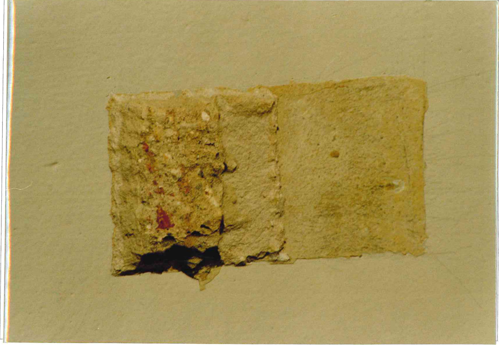
Fot. 14. Urząd Miejski w Poznaniu, Sale Sesyjne Sale Sesyjne odkrywka przedstawiająca stan ścian bocznych sal.
