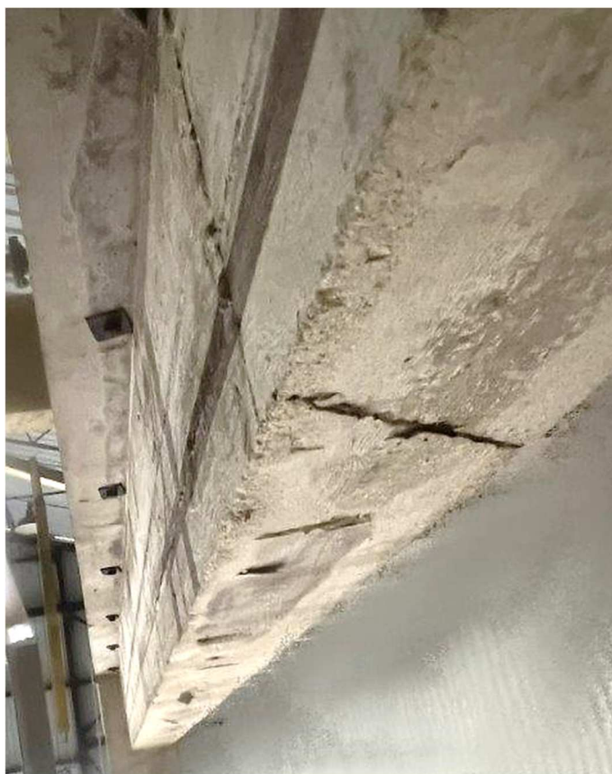
Zdj. 4 widok belki żelbetowej torowiska
