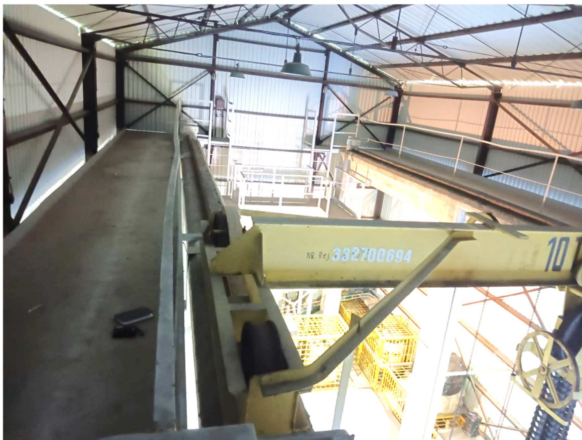
Zdj. 3 widok torowiska z poziomu podestów roboczych
