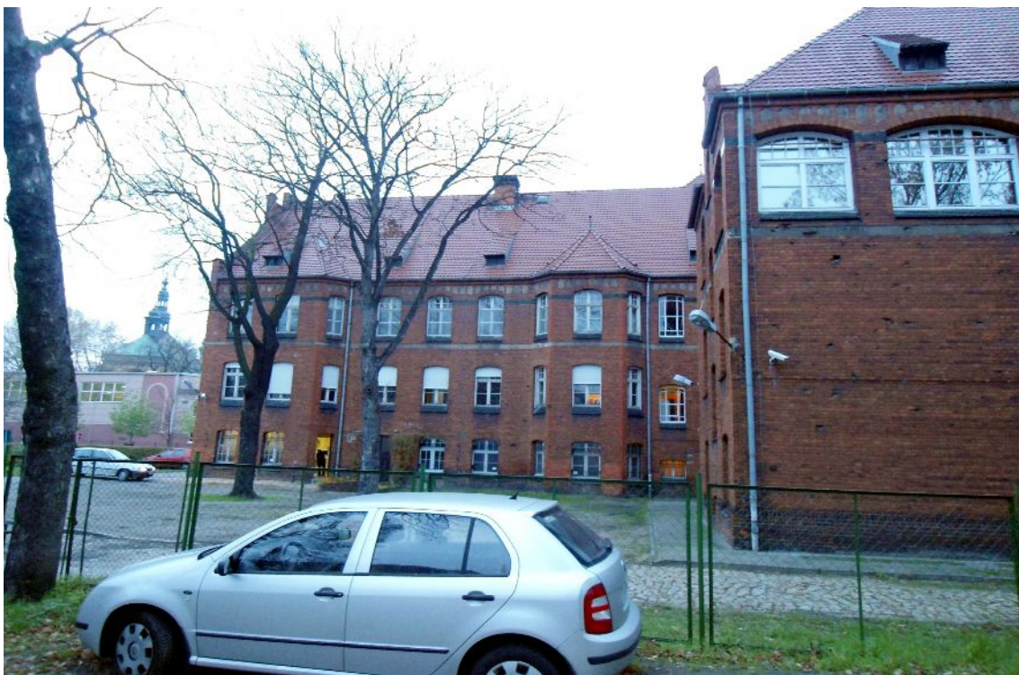
Zdjęcie nr 6. Elewacja południowo - wsch. przedstawiająca regularność okien. Na dachu widoczne okna mansardowe.
