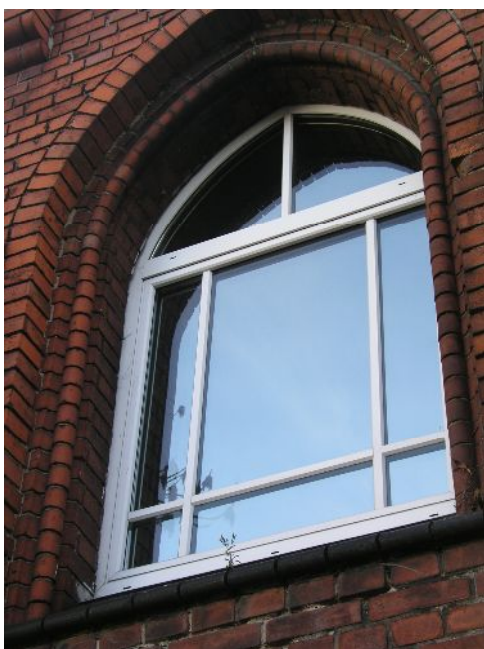
Zdjęcie nr 15. Okna z pcv w wykuszu na kondygnacji pierwszego piętra o strzelistych nadprożach.
