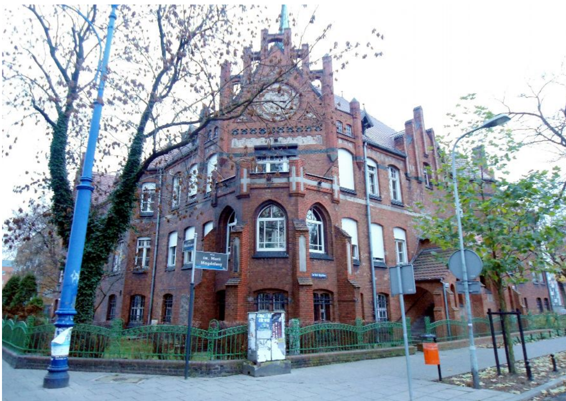
Zdjęcie nr 4. Elewacja narożna z oknami w wykuszu na piętrze I o strzelistym nadprożu. Na wysokości piętra II w wykuszu widoczne okno z kasetą naścienną od rolety zewnętrznej i z płaskim nadprożem.
