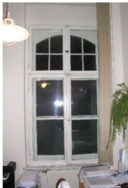
Zdjęcie nr 11. Okno na kondygnacji pierwszego pietra. W kwaterach nadślemiennych podział skrzydeł okiennych podzielony jest na cztery pola a podślemiennych na dwa pola.
