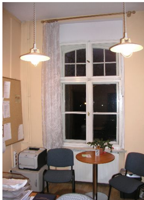
Zdjęcie nr 11. Okno na kondygnacji pierwszego pietra. W kwaterach nadślemiennych podział skrzydeł okiennych podzielony jest na cztery pola a podślemiennych na dwa pola.
