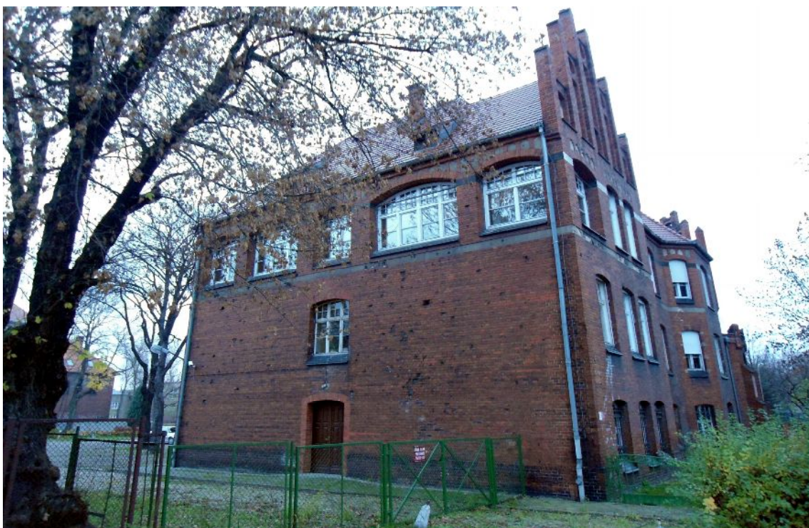
Zdjęcie nr 8. Elewacja południowo - wschodnia. Widoczne okna na kondygnacji trzeciej, prawdopodobnie zamontowane w miejsce otworów loggi.
