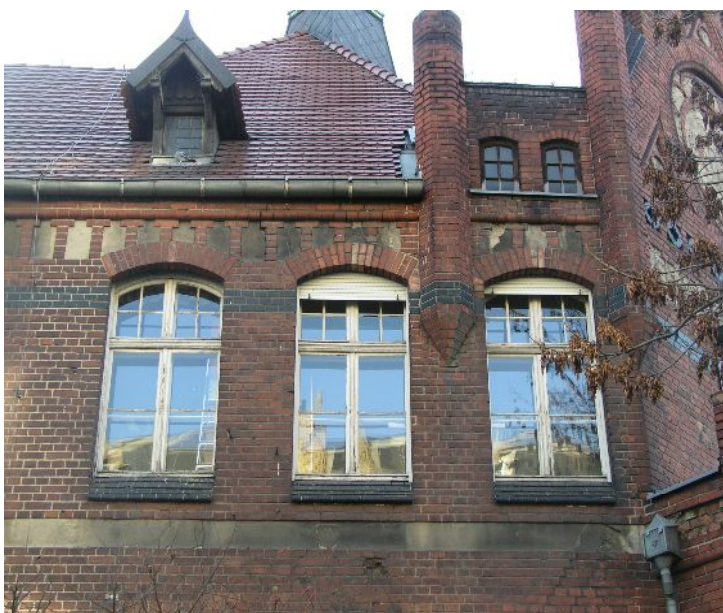
Zdjęcie nr 11. Okno na kondygnacji pierwszego pietra. W kwaterach nadślemiennych podział skrzydeł okiennych podzielony jest na cztery pola a podślemiennych na dwa pola.
