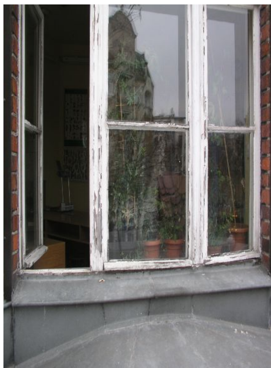
Zdjęcie nr 16. Okno w wykuszu na kondygnacji drugiego piętra z płaskim nadprożem oraz z kasetą zewnętrzną.
