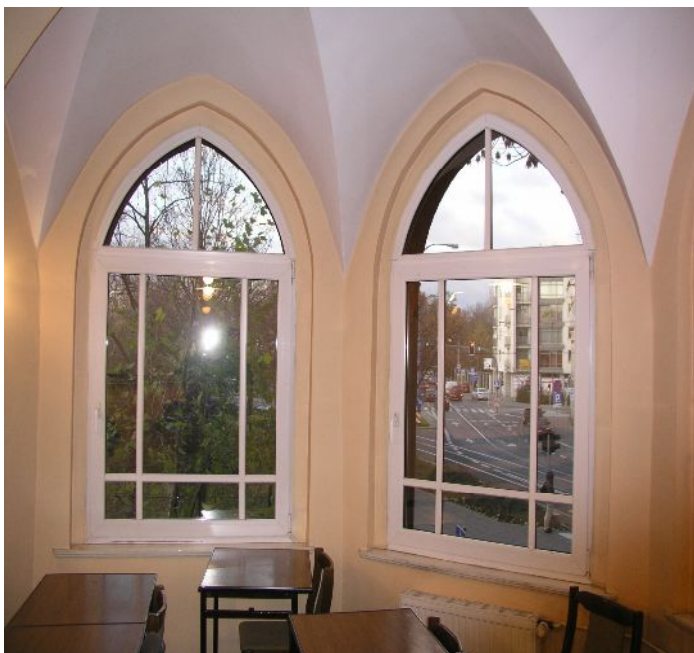
Zdjęcie nr 15. Okna z pcv w wykuszu na kondygnacji pierwszego piętra o strzelistych nadprożach.
