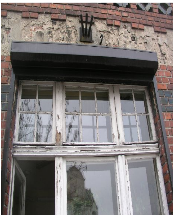
Zdjęcie nr 16. Okno w wykuszu na kondygnacji drugiego piętra z płaskim nadprożem oraz z kasetą zewnętrzną.
