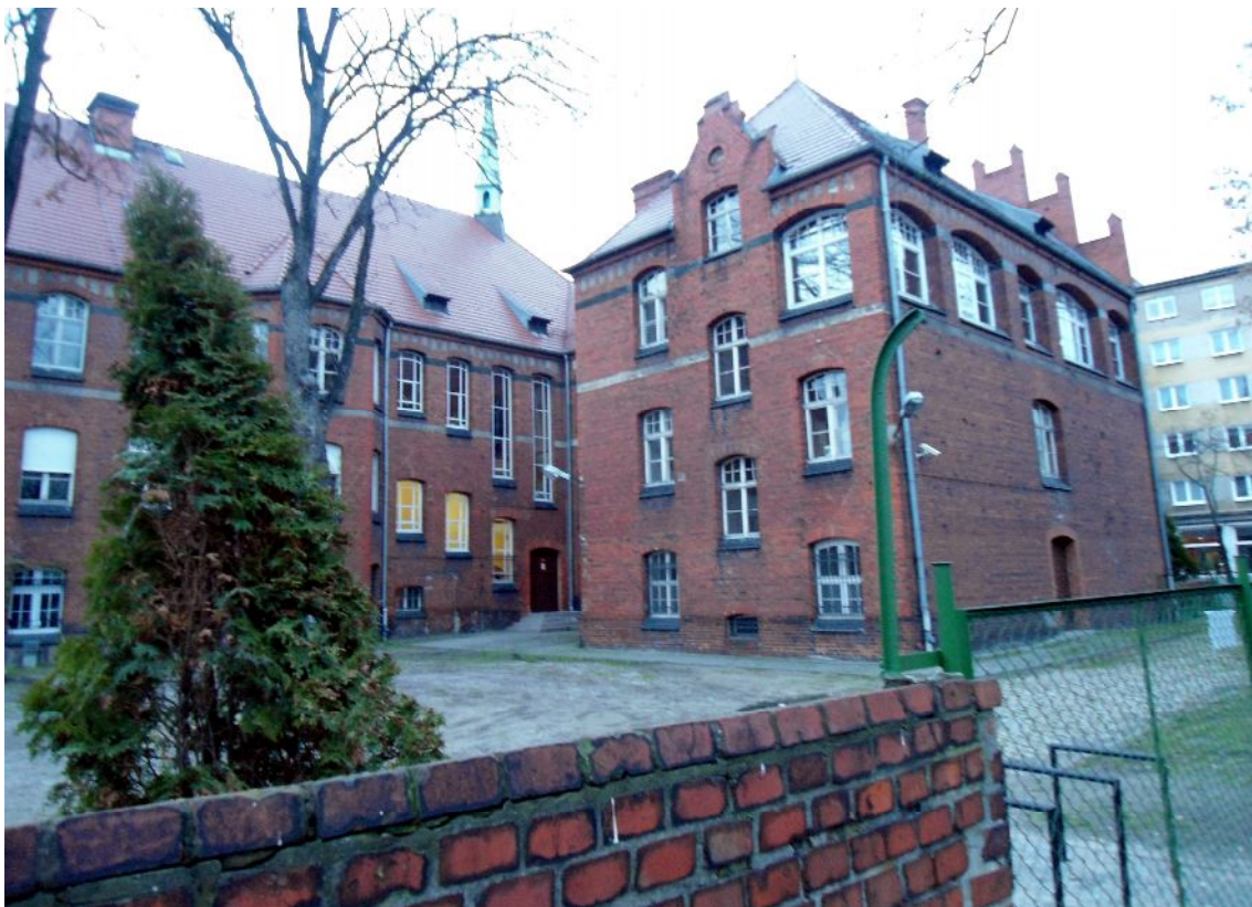
Zdjęcie nr 5. Okna głównej klatki schodowej o zróżnicowanych wysokościach na elewacji południowo - wschodniej.
