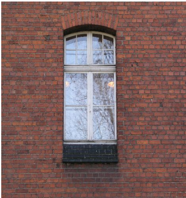
Zdjęcie nr 11. Okno na kondygnacji pierwszego pietra. W kwaterach nadślemiennych podział skrzydeł okiennych podzielony jest na cztery pola a podślemiennych na dwa pola.
