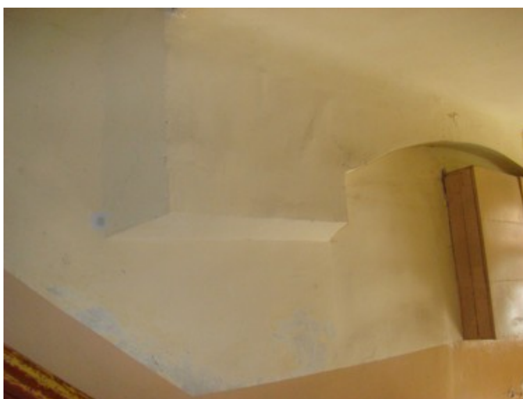
fot. 6: podcięte w wyniku przebudowy wsparcie łuku tworzącego niszę na północnej ścianie parteru
