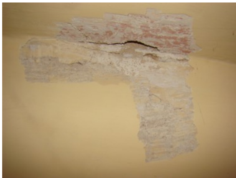
fot. 11: odkrywka na ścianie i na podbitce schodów na poziomie pierwszego półpiętra; widoczna ceglasto-czerwona malatura podbitki
