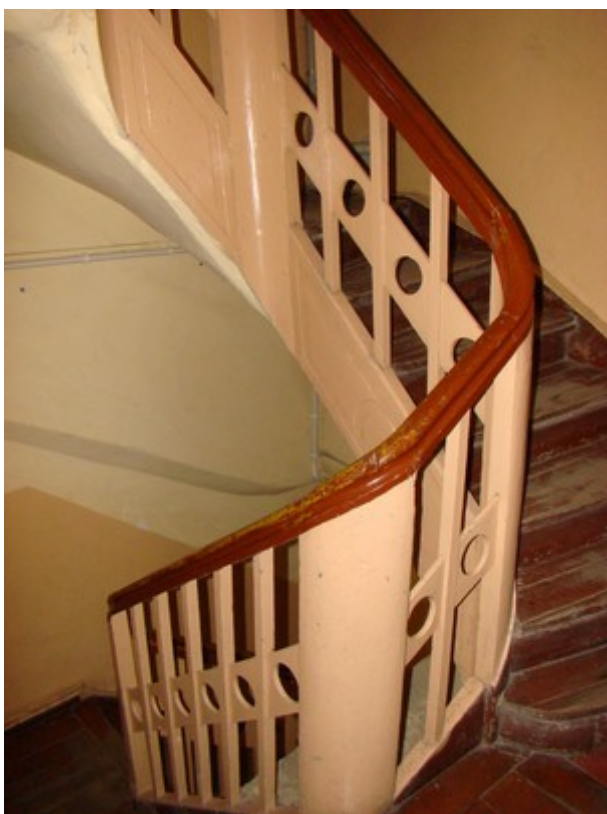
fot. 3: biegi schodów widziane z I piętra
