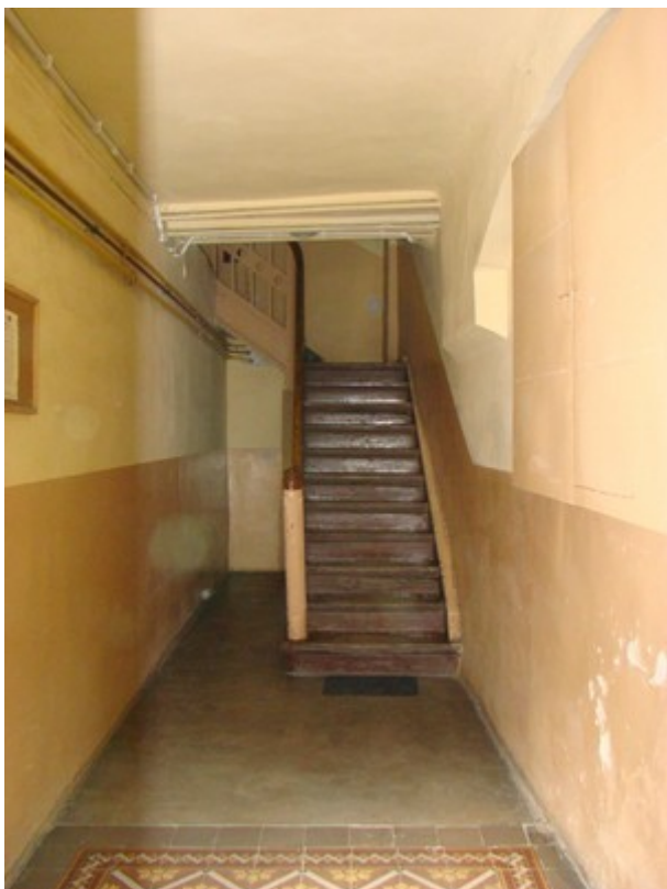
fot. 1: widok na klatkę schodową ze strony drzwi frontowych
