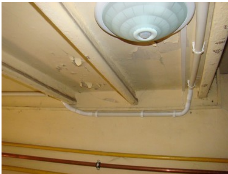
fot. 5: dźwigary wykonane z szyn, strop parteru
