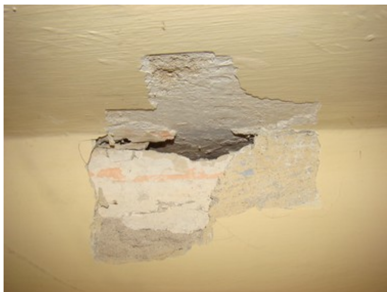
fot. 12: odkrywka na południowej, wtórnej ścianie I piętra i na suficie; widoczne pobiałe w szczelinie w grubości ściany
