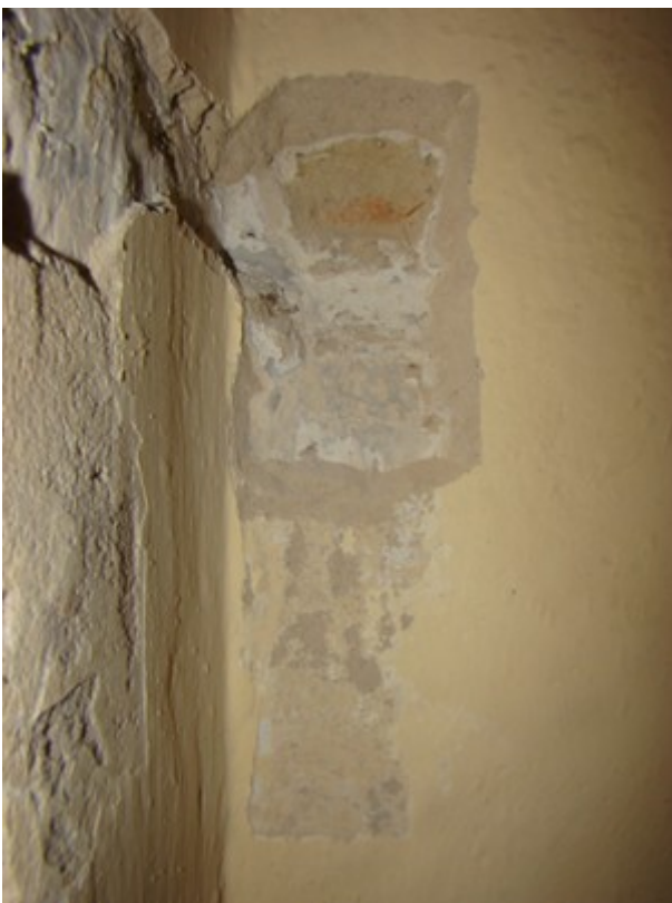
fot. 8: odkrywka na szczycie na II piętrze, strona prawa; widoczny najstarszy tynk z pobiałami, odsłonięty spod kolejnej w chronologii wyprawy ściany
