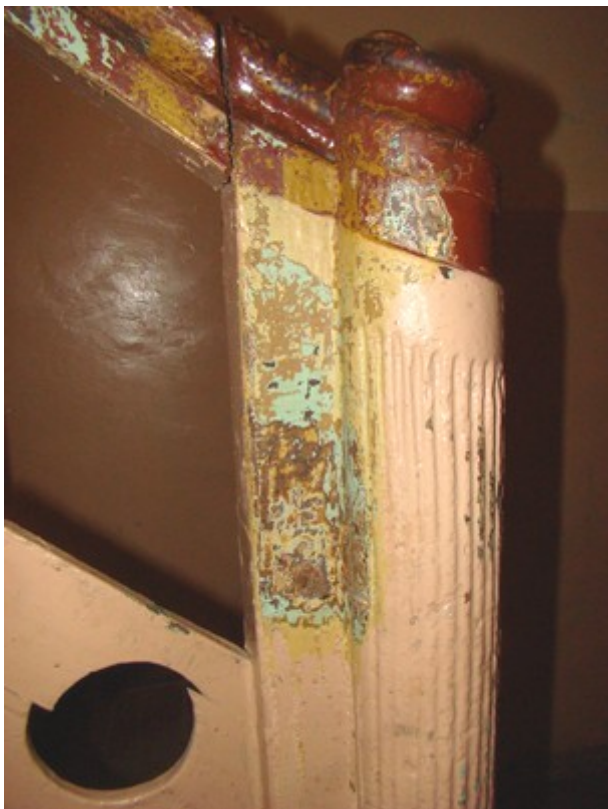
fot. 14: odkrywki malatur na filarze balustrady schodów
