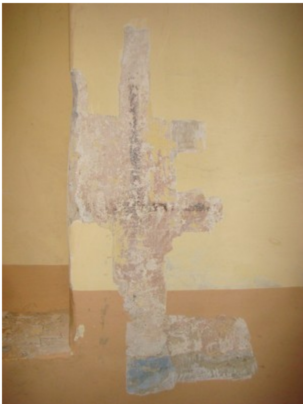
fot. 10: odkrywka w przejściu na podwórze - zachodnia część korytarza; widoczne ślady czerwonej malatury z brązową linią tworzącą podziały architektoniczne, w dolnej partii późniejsze warstwy malatur
