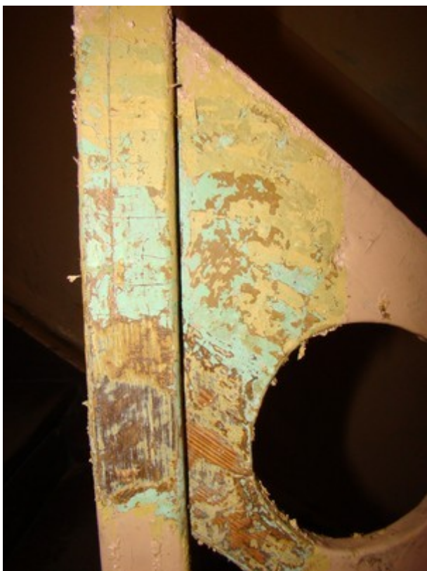
fot. 16: odkrywka na balustradzie schodów
