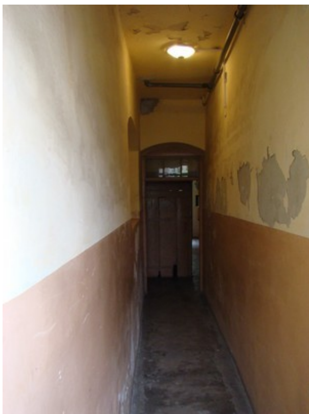
fot. 2: widok na klatkę schodową ze strony drzwi podwórzowych
