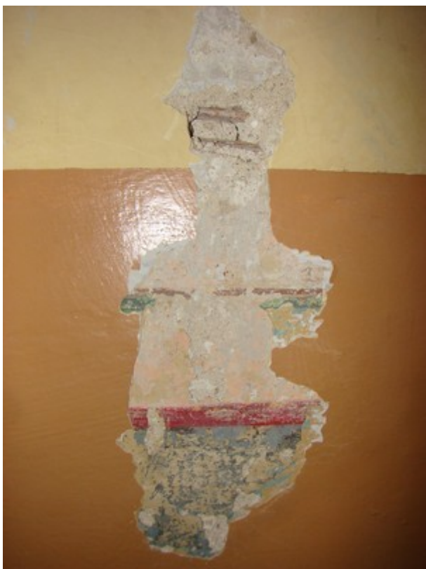
fot. 13: odkrywka na pd. ścianie piętra; widoczny tynk na trzcinie i pokrywające go kolejne malatury, w tym różne koncepcje lamperii
