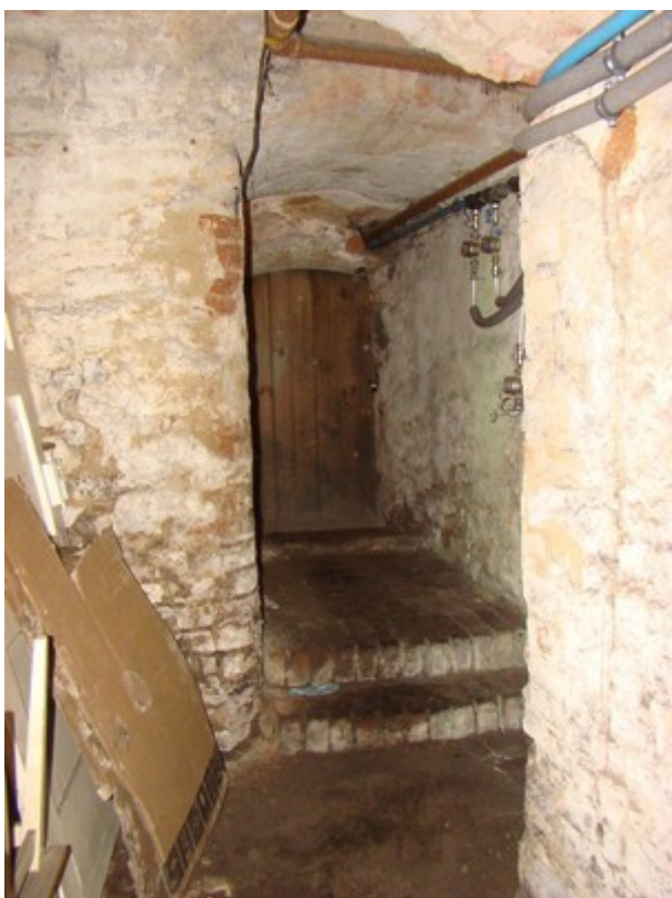
fot. 20: widok piwnic pod kamienicą
