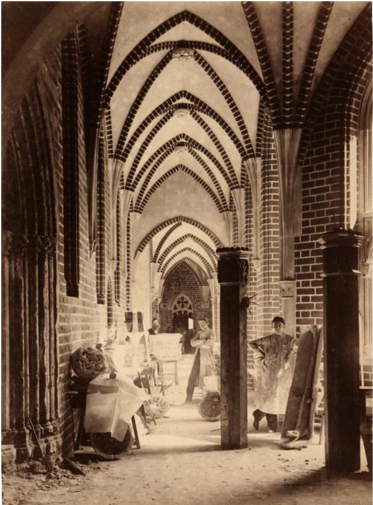
Ilustracja 6 Prace przy rekonstrukcji krużganków i wnętrzu Zamku Wysokiego, Marienburg Baujahr 1986 r.
