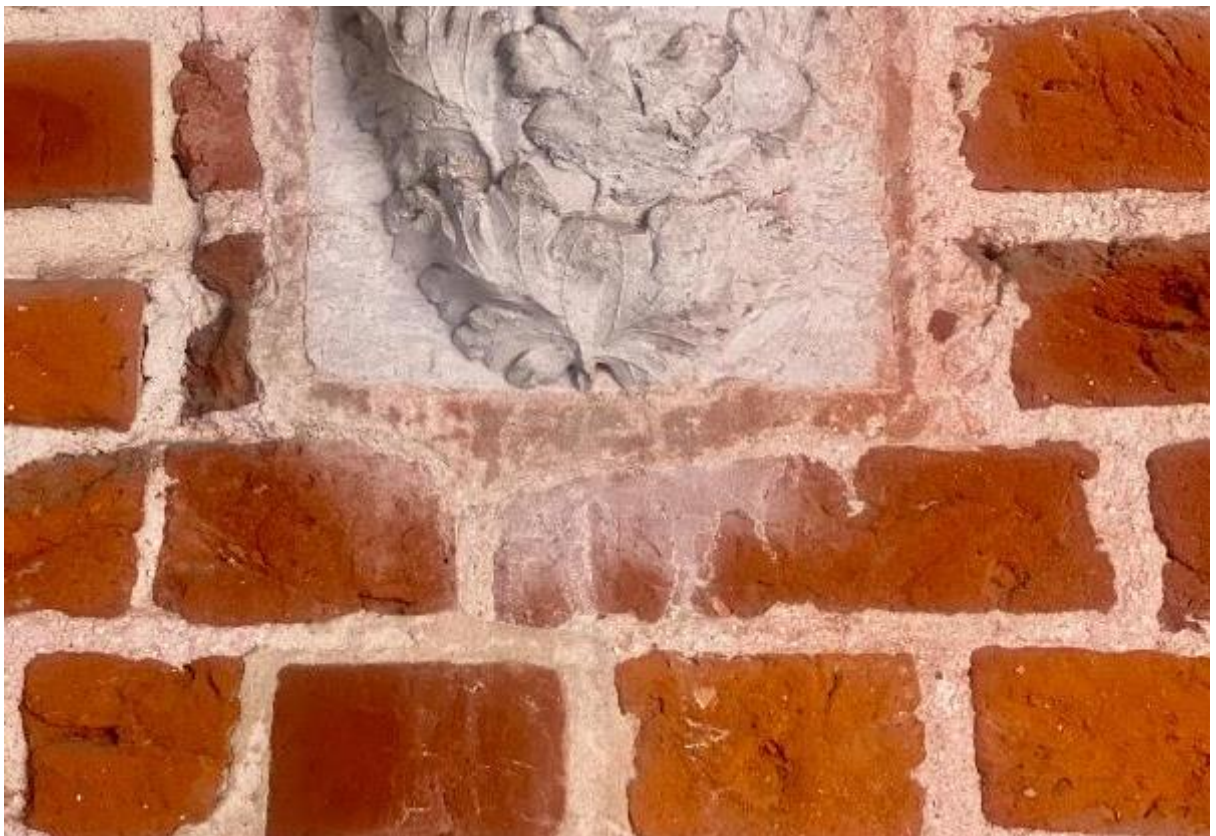
Ilustracja 26 Zabielenia węglanowe widoczne poniżej kamiennej konsoli.
