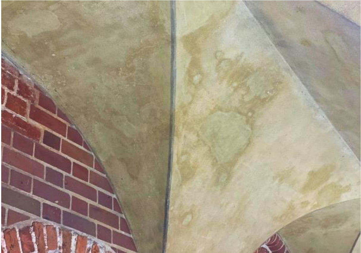
Ilustracja 45 Część tynków wymaga scalenia kolorystycznego.
