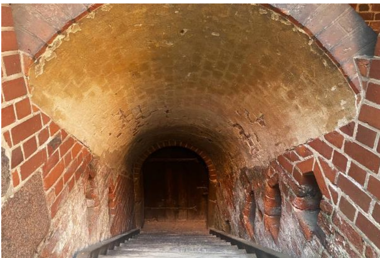
Ilustracja 42 Zejście do piwnic.
