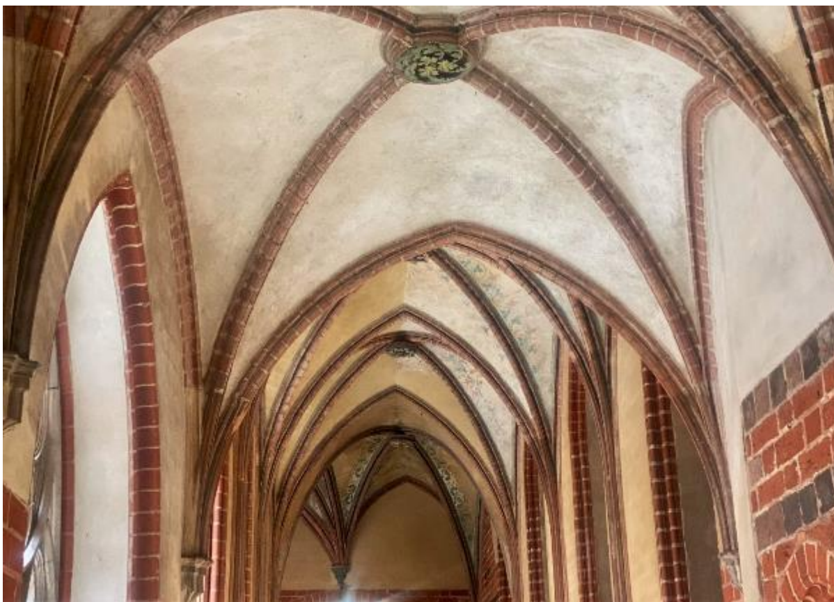
Ilustracja 20 Sklepienia częściowo pokryte zaprawą cementowo-wapienną.
