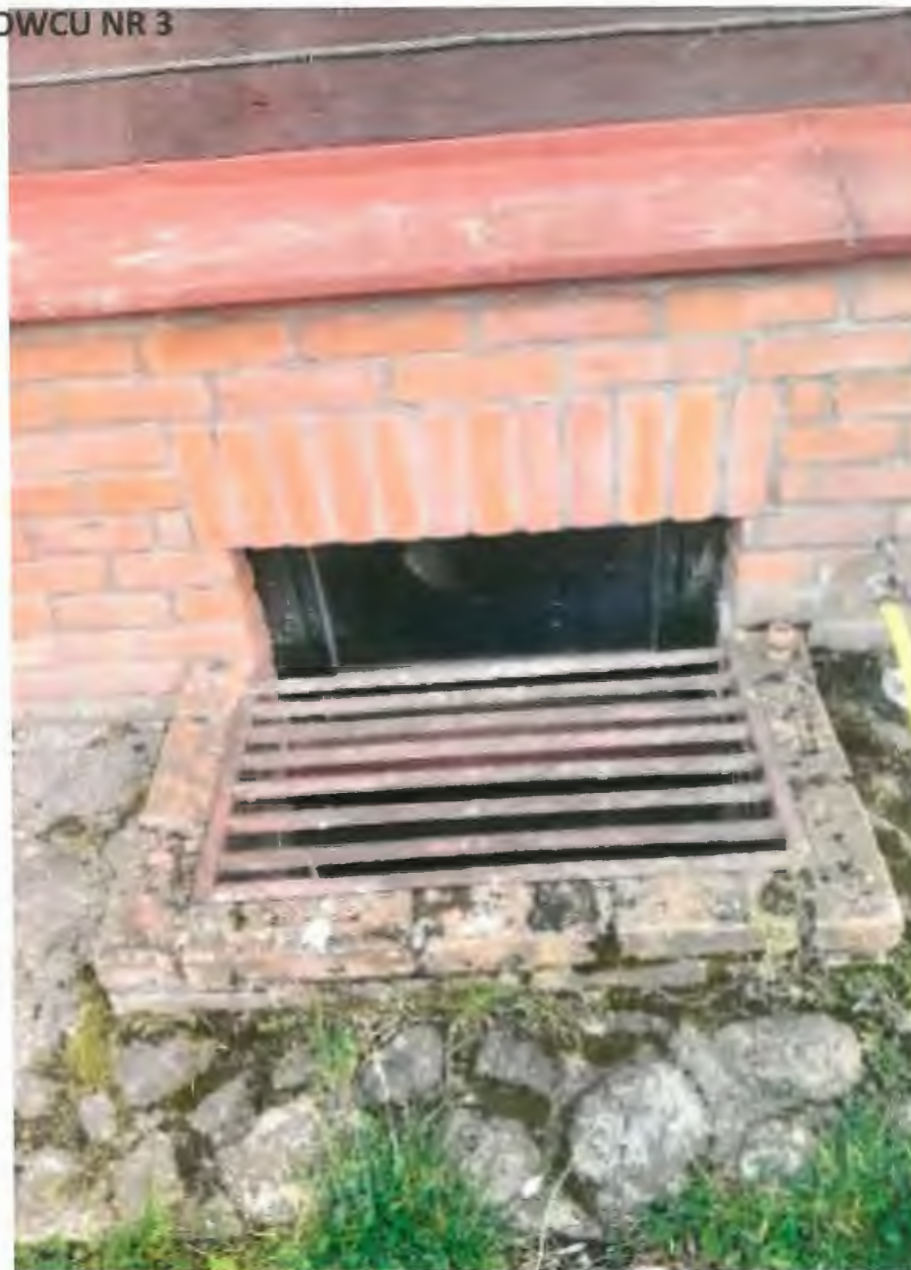
Widok obudowy okienka piwnicznego
