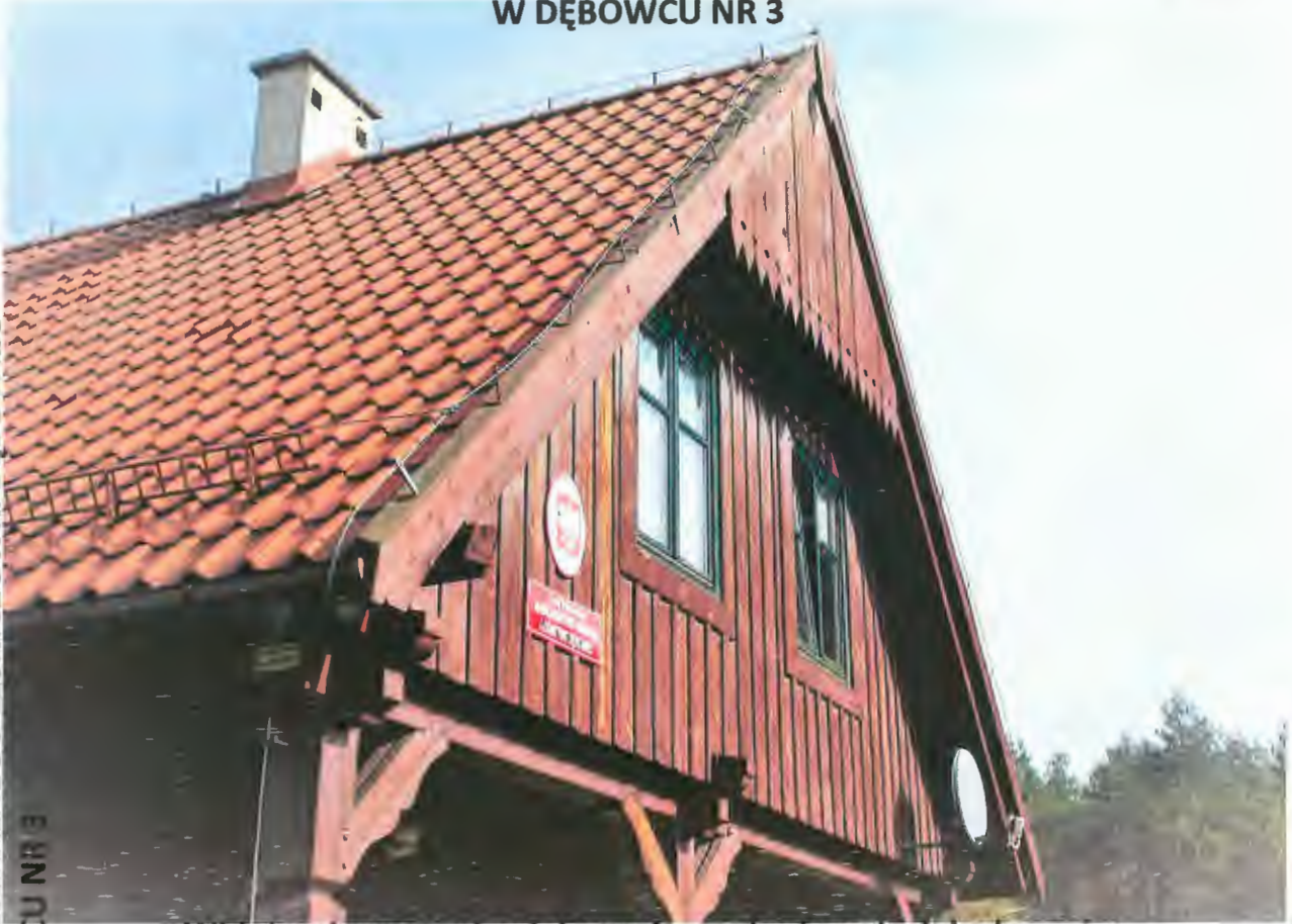
Widok zniszczonych wiatrownic na skraju połaci dachowej
