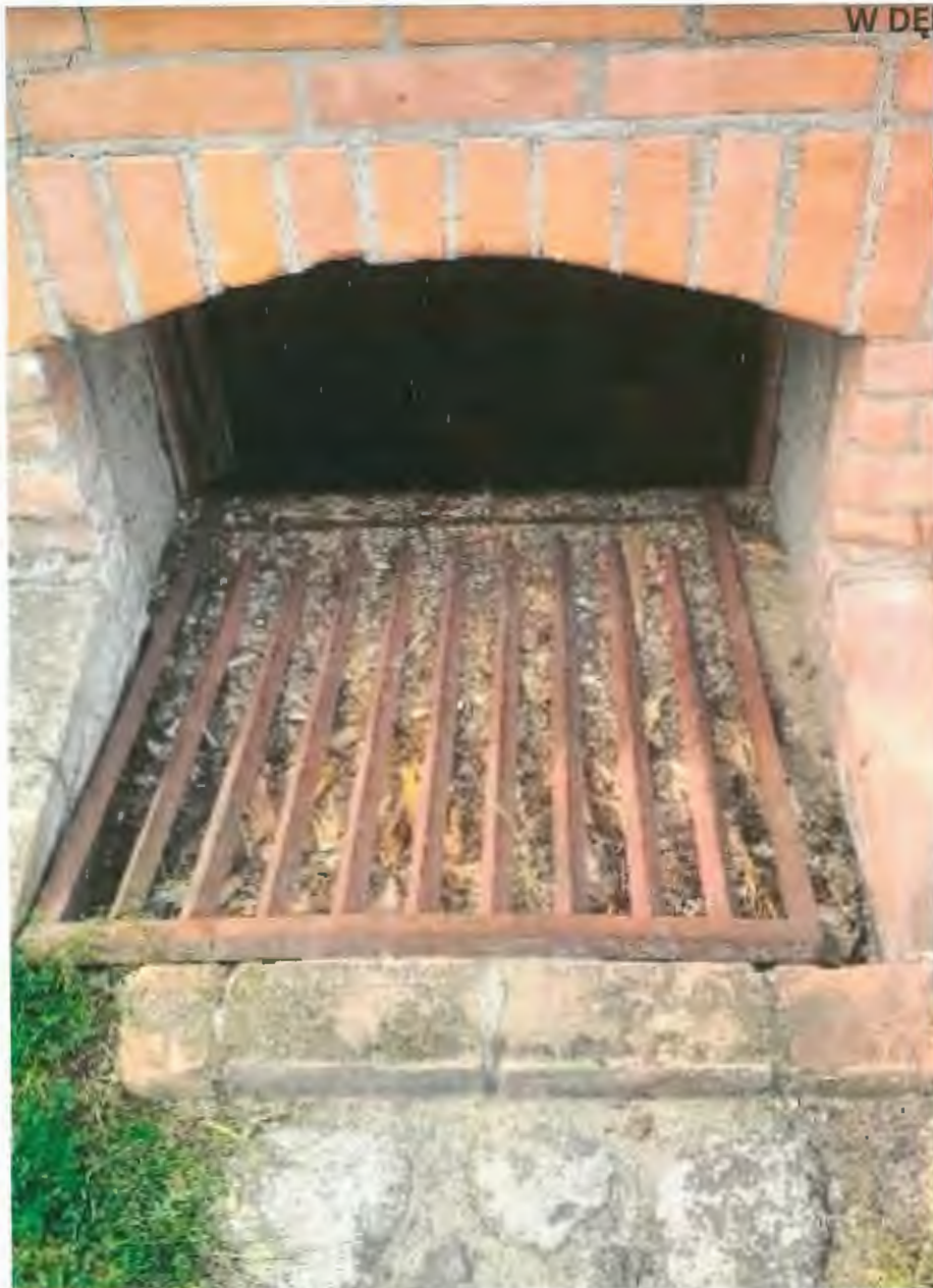
Widok obudowy wsypu opału
