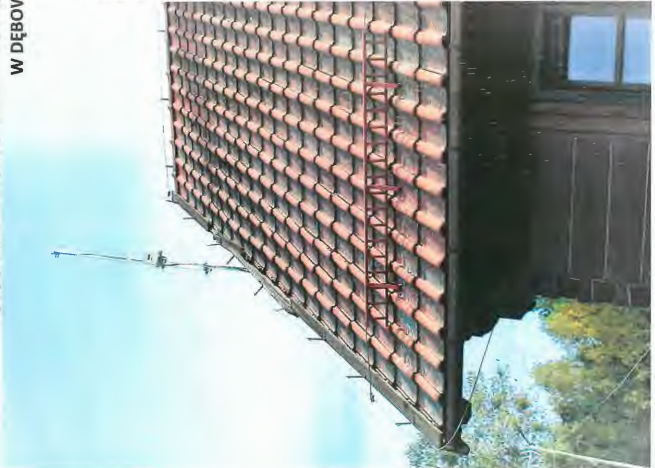
Widok zniszczonych wiatrownic na skraju połaci dachowej
