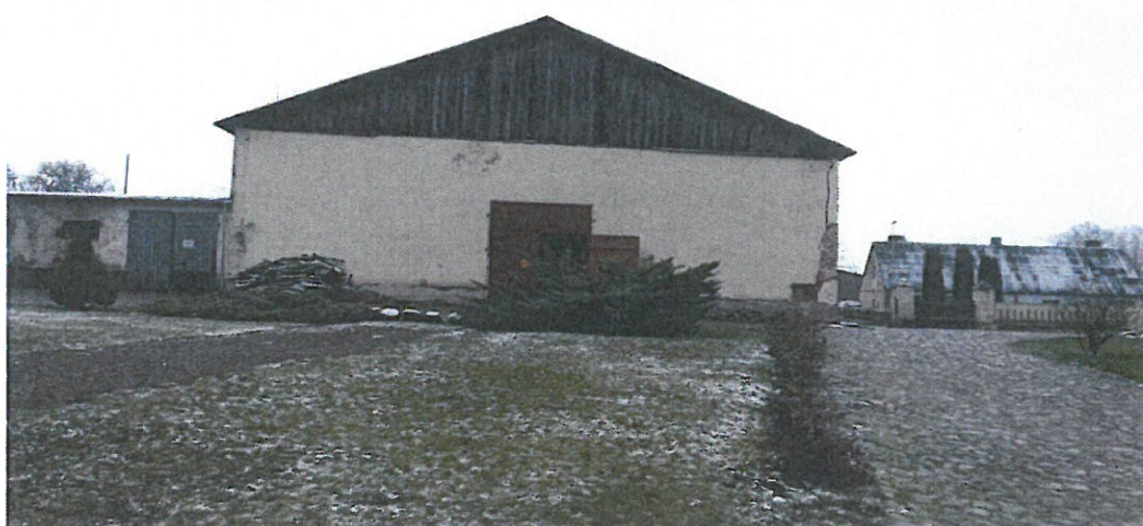
Fot.5. Elewacja północno-zachodnia zabytkowej stodoły
