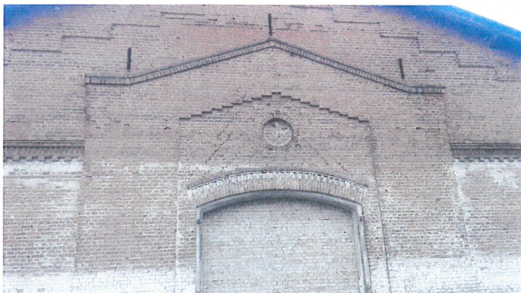
Fot.7. Detale architektoniczne elewacji południowo-wschodniej
