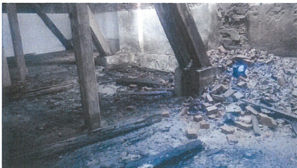
Fot.24. Oparcie zastrzałów na samodzielnych fundamentach
