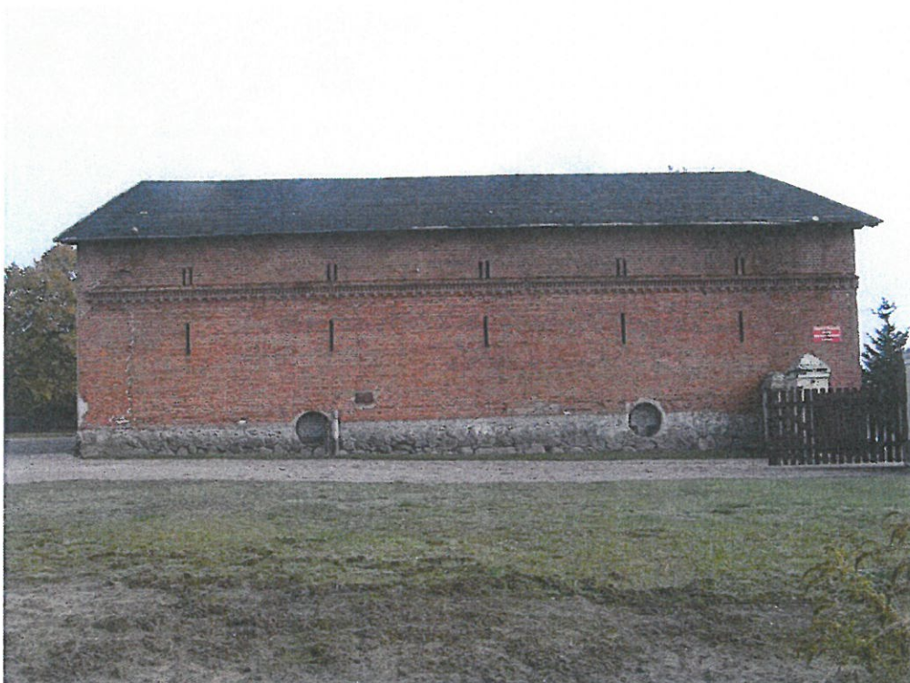
Fot.4. Elewacja południowo-zachodnia przedmiotowego budynku
