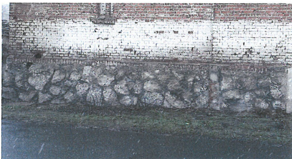
Fot.9. Ściana fundamentowa kamienna od strony drogi powiatowej o wysokości 1,40m
