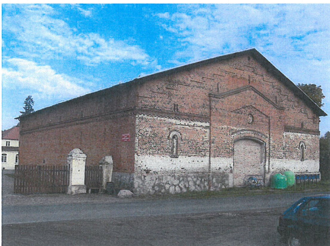
Fot.3. Elewacja południowo-wschodnia stodoły przyległa do drogi powiatowej
