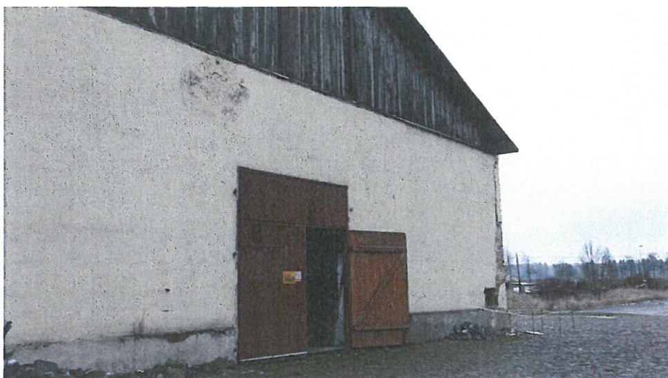
Fot. 10. Ściana szczytowa pokryta tynkiem
