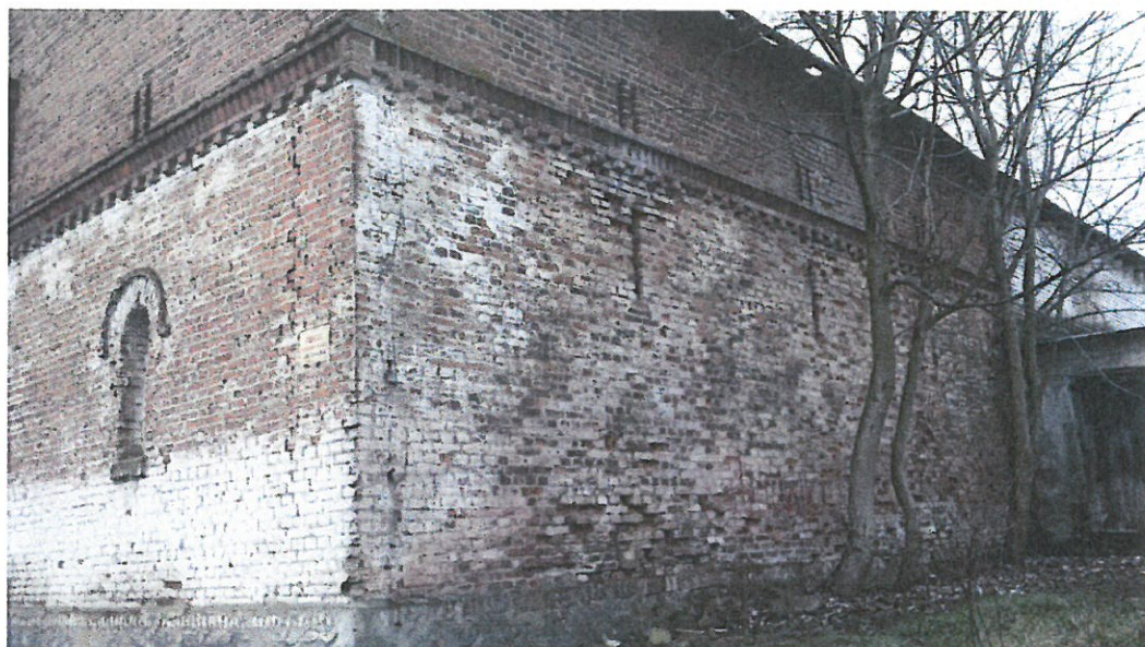
Fot.6. Elewacja północno-zachodnia zabytkowej stodoły
