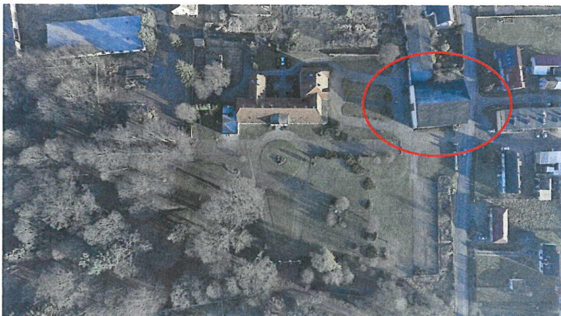
Fot. 1. Widok z góry Zespołu Dworsko-Parkowego w Kulicach z zaznaczonym budynkiem zabytkowej stodoły
