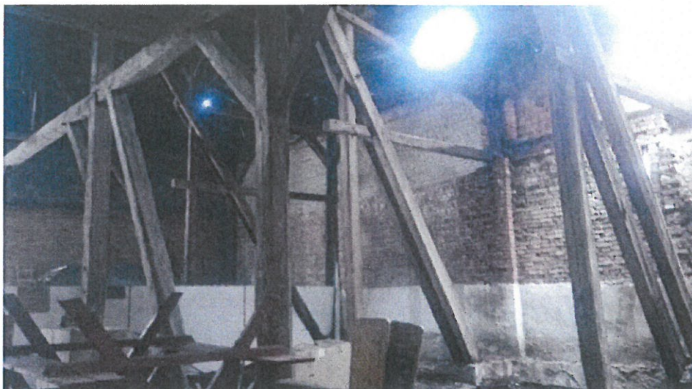
Fot.23. Stężenie słupów zastrzałami
