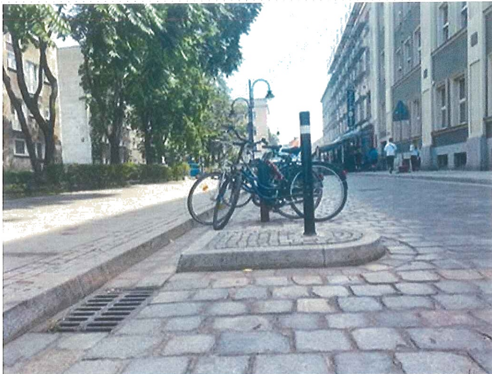
Fotografia 3 Pozostawienie przestrzeni dla odpływu wód opadowych w ul. Kotlarskiej
