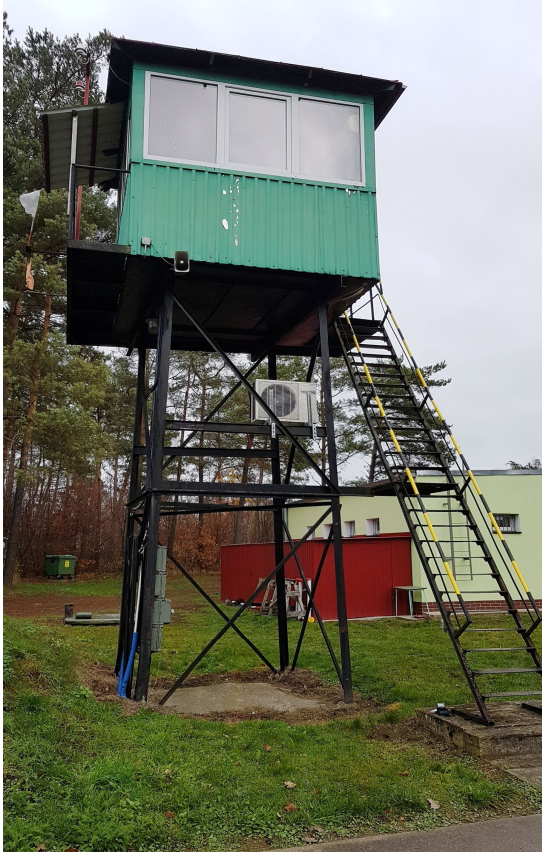
Fot.1. Ogólny widok wieży, kabiny dowodzenia i schodów wejściowych według stanu na dzień wizji lokalnej.
