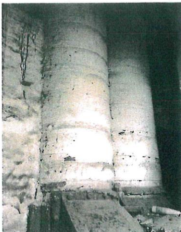
Fot. 4 Piwnica. Połączenie rur z czopuchem
