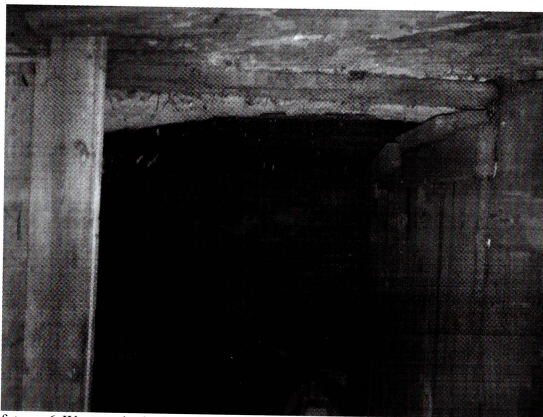
fot. nr 6 Wnętrze budynku oficyny mieszkalnej – piwnica – znaczne zużycie tego obszaru obiektu, występujące zawilgocenia oraz uszkodzenia elementów nośnych stropu piwnicy.
