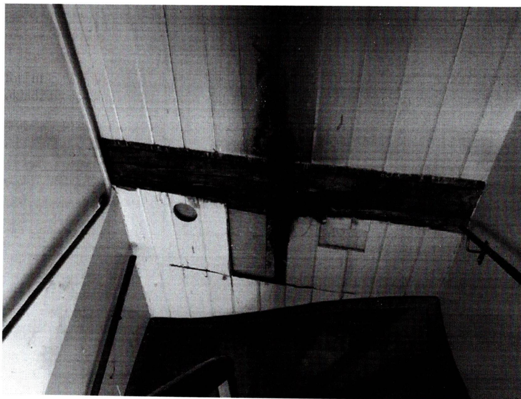
fot. nr 5 Wnętrze budynku oficyny mieszkalnej – klatka schodowa budynku – uszkodzone okładziny ścienne, naruszone wskutek pożaru elementy nośne budynku.
