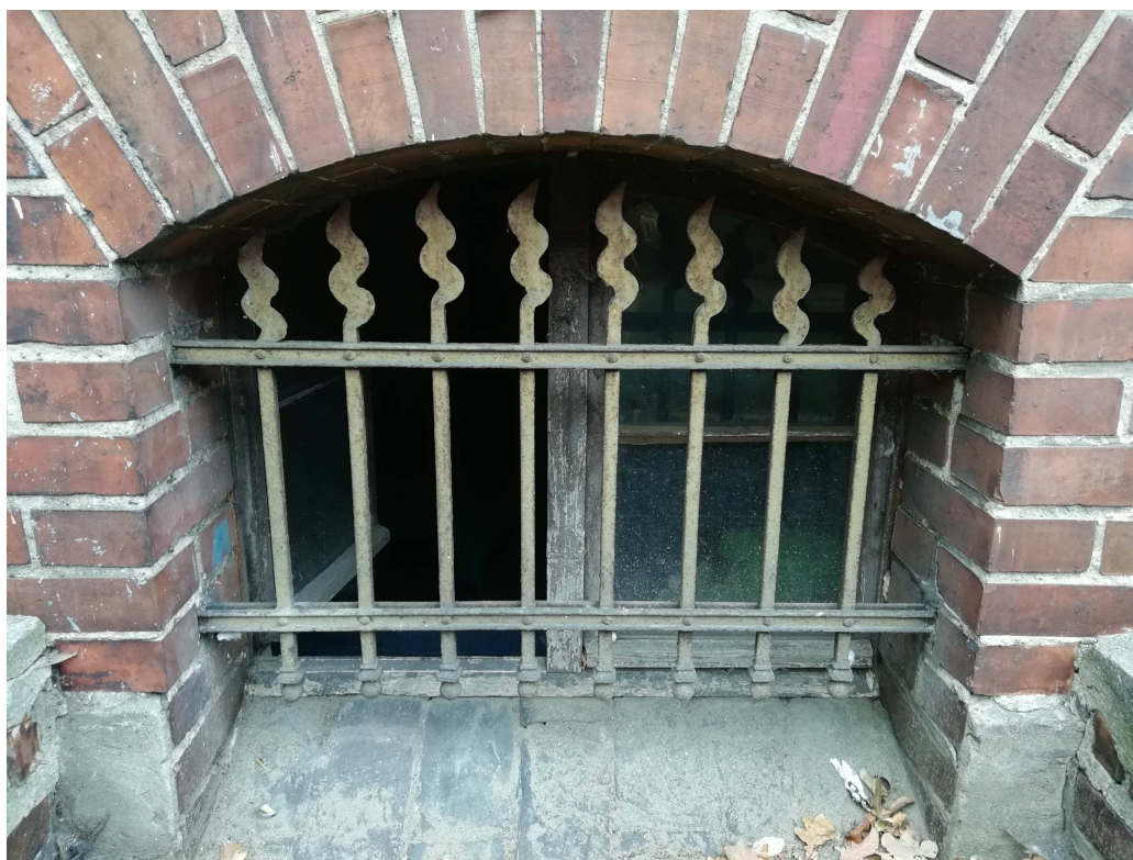
4.1. Krata pierwotna okna piwnicznego
