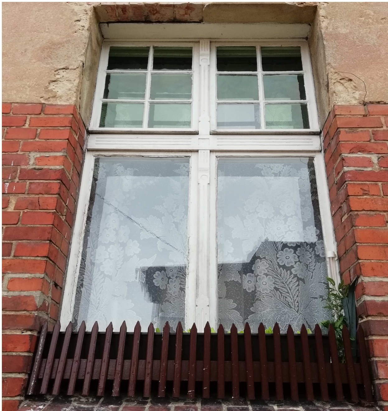
Widok okna historycznego pierwotnego
