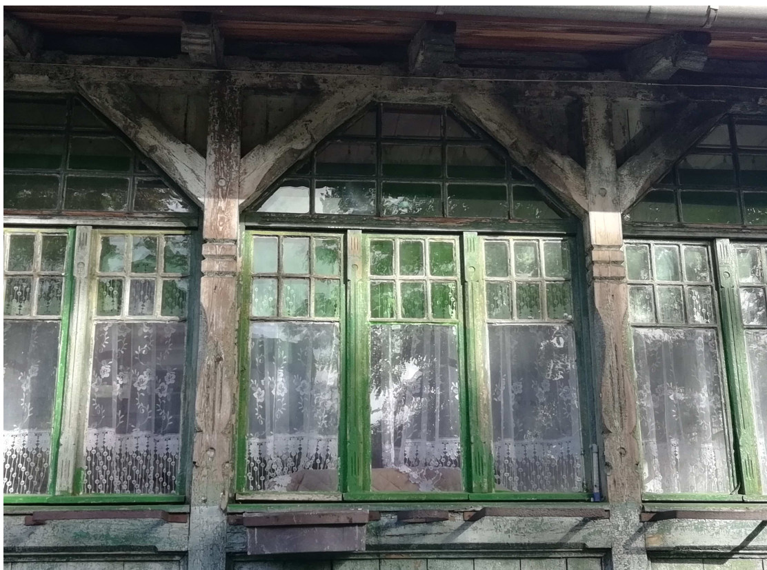
3.2. Widok profilowanych słupów, zastrzałów i przeszkleń altany
