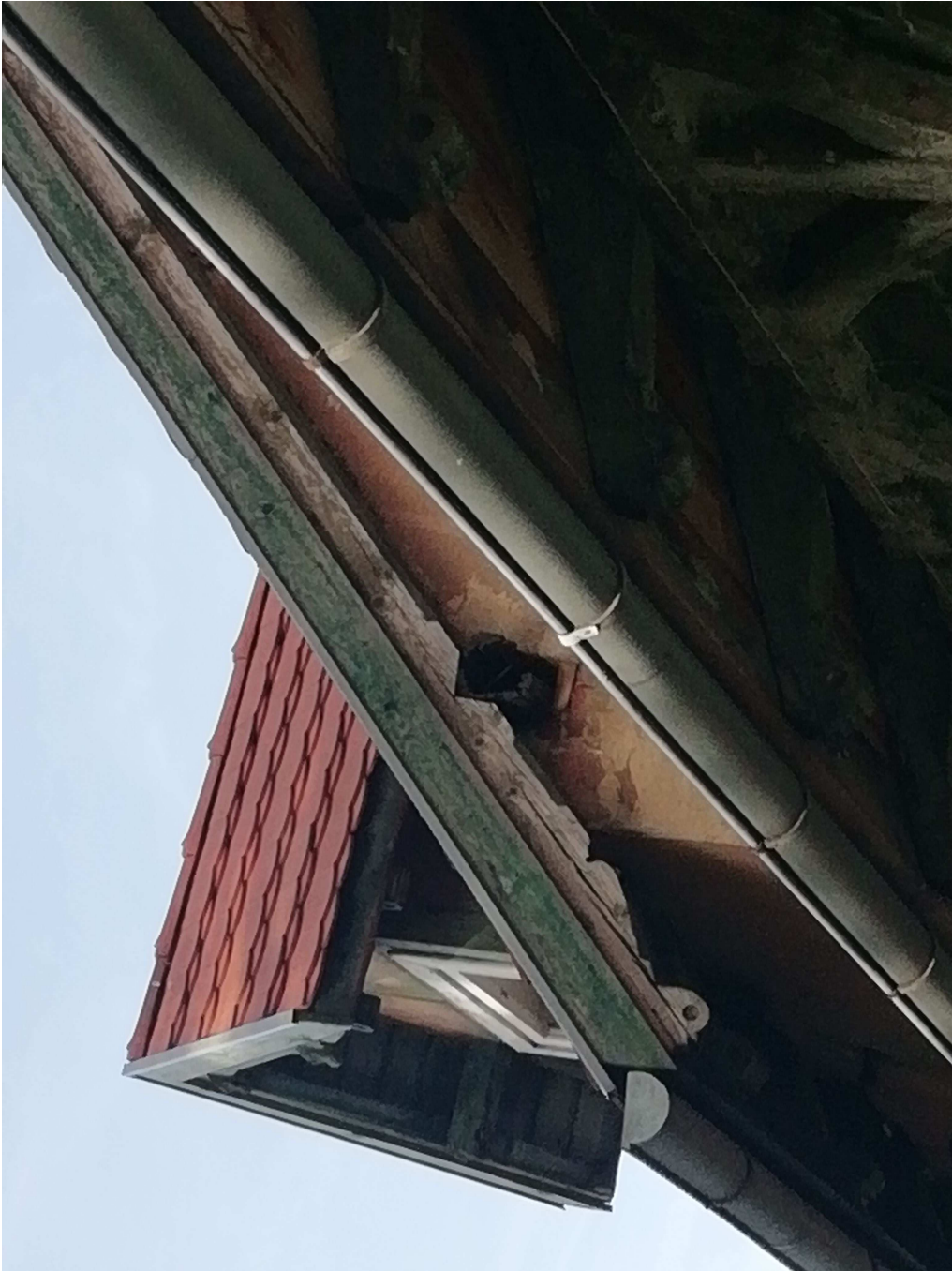
3.8. Historyczne zakończenia krokwi dachowych, odcinek murłaty do odtworzenia
