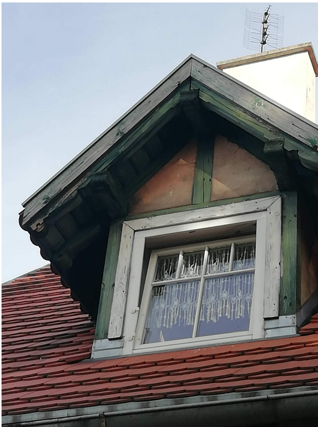
3.7. Widok detalu lukarny dachowej, historyczne, profilowane zakończenia krokwi, pierwotna kolorystyka podbitki okapów: zgaszona butelkowa zieleń
