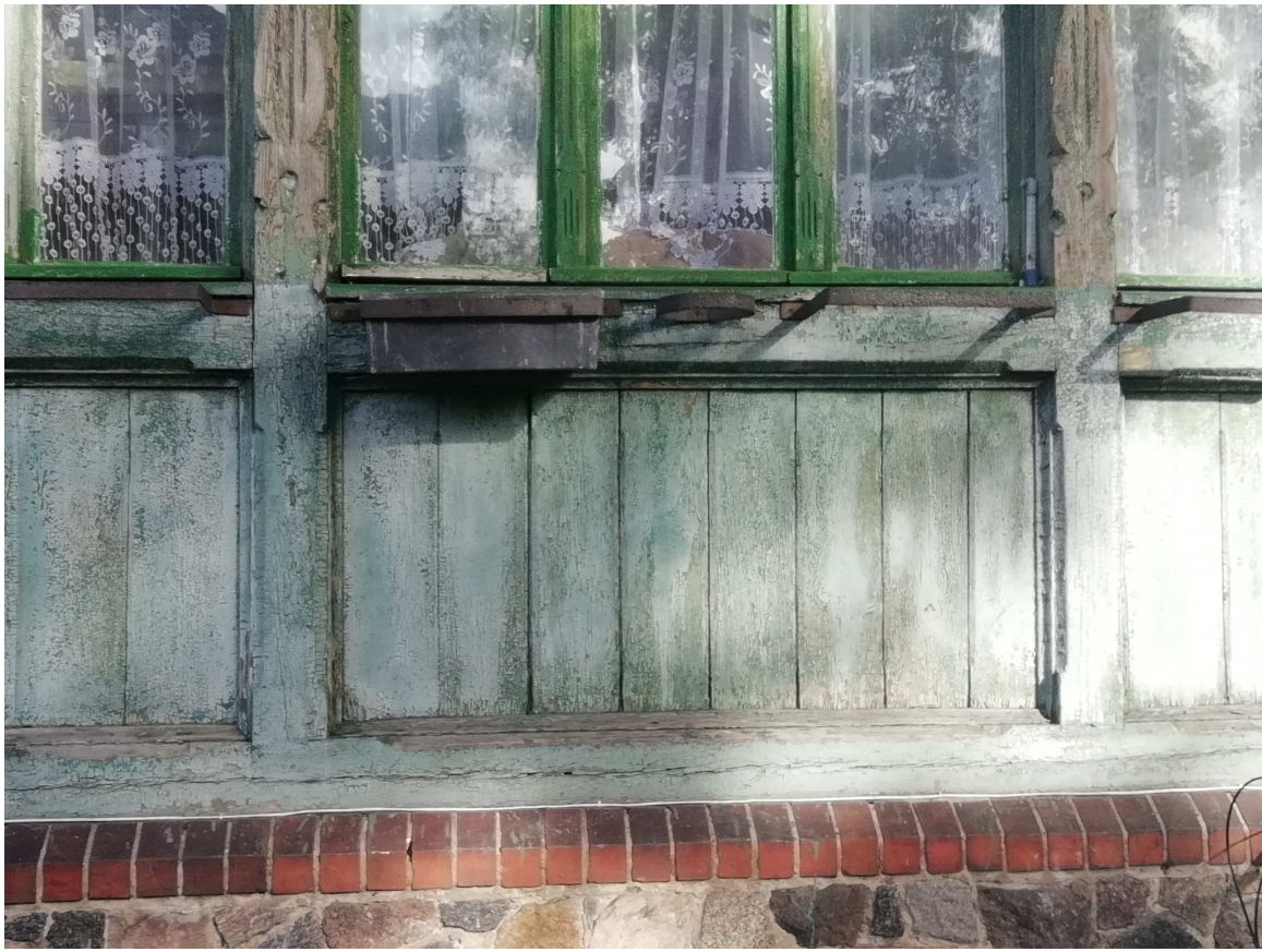
3.4. Widok dołu altany; dół słupów, deskowanie
