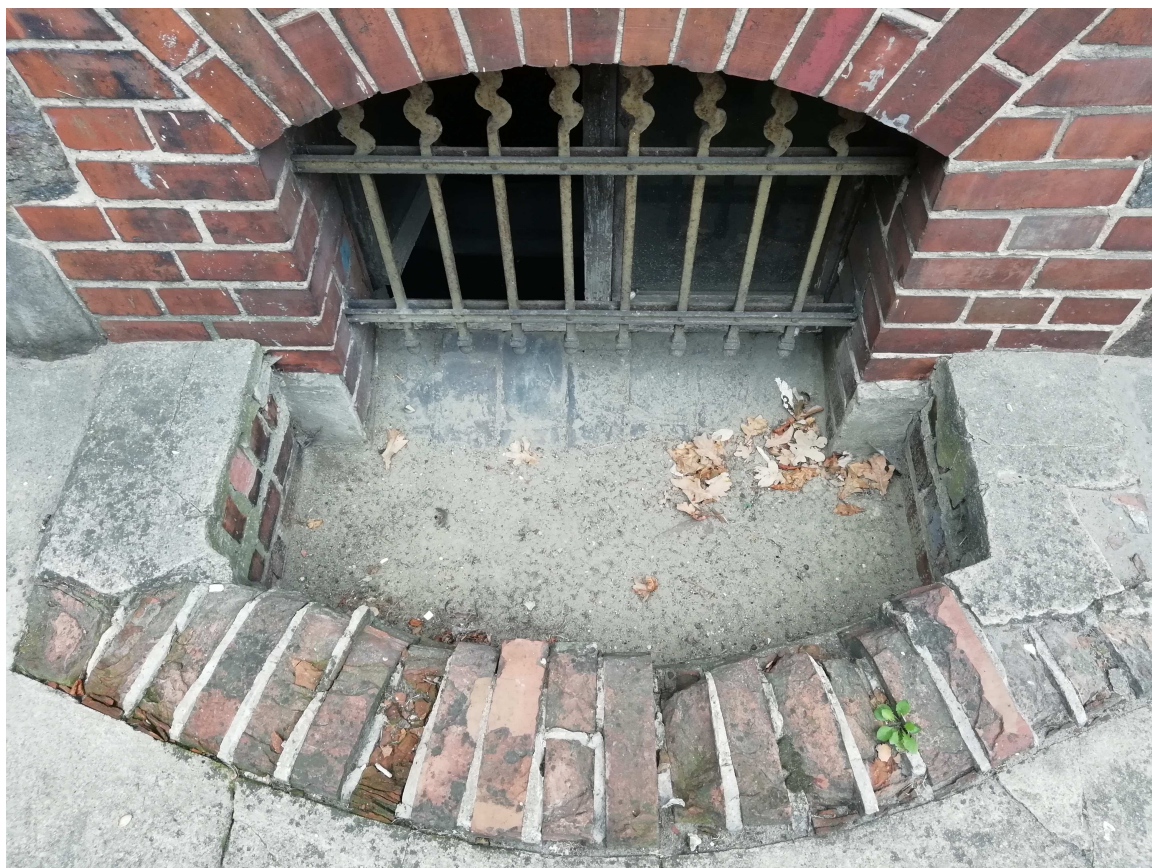
1.3. Istniejąca studnia okna piwnicznego.
