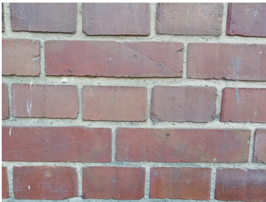
1.2. Istniejący wątek z cegły licowej i fuga piaskowo - wapienna pierwotna
