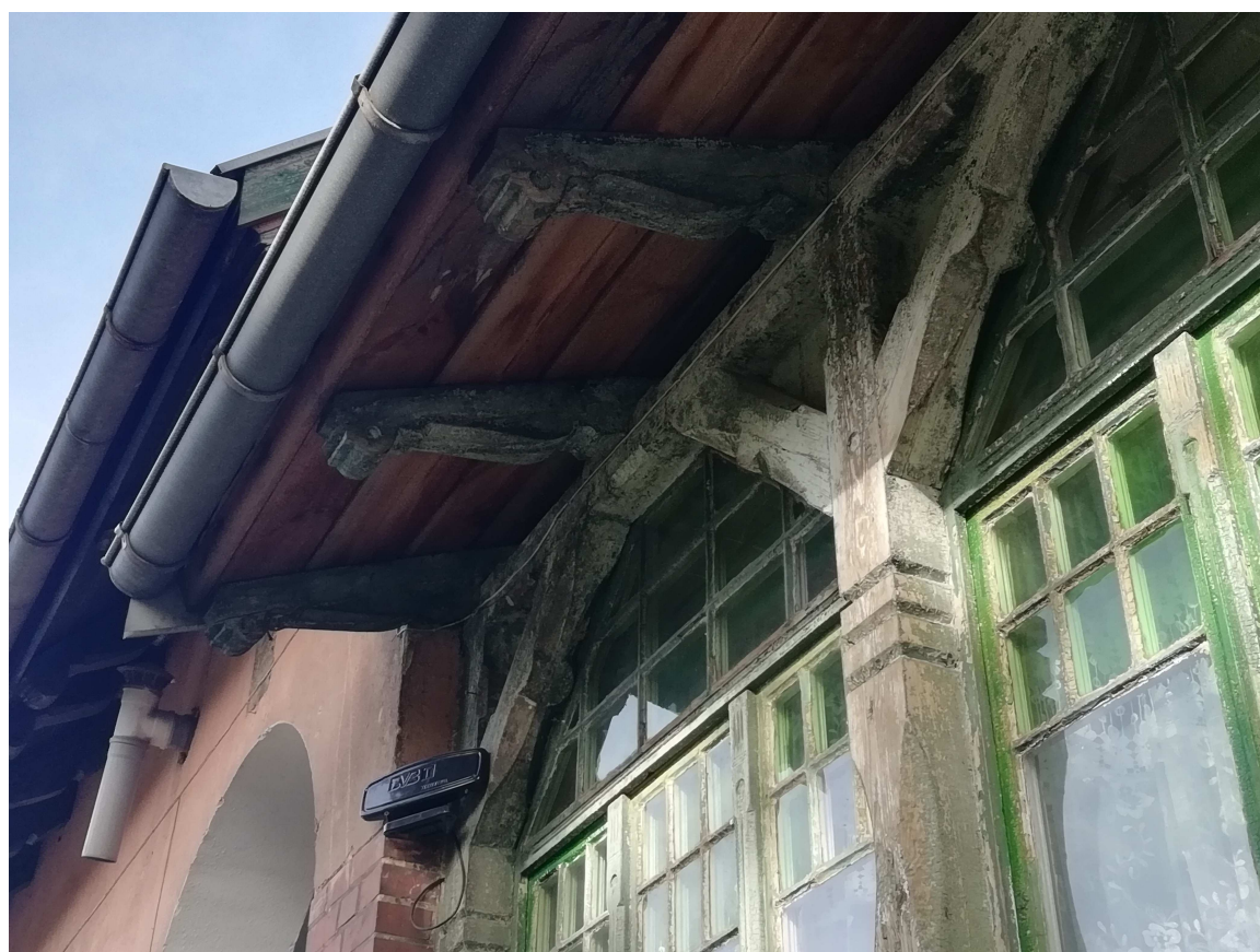
3.2. Widok profilowanych słupów, zastrzałów i przeszkleń altany
