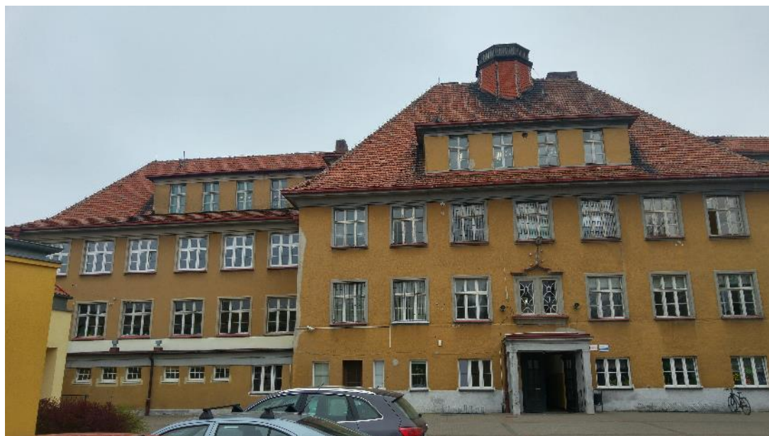
Fot.2 Ściana od podwórka.
