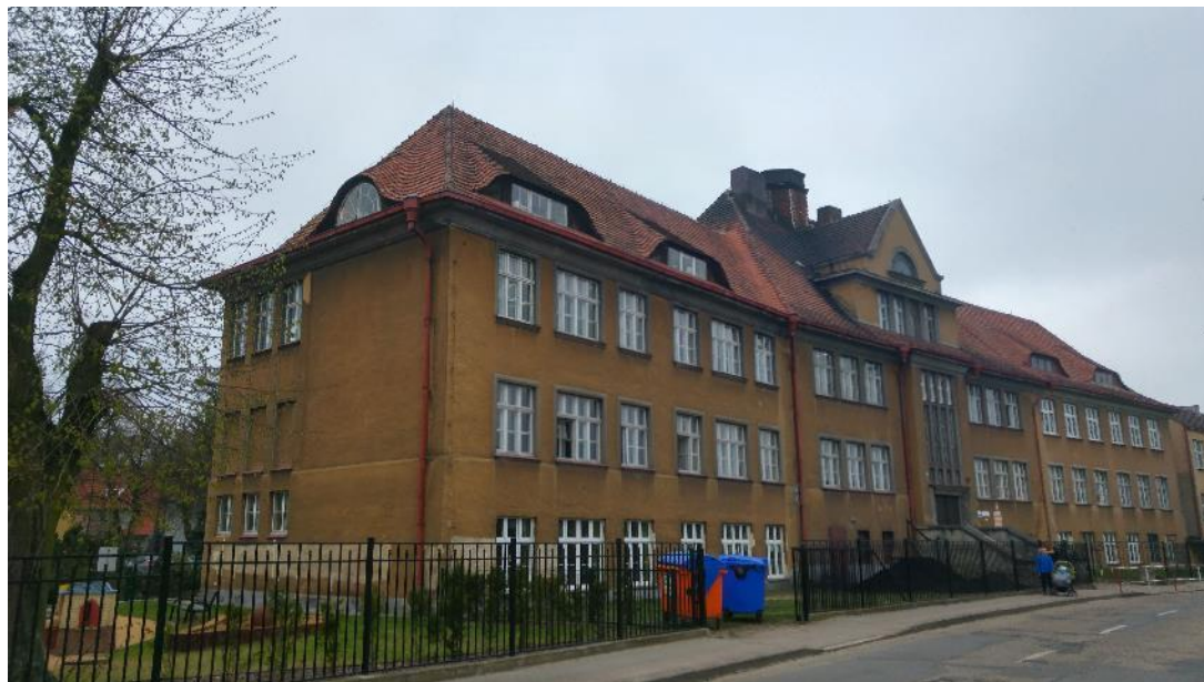
Fot.1 Fragment ściany frontowej Budynku A.
