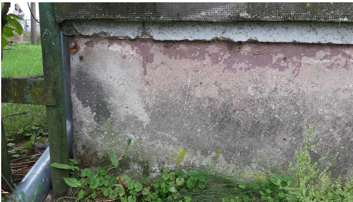
Fot. 7 Istniejące docieplenie nad cokółem
