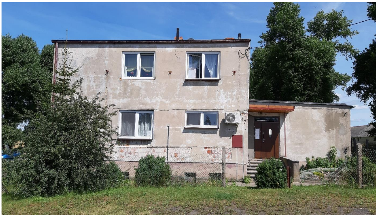
Fot. 1 Elewacja południowo – zachodnia (od strony ulicy)
