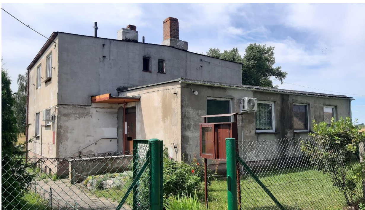
Fot. 2 Elewacja południowo – wschodnia
