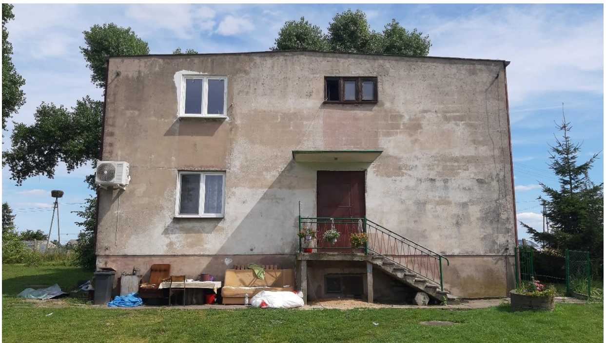
Fot. 6 Elewacja północno – zachodnia
