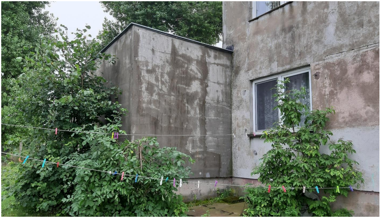
Fot. 5 Elewacja północno – zachodnia
