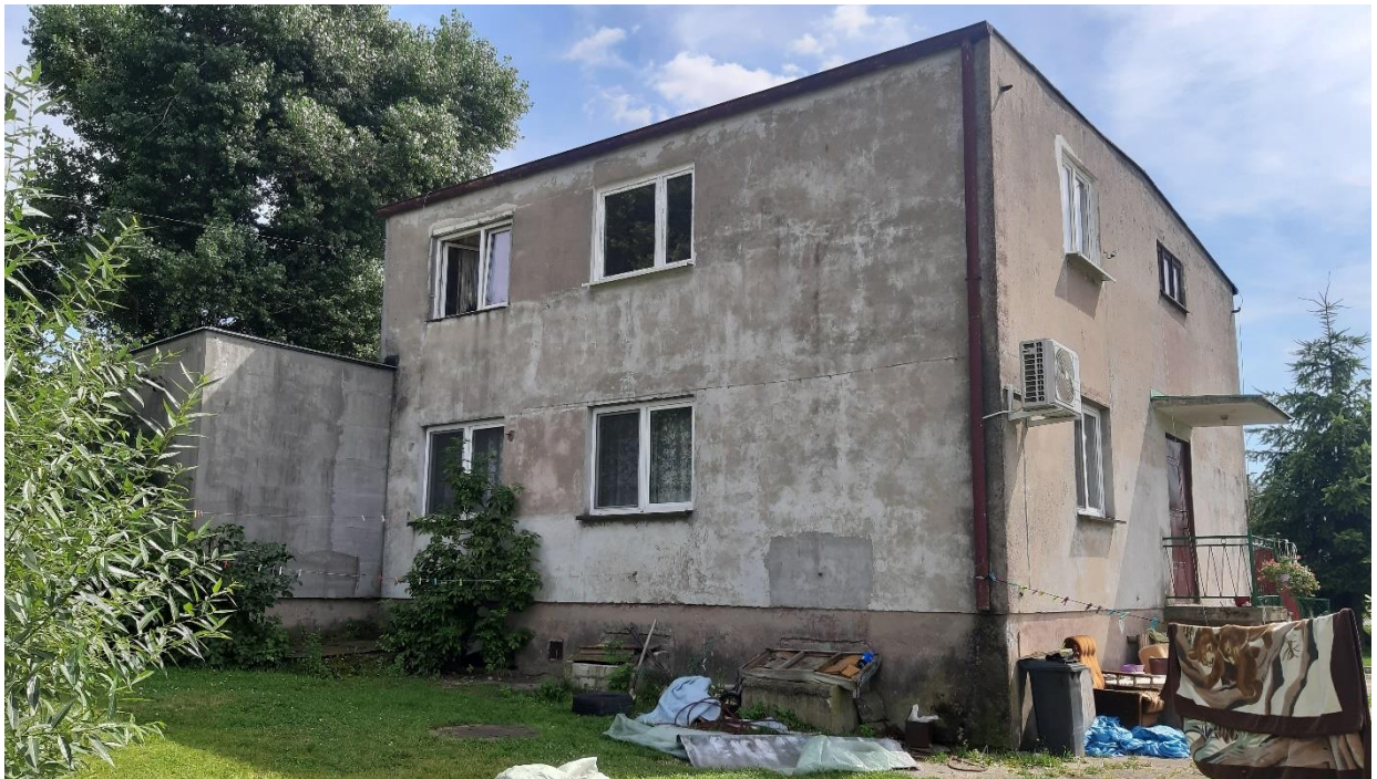
Fot. 4 Elewacja północno – wschodnia
