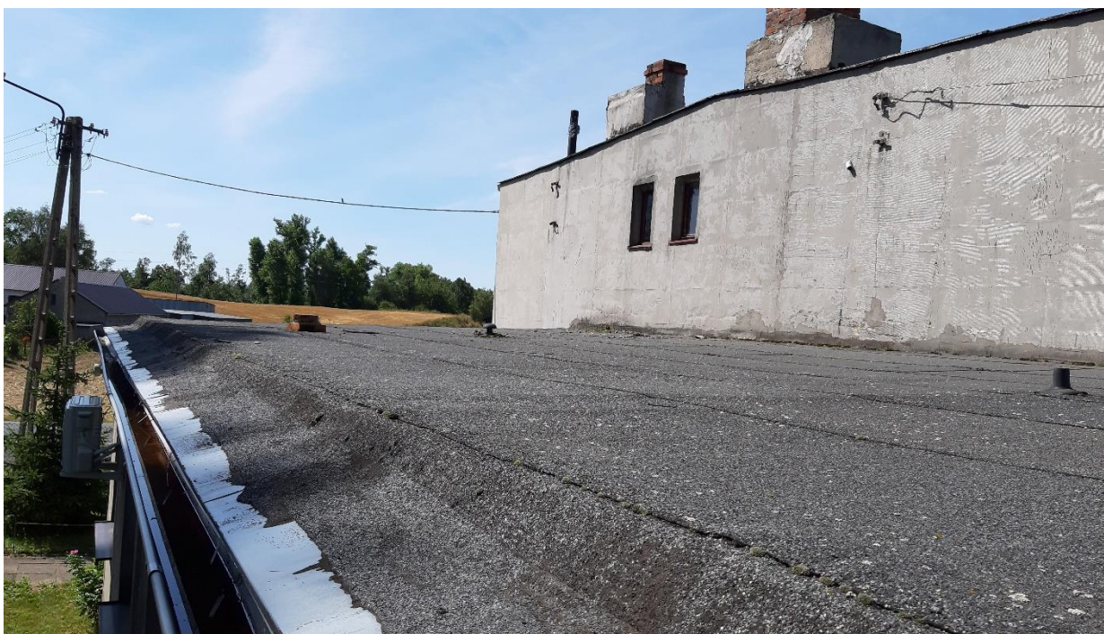
Fot. 8 Stropodach nad częścią parterową
