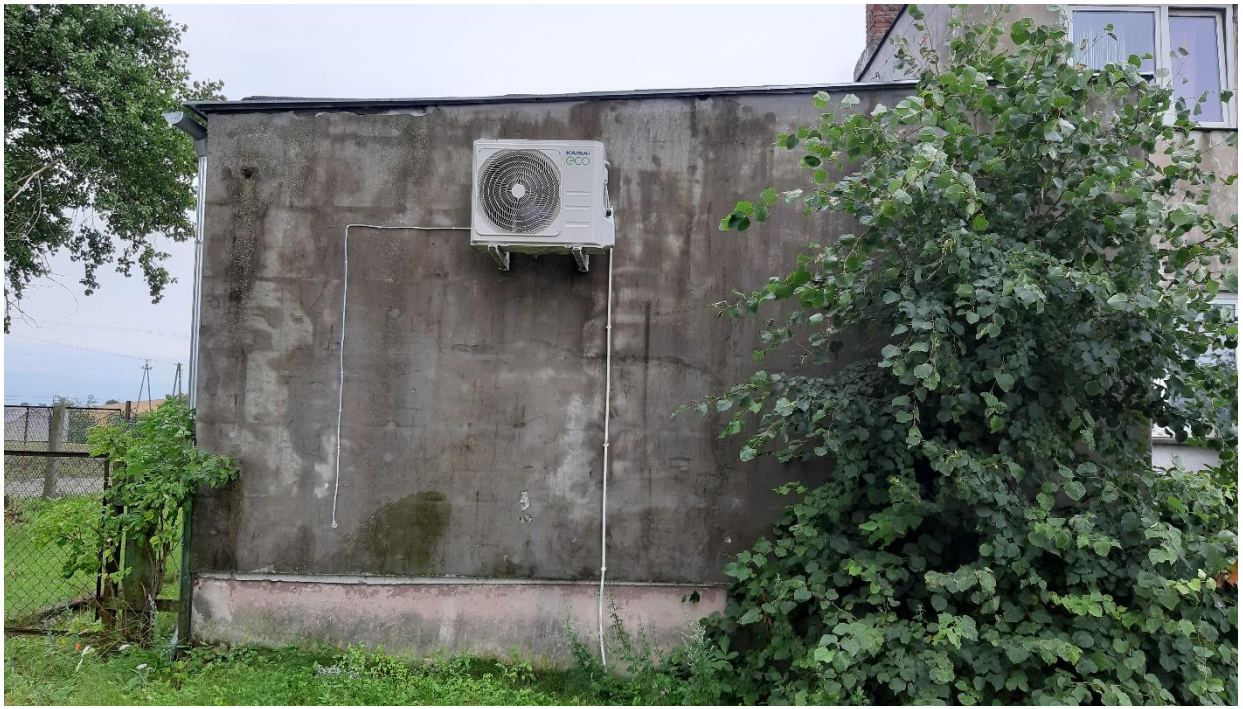
Fot. 3 Elewacja północno – wschodnia
