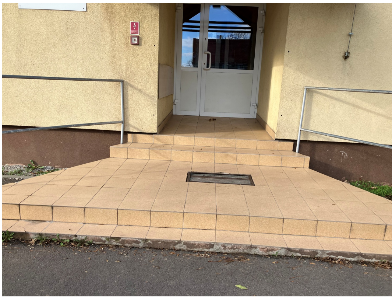
WEJŚCIE GŁÓWNE DO BUDYNKU – ELEWACJA WSCHODNIA
