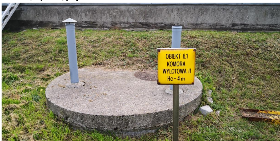
Fot. 10 Komora wylotowa
