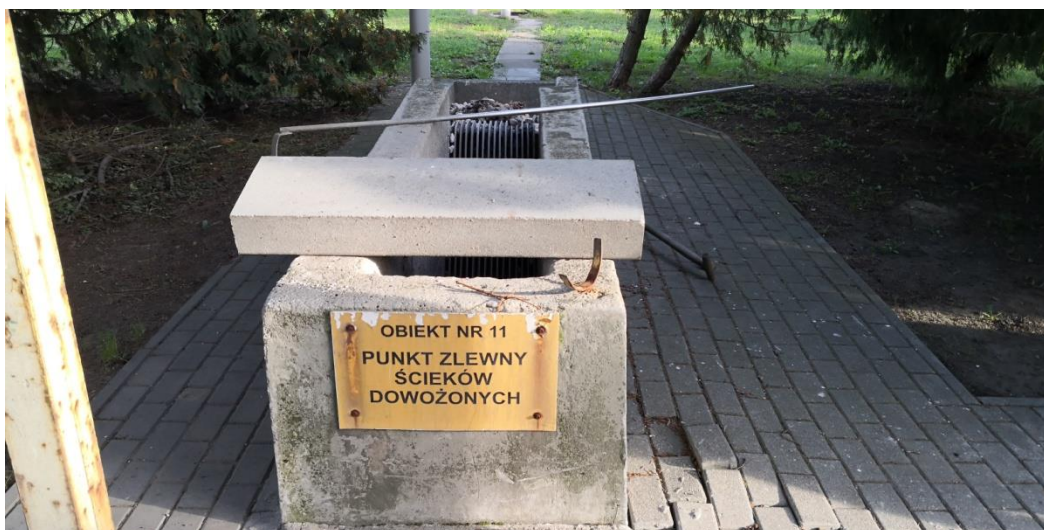
Fot. 2 Punkt zlewny ścieków dowożonych
