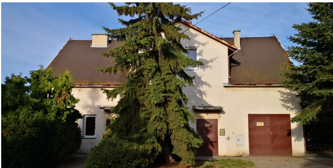
Fot. 19 Budynek socjalno - techniczny.
