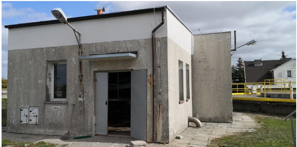
Fot. 4 Budynek mechanicznego oczyszczania ścieków
