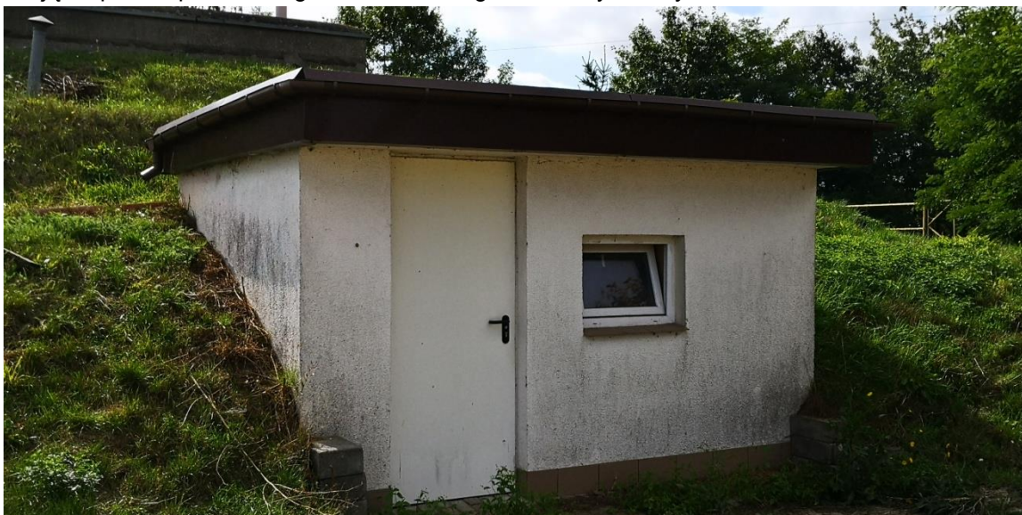
Fot. 11 Punkt pomiarowy ścieków oczyszczonych
