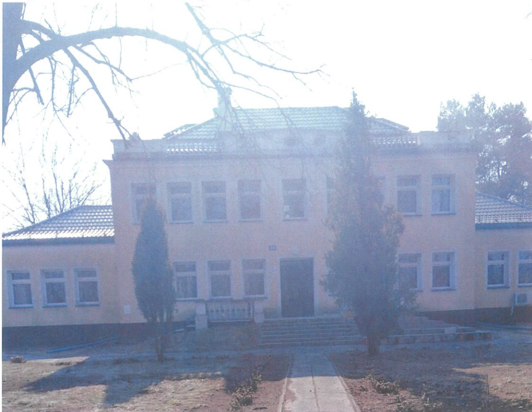
Fot. nr 1 – Elewacja północna.
