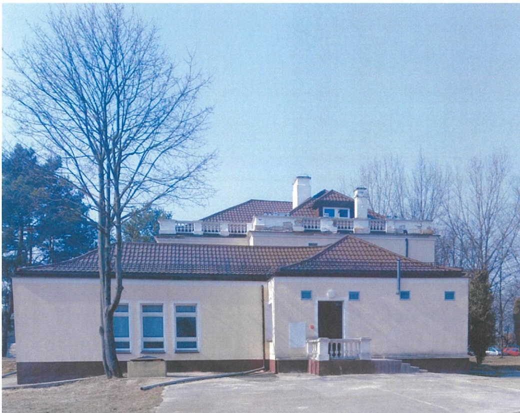
Fot. nr 2 – Elewacja wschodnia.
