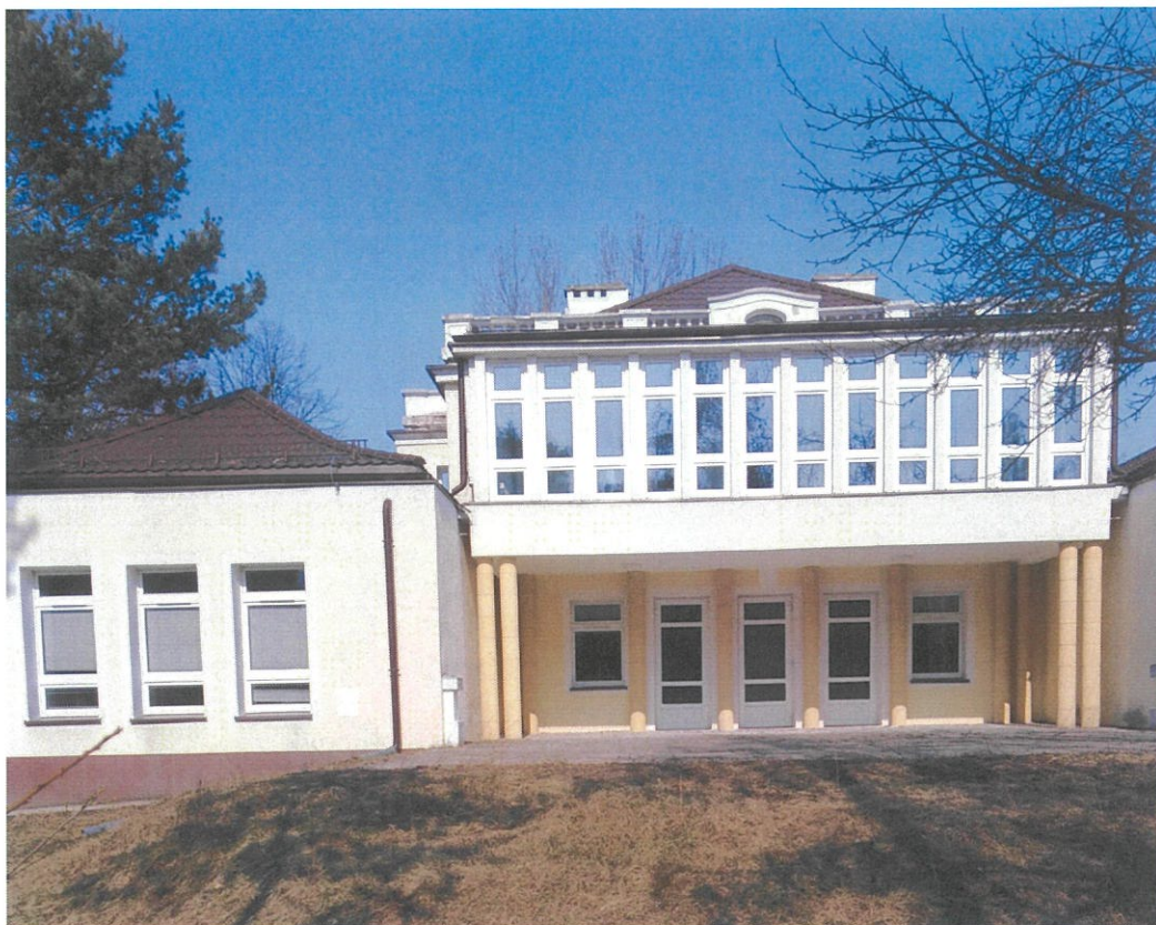
Fot. nr 3 – Elewacja południowa.
