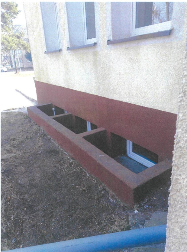
Fot. nr 6 – Studnie piwniczne.
