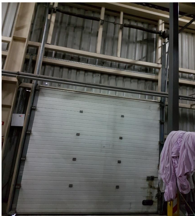
Zdj. 4. Zdjęcie ściany z bramą do częściowej rozbiórki od strony pom. kotłowni
