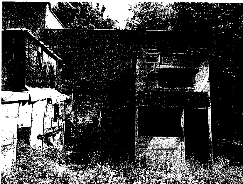
Fot. 3 Budynek przeznaczony do rozbiórki. Elewacja zachodnia
