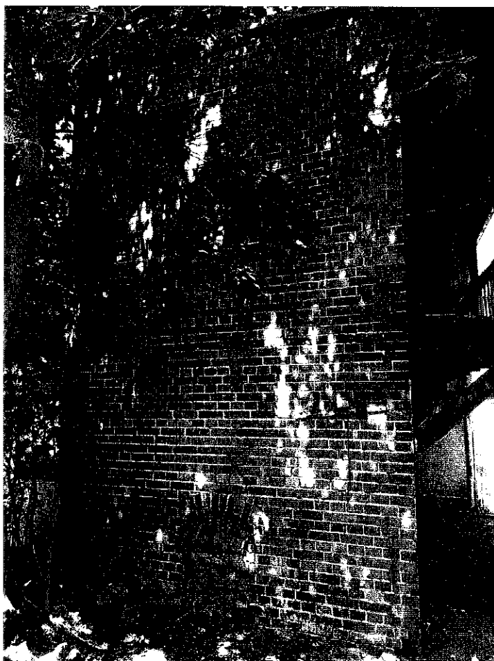
Fot. 2 Budynek przeznaczony do rozbiórki. Elewacja południowa.
