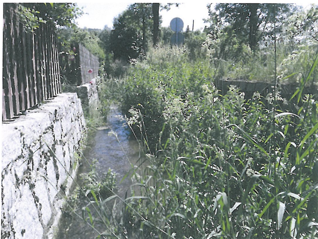
Koryto cieków Rochowicka Woda na odcinku planowanych prac
