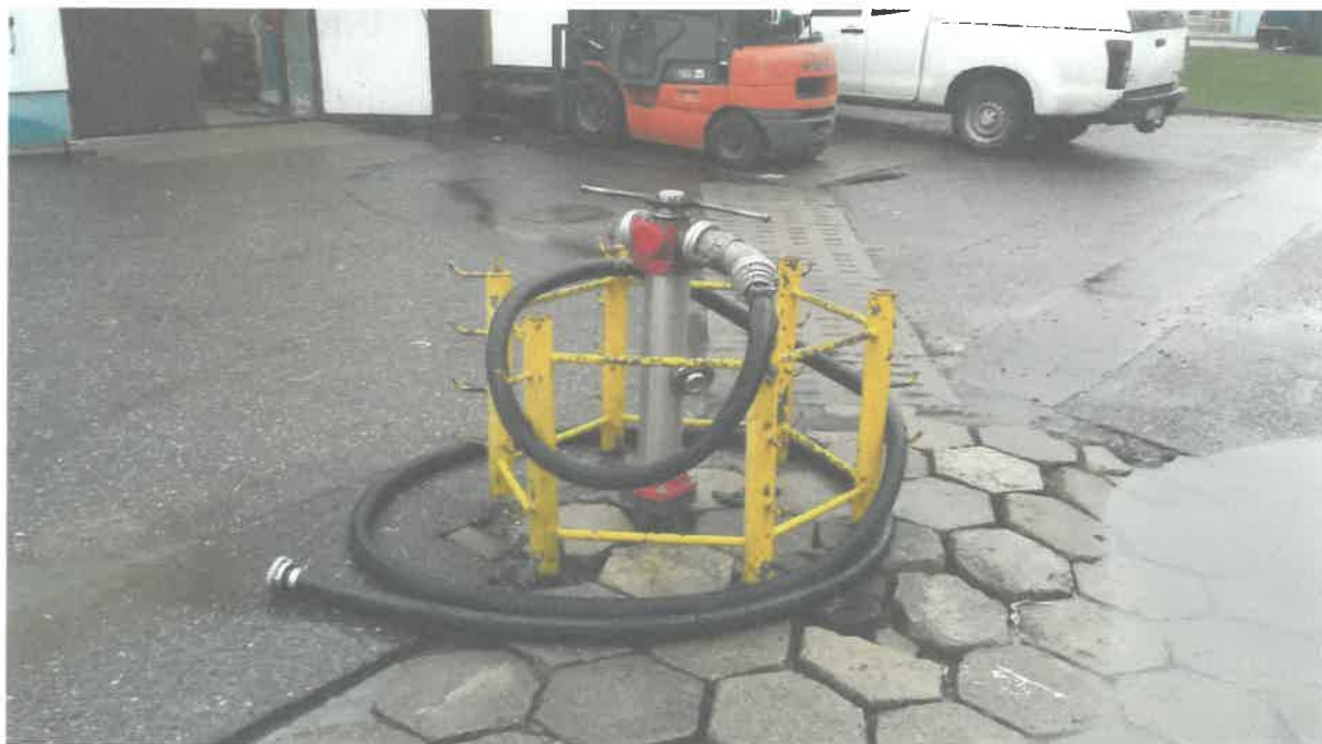
Zdjęcia 24. Hydrant podziemny przy budynku magazynowym, źródło: materiały własne
