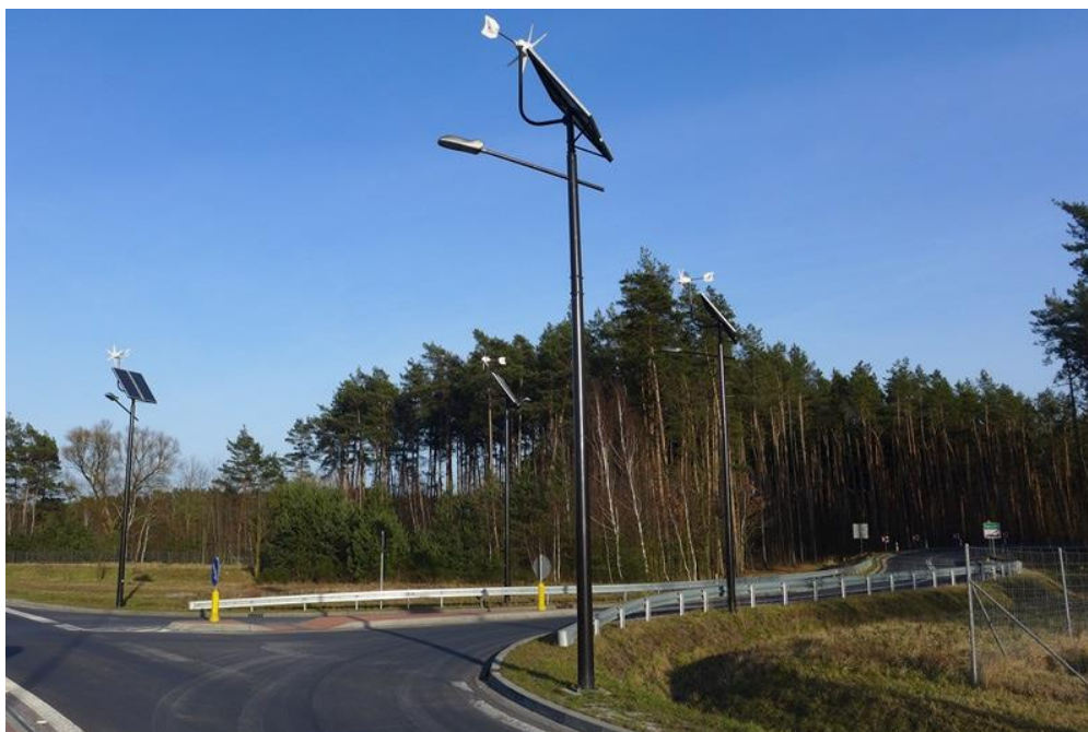
Zdjęcie 4 Oświetlenie z zasilaniem hybrydowym, źródło: https://www.lediko.com/realizacje-ogolny/58-oswietlenie-uliczne2/290-oswietlenie-hybrydowe-nowa-sol-polska
